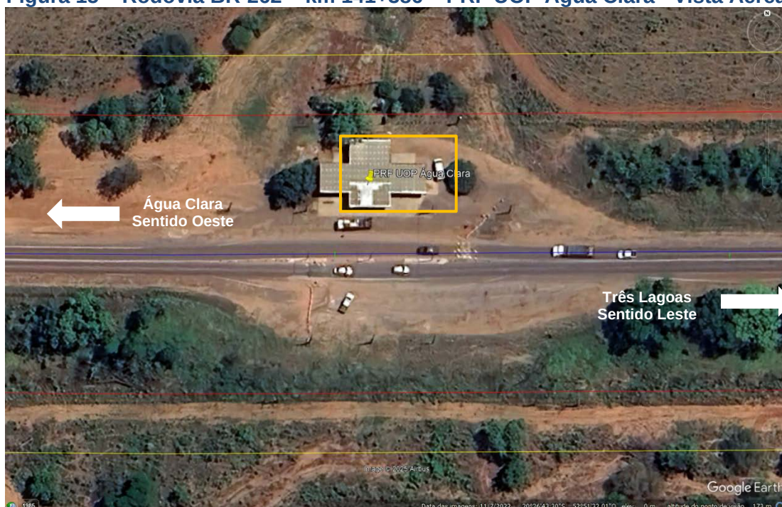
Figura 15 – Rodovia BR-262 – km 141+386 – PRF UOP Água Clara - Vista Aérea
