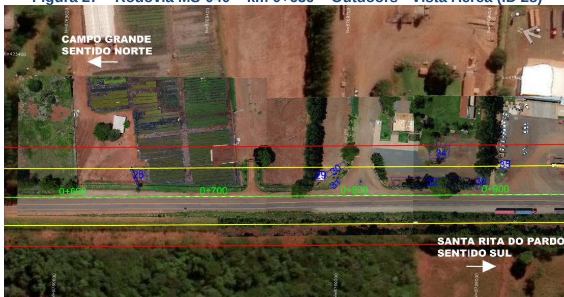
Figura 27 – Rodovia MS-040 – km 0+639 – Outdoors - Vista Aérea (ID 28)
