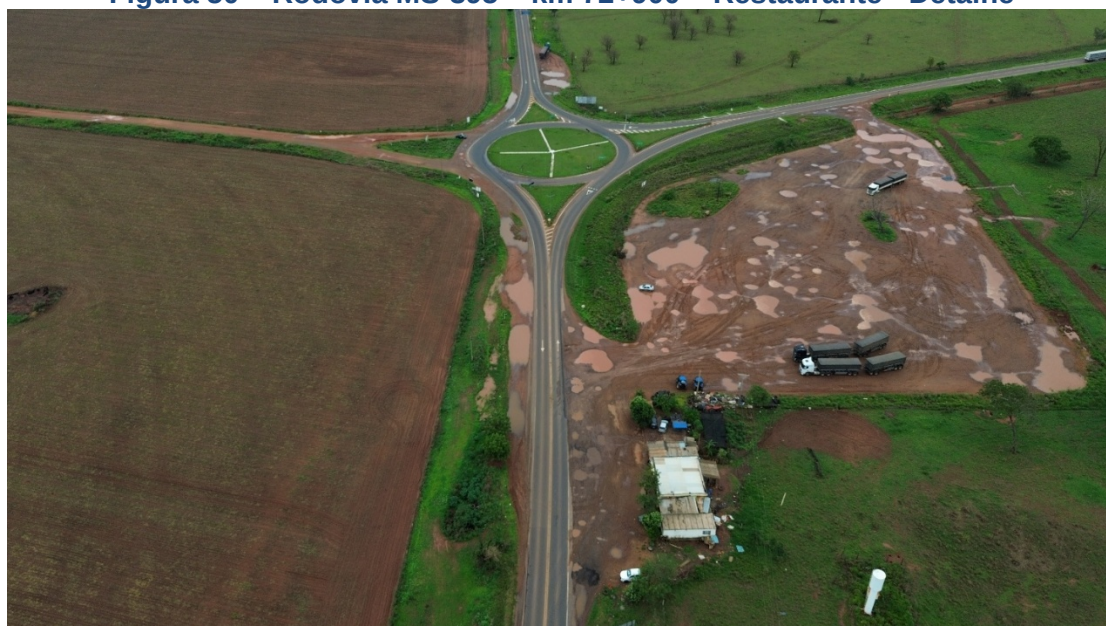
Figura 50 – Rodovia MS-395 – km 72+900 – Restaurante - Detalhe
