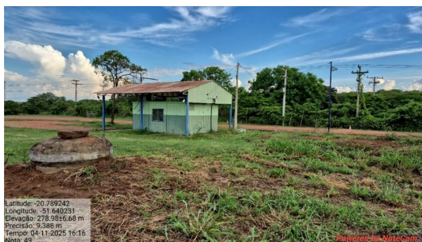
Figura 33 - Posto de Fiscalização Existente – BR-262 – km 2+100
