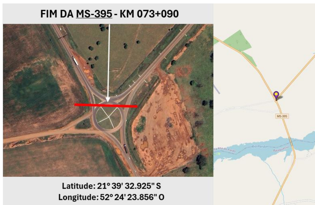
Figura 10 - Limite da Concessão – MS-395 – KM 073+090 (Bataguassu)
