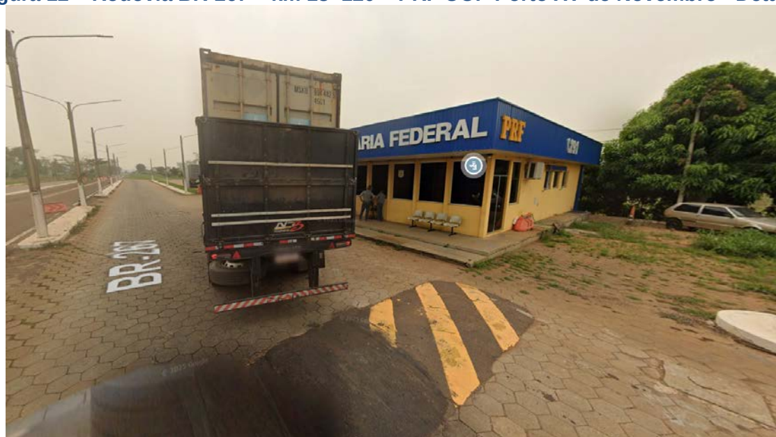
Figura 12 – Rodovia BR-267 – km 18+120 – PRF UOP Porto XV de Novembro - Detalhe
