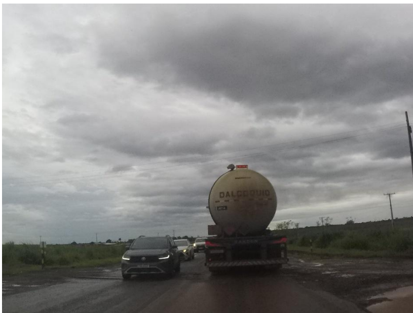
Figura 32 - Passagem de Nível – Km 304+562
