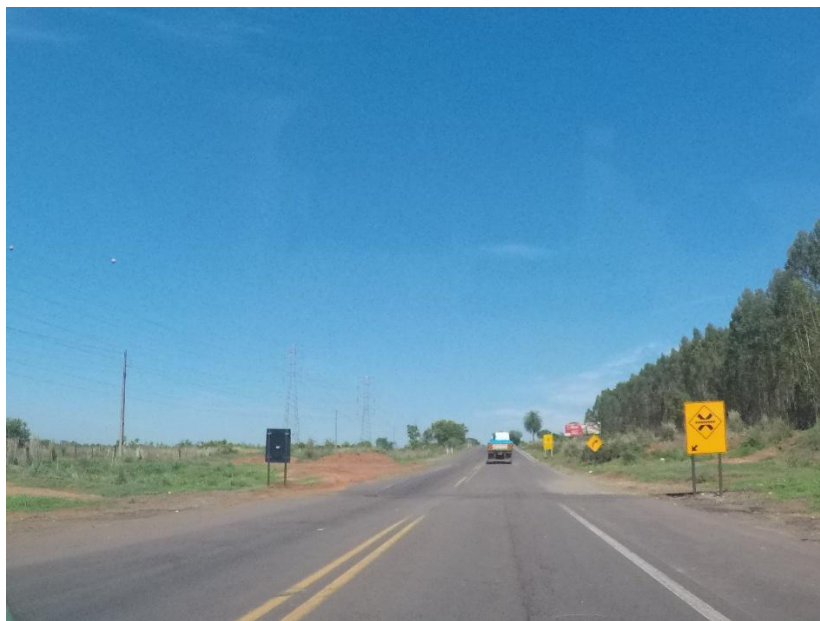
Figura 30 - Passagem de Nível – Km 134+112
