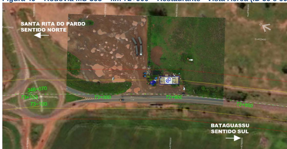
Figura 49 – Rodovia MS-395 – km 72+900 – Restaurante - Vista Aérea (ID 59 e 60)
