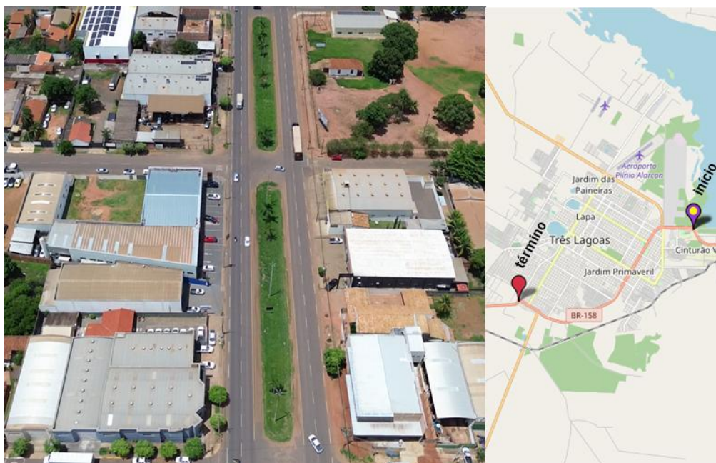
Figura 42 - Foto Aérea da Travessia de Três Lagoas – BR-267
