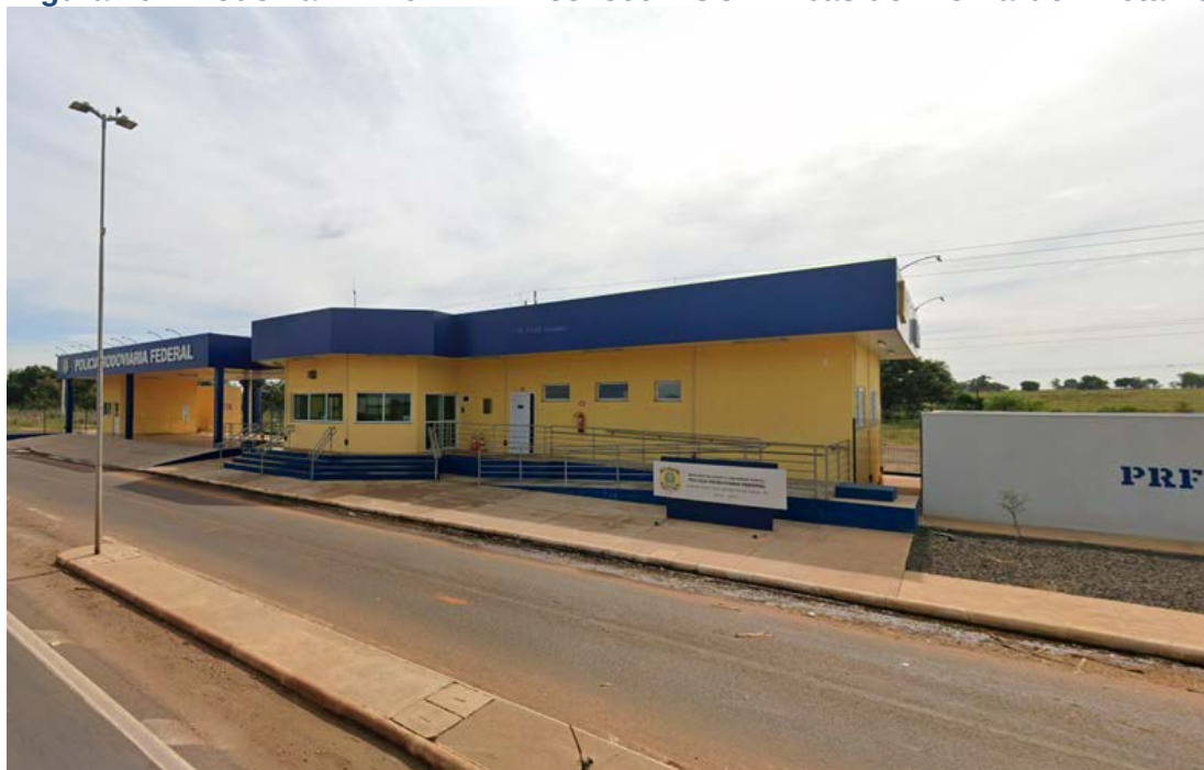
Figura 10 – Rodovia BR-262 – km 233+800 – UOP Ribas do Rio Pardo - Detalhe
