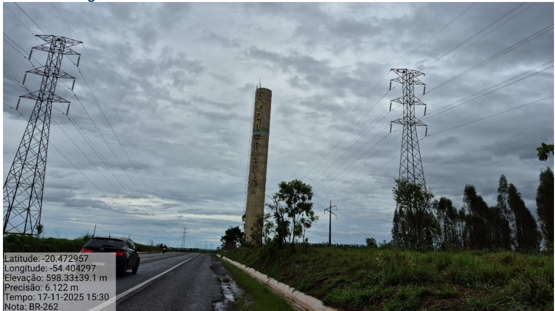
Figura 66 – Rodovia BR-262 – km 312+090 – Torre - Detalhe
