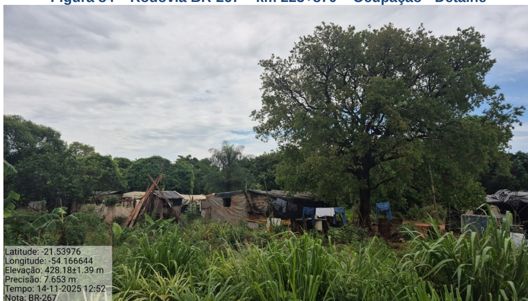
Figura 84 – Rodovia BR-267 – km 223+870 – Ocupação - Detalhe
