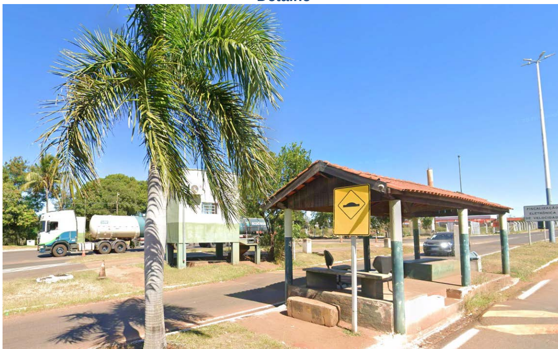
Figura 20 – Rodovia BR-262 – km 4+511 – Estruturas, árvores e pontos de caminhão - Detalhe
