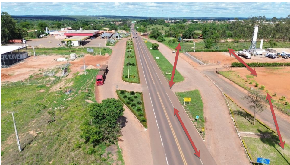
Figura 25 - Via Marginal – BR-262 – Água Clara - km 142+000 ao km 142+400
