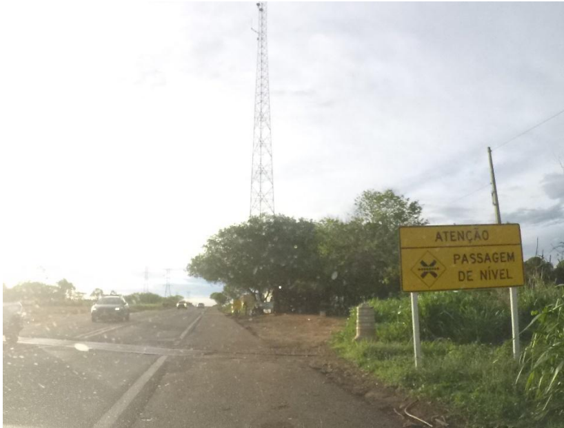
Figura 28 - Passagem de Nível – Km 036+054
