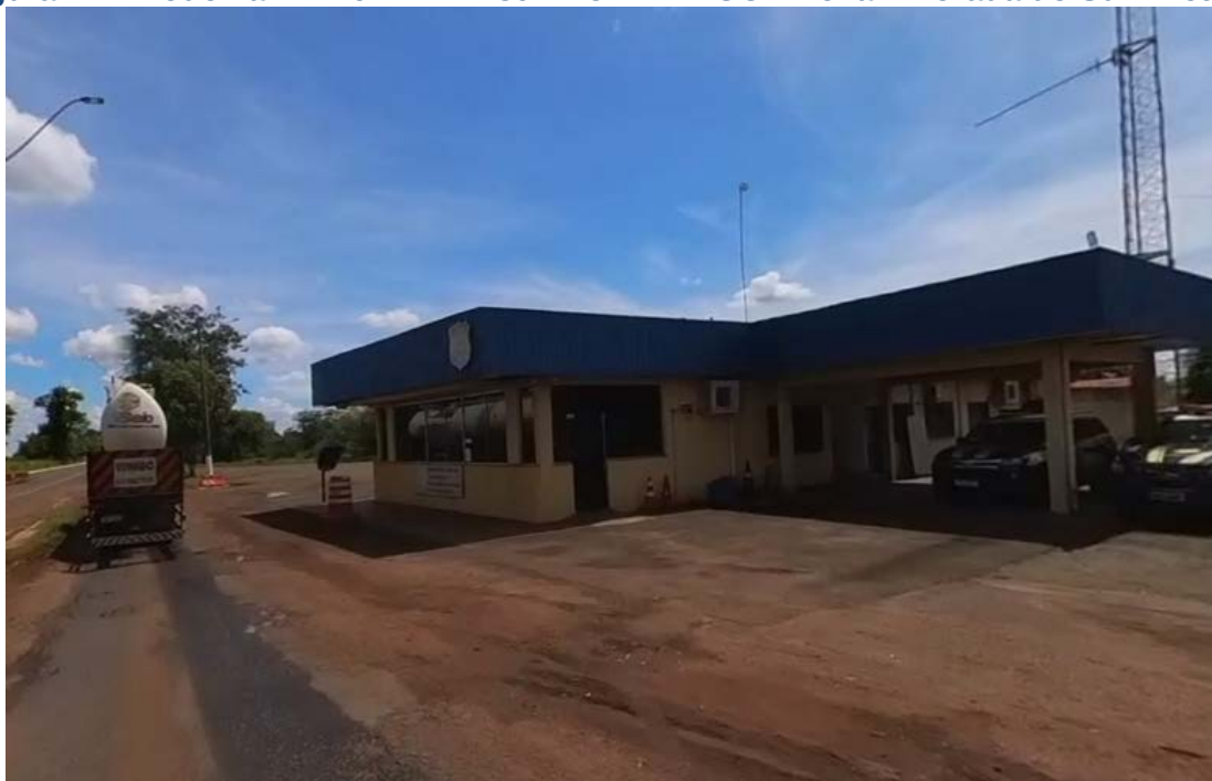
Figura 14 – Rodovia BR-267 – km 239+415 – PRF UOP Nova Alvorada do Sul - Detalhe
