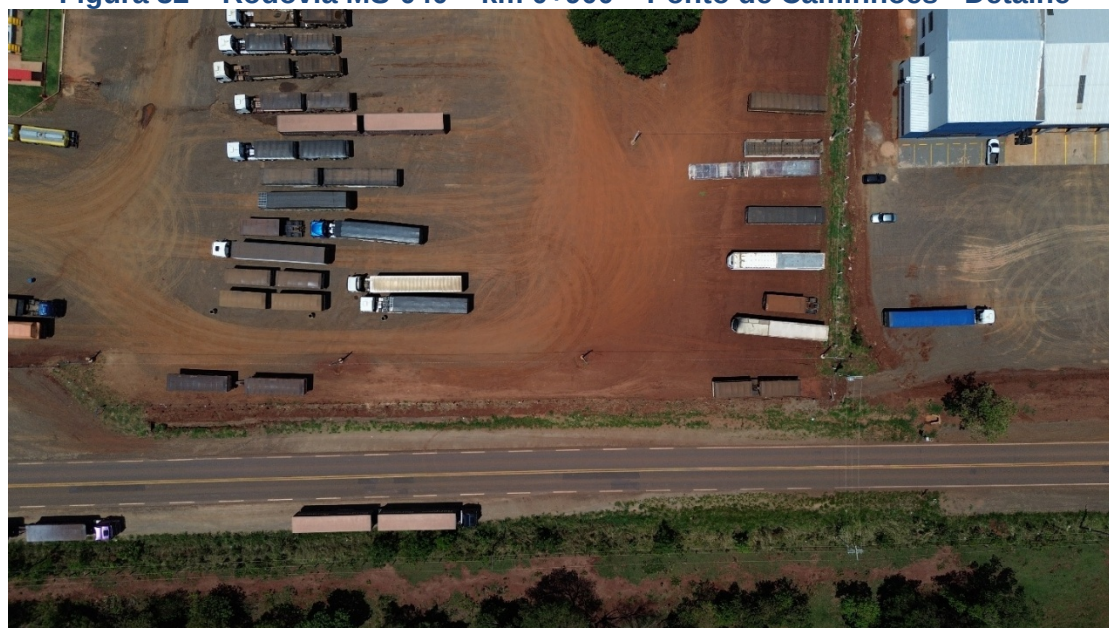
Figura 32 – Rodovia MS-040 – km 0+900 – Ponto de Caminhões - Detalhe
