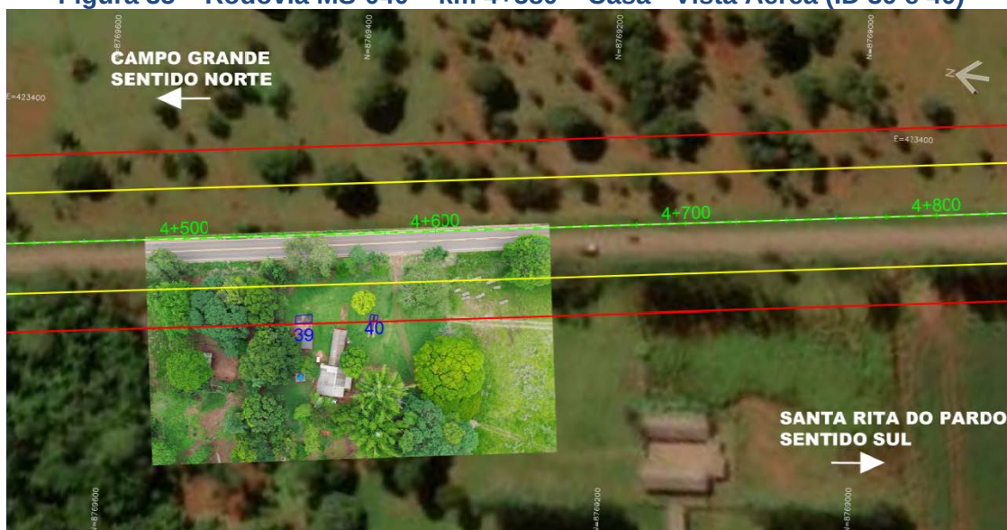
Figura 35 – Rodovia MS-040 – km 4+580 – Casa - Vista Aérea (ID 39 e 40)
