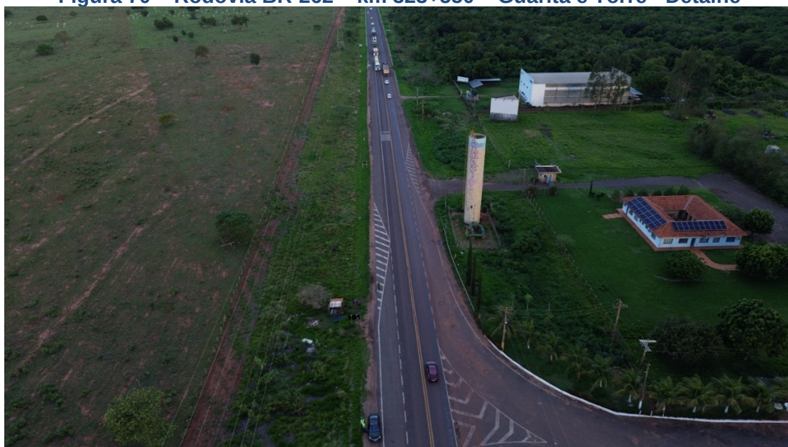
Figura 70 – Rodovia BR-262 – km 323+550 – Guarita e Torre - Detalhe
