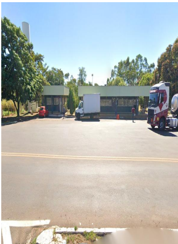
Figura 34 - Posto de Fiscalização Existente – BR-262 – km 4+500
