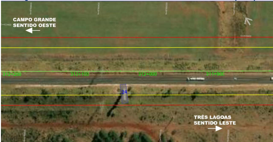
Figura 65 – Rodovia BR-262 – km 312+090 – Torre - Vista Aérea (ID 24)
