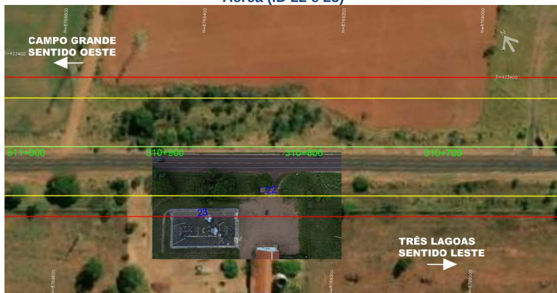
Figura 25 – Rodovia BR-262 – km 310+875 – Ponto de Distribuição de Energia - Vista Aérea (ID 22 e 23)
