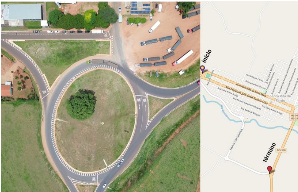
Figura 46 - Foto Aérea da Travessia de Santa Rita do Pardo – MS-040
