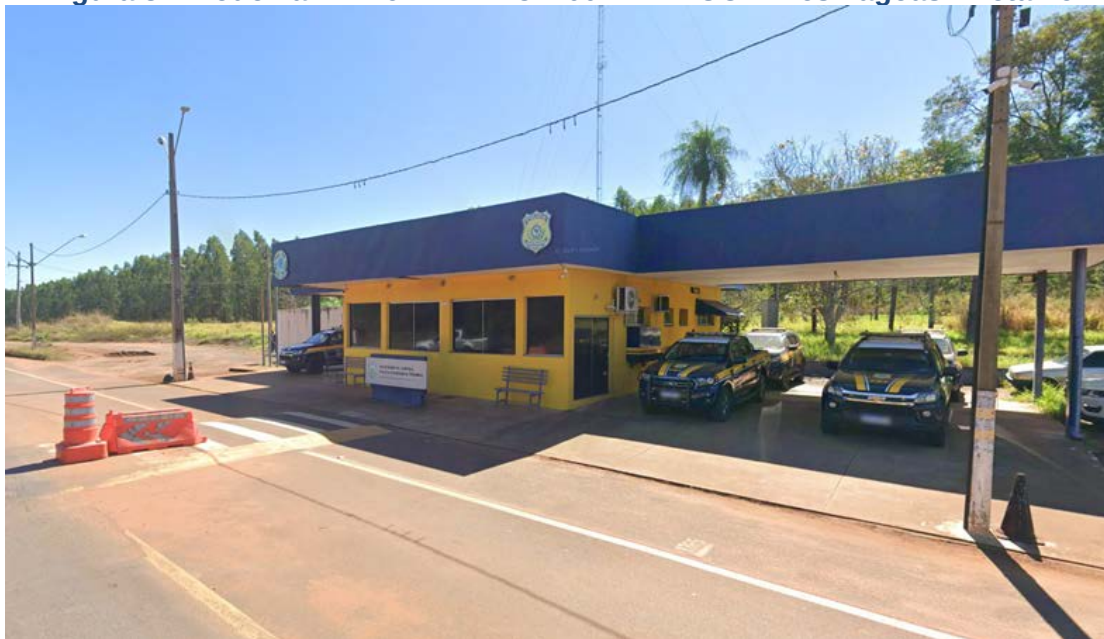
Figura 8 – Rodovia BR-262 – km 23+200 – PRF UOP Três Lagoas - Detalhe
