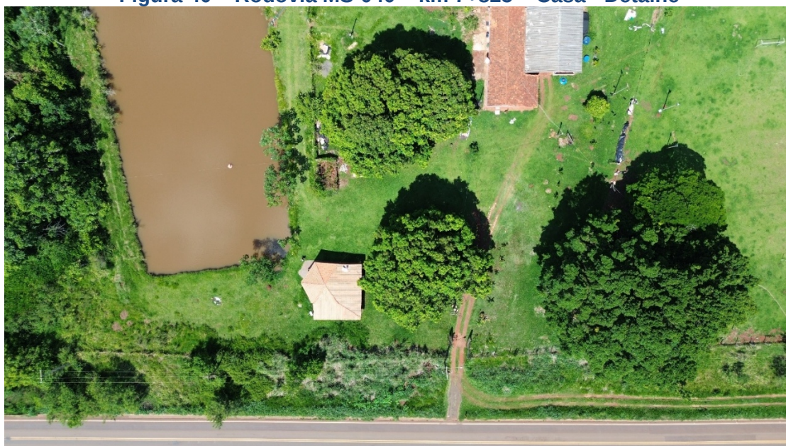
Figura 40 – Rodovia MS-040 – km 7+825 – Casa - Detalhe
