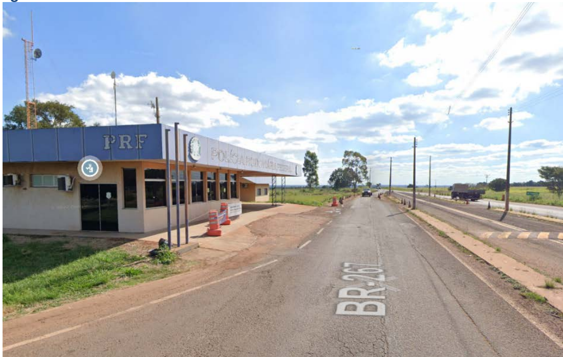
Figura 18 – Rodovia BR-267 – km 128+540 – PRF UOP Nova Casa Verde - Detalhe
