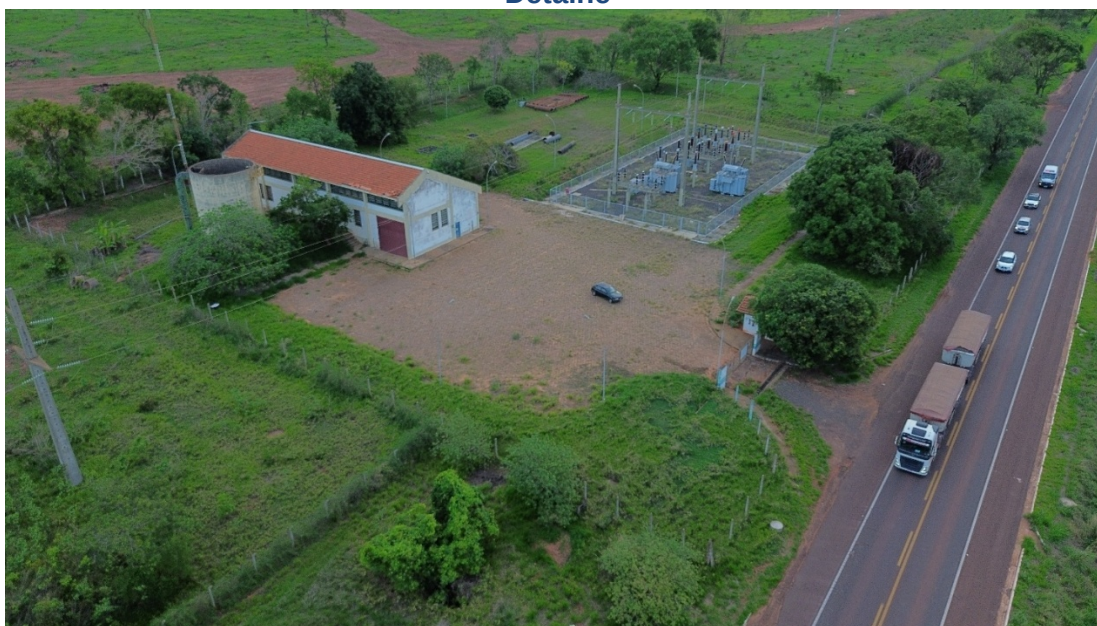
Figura 26 – Rodovia BR-262 – km 310+875 – Ponto de Distribuição de Energia - Detalhe
