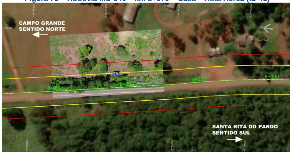
Figura 73 – Rodovia MS-040 – km 8+079 – Casa - Vista Aérea (ID 43)
