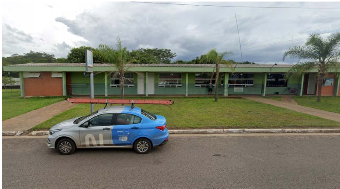
Figura 6 – Rodovia BR-267 – km 11+800 – Posto de Fiscalização XV de Novembro - Detalhe
