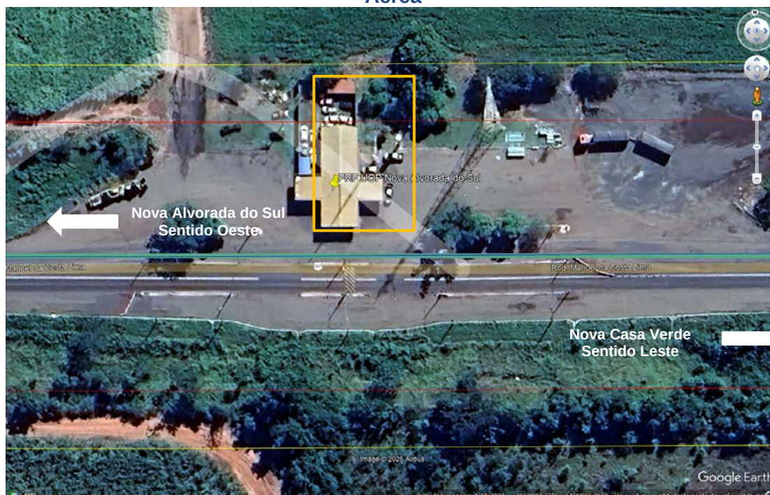
Figura 13 – Rodovia BR-267 – km 239+415 – PRF UOP Nova Alvorada do Sul - Vista Aérea
