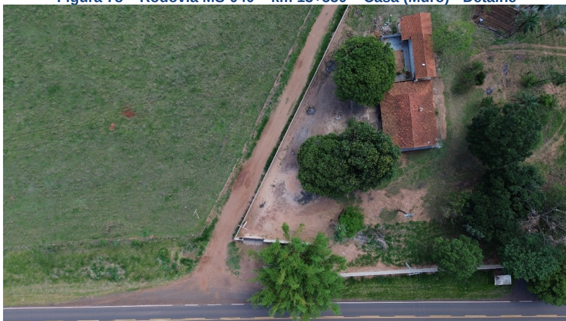
Figura 78 – Rodovia MS-040 – km 13+550 – Casa (Muro) - Detalhe
