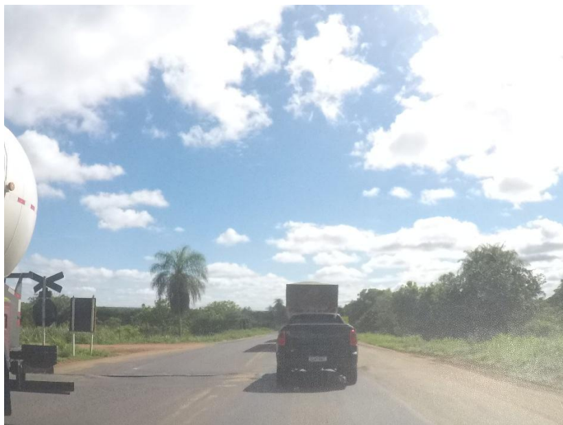
Figura 31 - Passagem de Nível – Km 146+719
