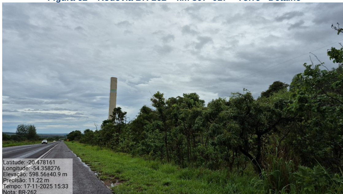
Figura 62 – Rodovia BR-262 – km 307+017 – Torre - Detalhe
