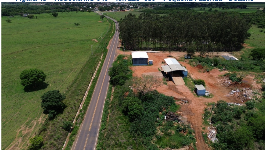
Figura 48 – Rodovia MS-040 – km 223+680 – Pequena Fazenda - Detalhe
