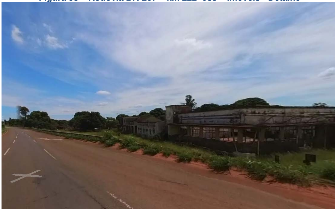
Figura 58 – Rodovia BR-267 – km 222+988 – Imóveis - Detalhe
