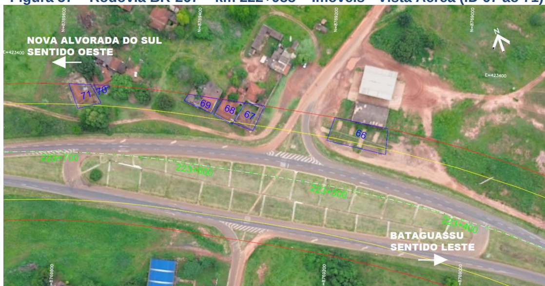
Figura 57 – Rodovia BR-267 – km 222+988 – Imóveis - Vista Aérea (ID 67 ao 71)
