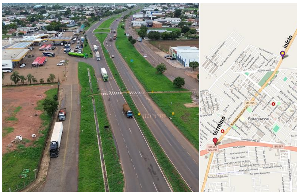
Figura 47 - Foto Aérea da Travessia de Bataguassu – MS-395
