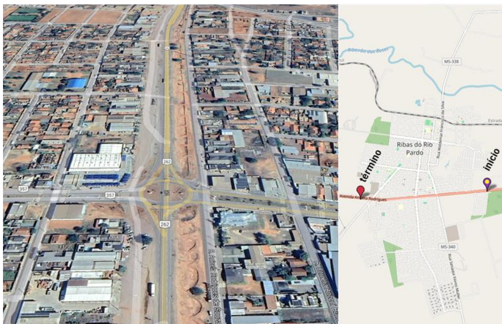
Figura 44 - Foto Aérea da Travessia de Ribas do Rio Pardo – BR-267
