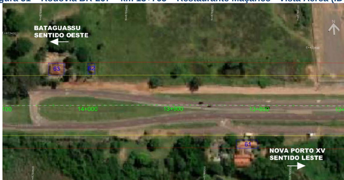
Figura 51 – Rodovia BR-267 – km 13+765 – Restaurante Maçarico - Vista Aérea (ID 61)
