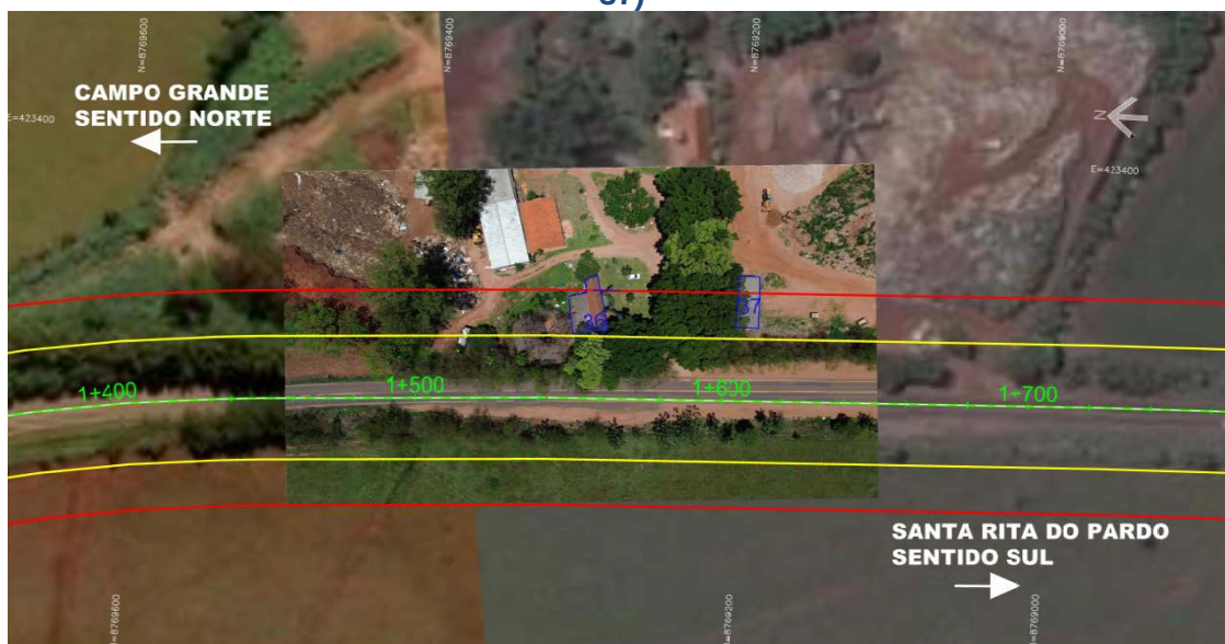
Figura 33 – Rodovia MS-040 – km 1+500 – Ambiental Solutions - Vista Aérea (ID 36 e 37)
