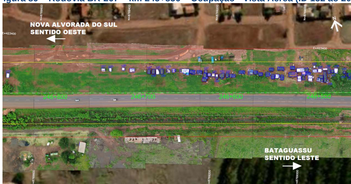
Figura 89 – Rodovia BR-267 – km 245+856 – Ocupação - Vista Aérea (ID 152 ao 202)
