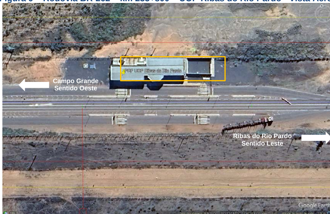
Figura 9 – Rodovia BR-262 – km 233+800 – UOP Ribas do Rio Pardo - Vista Aérea
