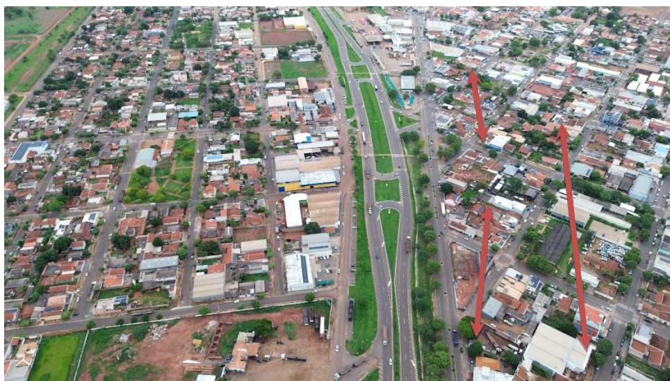
Figura 27 - Via Marginal – BR-267 – Bataguassu - km 28+392 ao km 29+750
