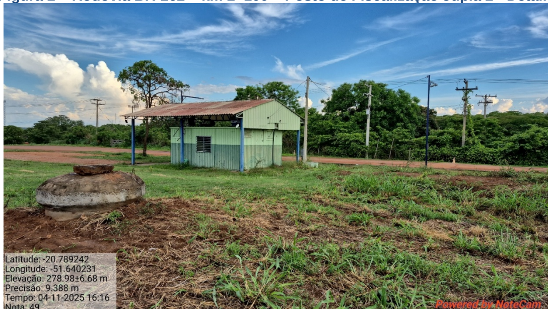
Figura 2 – Rodovia BR-262 – km 2+100 – Posto de Fiscalização Jupiá 2 - Detalhe
