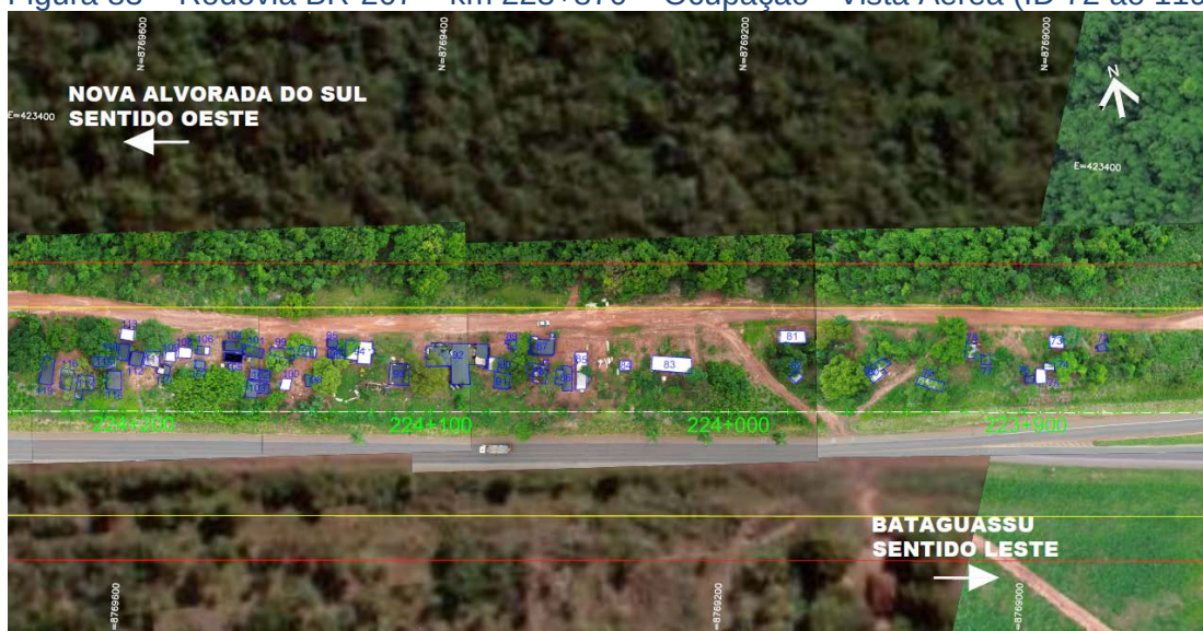
Figura 83 – Rodovia BR-267 – km 223+870 – Ocupação - Vista Aérea (ID 72 ao 119)
