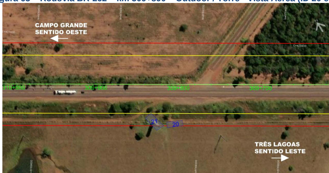
Figura 63 – Rodovia BR-262 – km 309+890 – Outdoor / Torre - Vista Aérea (ID 20 e 21)
