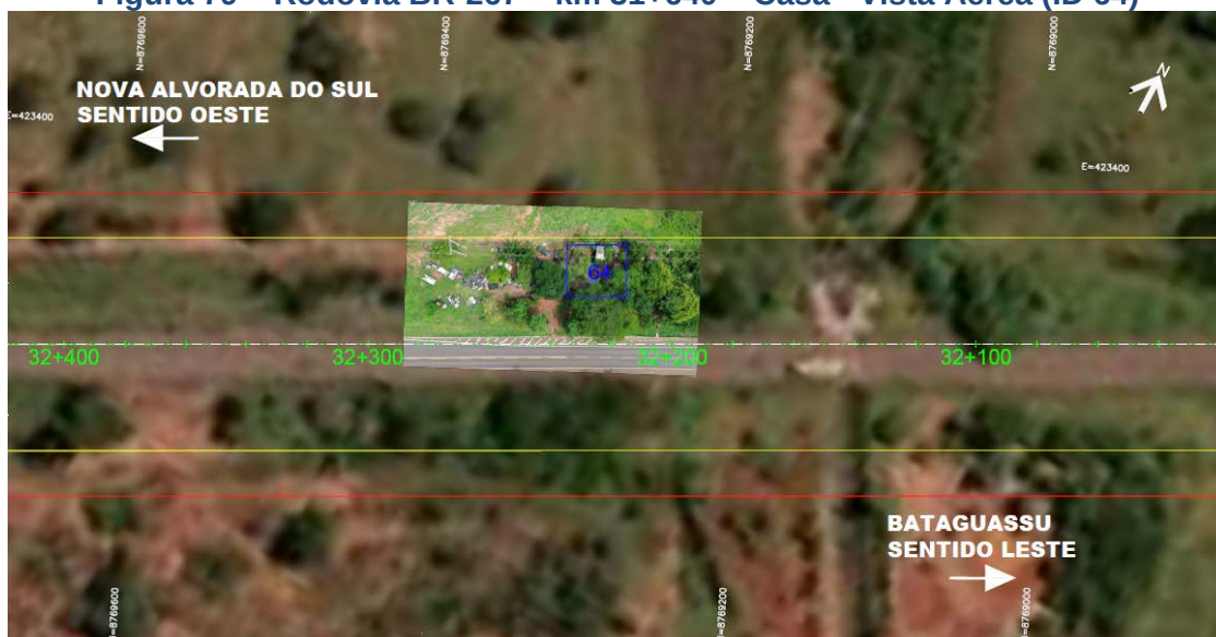
Figura 79 – Rodovia BR-267 – km 31+640 – Casa - Vista Aérea (ID 64)
