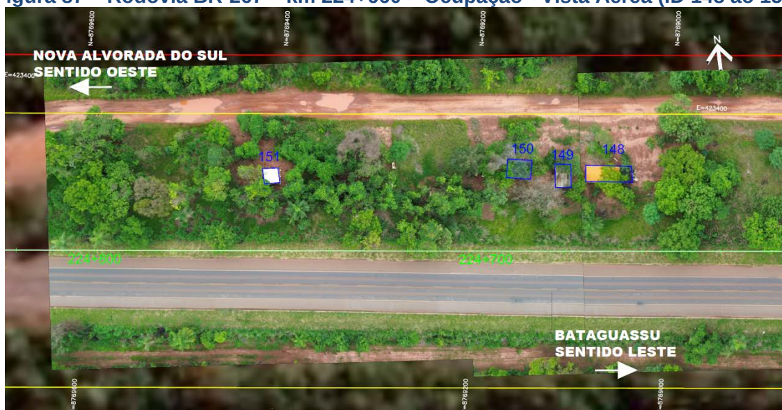
Figura 87 – Rodovia BR-267 – km 224+660 – Ocupação - Vista Aérea (ID 148 ao 151)
