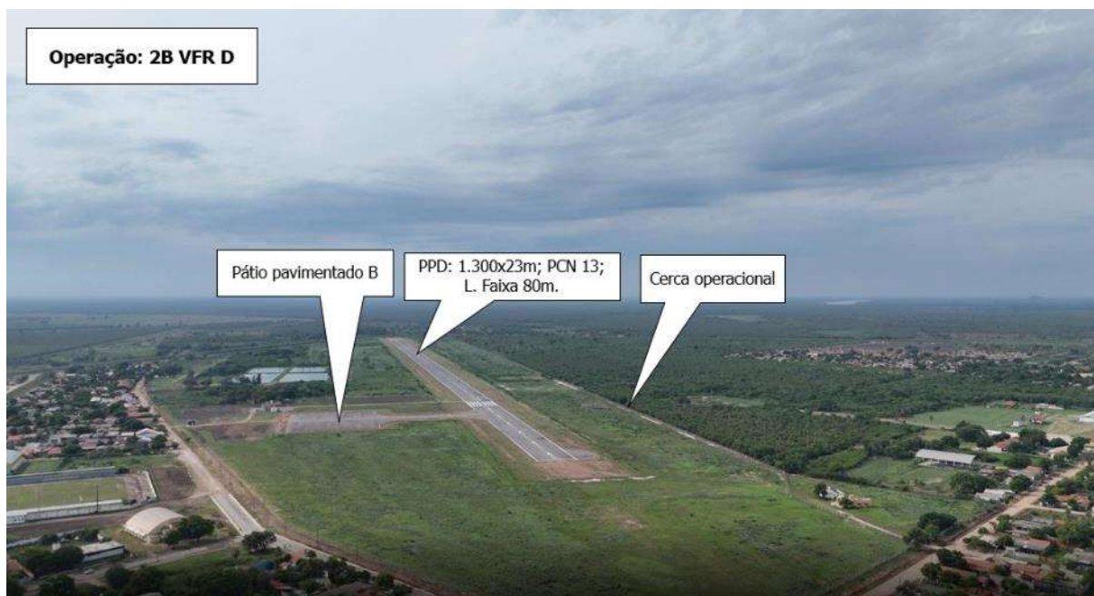
Figura 6-35 Porto Murtinho – Infraestrutura existente
