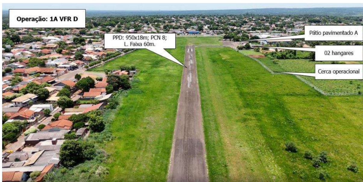
Figura 6-56 Jardim – Infraestrutura existente
