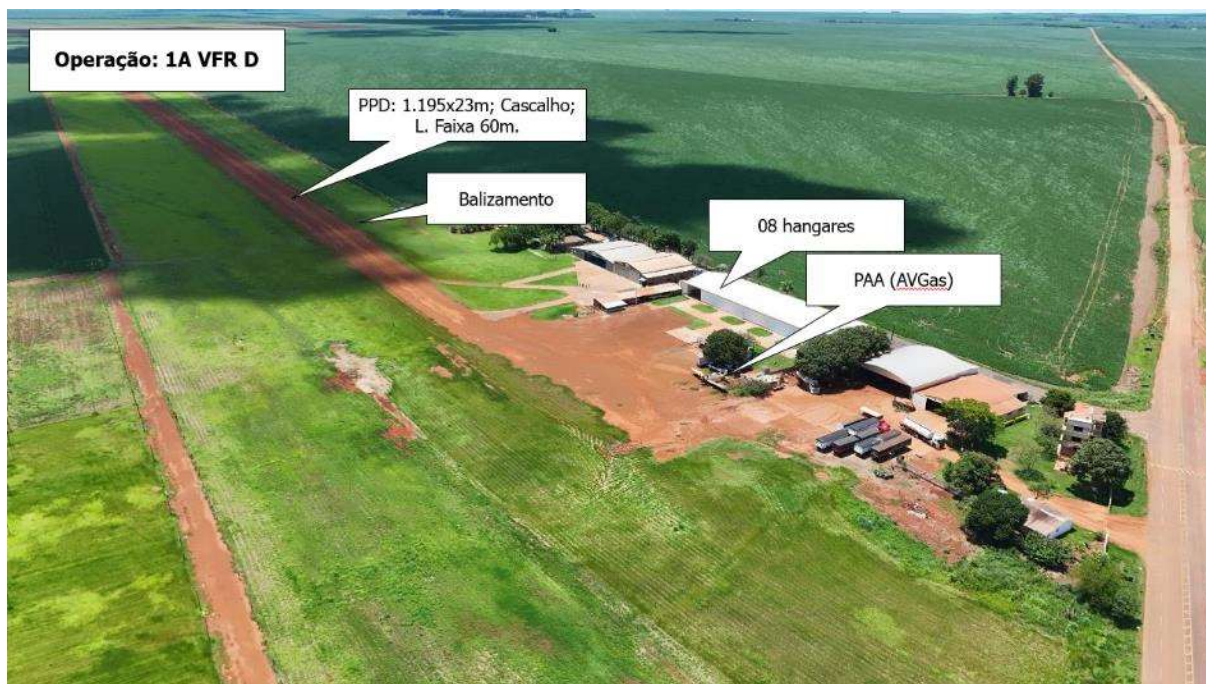
Figura 6-61 São Gabriel do Oeste – Infraestrutura existente
