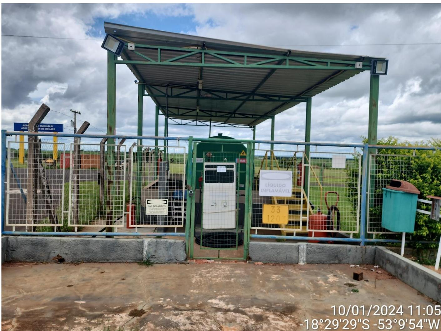
Figura 14-7 SDXJ: tanque de abastecimento para aeronaves
