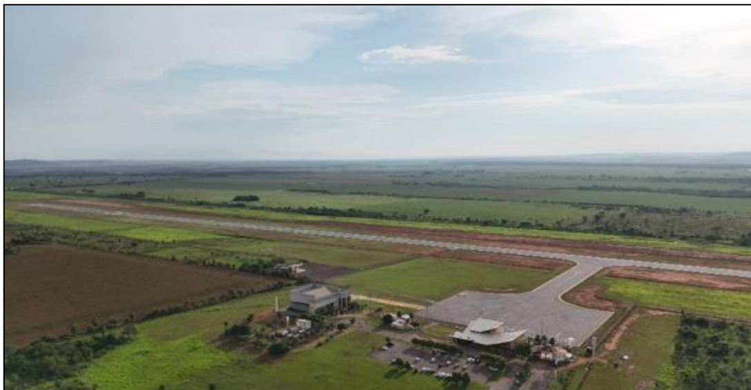
Figura 13: A vegetação está ausente, o que propicia o desenvolvimento de processos erosivos de pequena escala.
