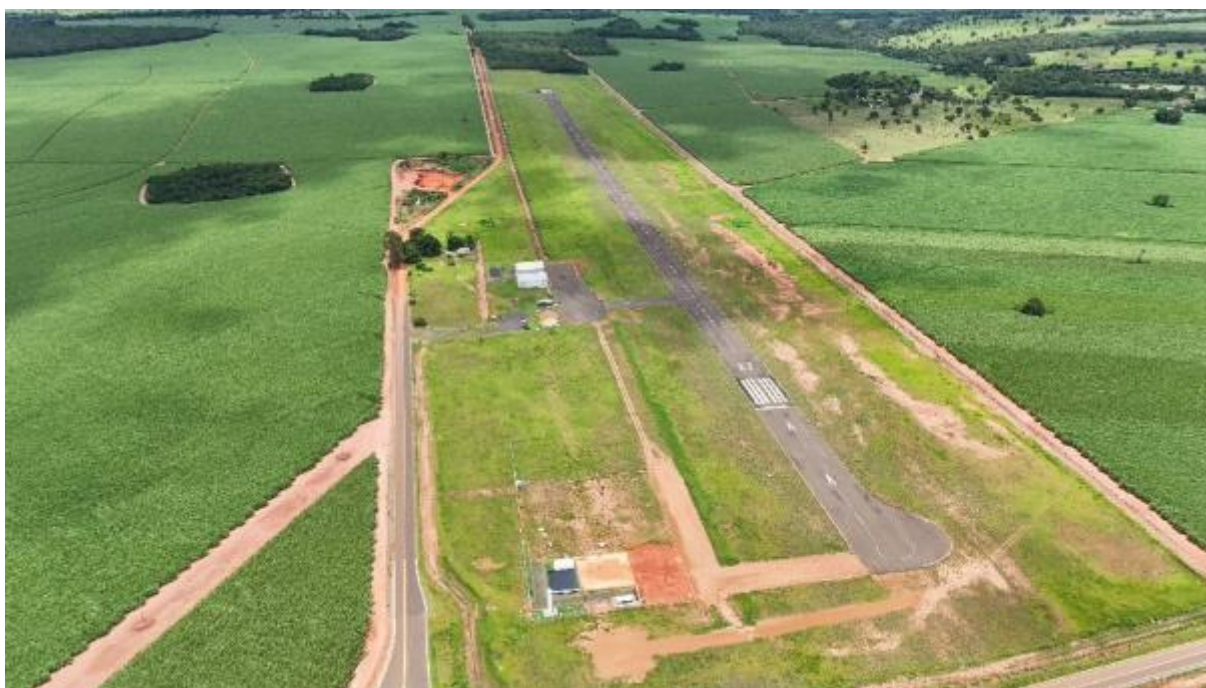
Figura 70: Ausência de vegetação com processos erosivos formados de pequenas proporções.
