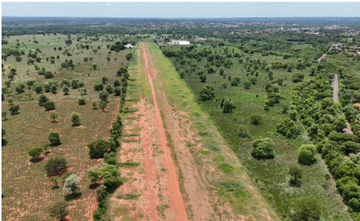
Figura 95: Existem algumas regiões com vegetação ausente e a ocorrência de processos erosivos. Falta asfalto.
