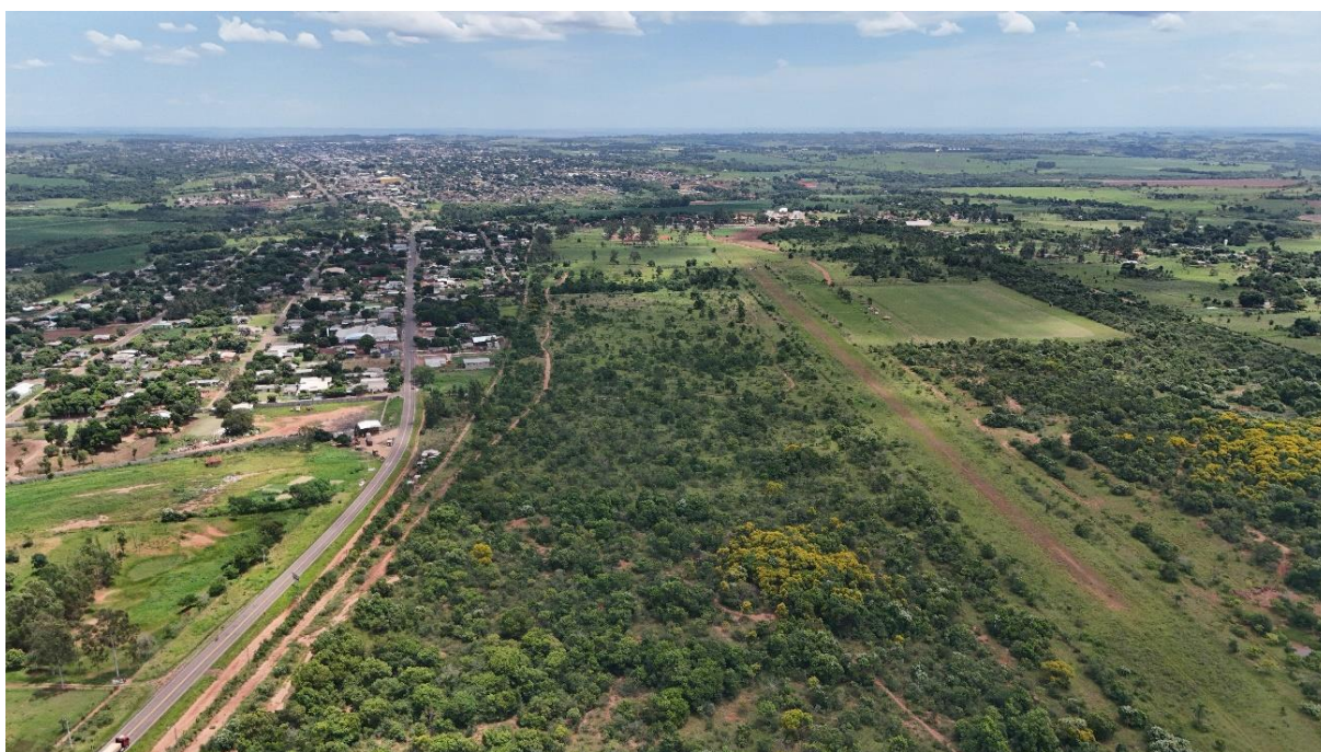
Figura 113: Vista aérea do Aeródromo.
