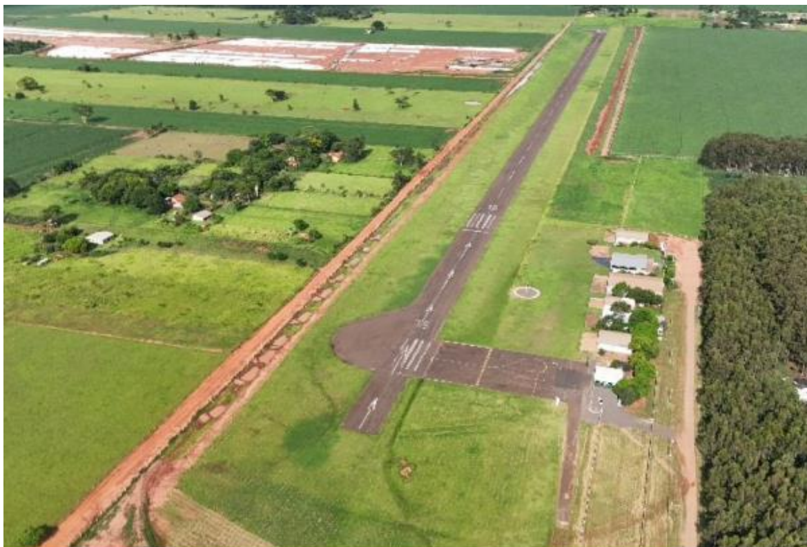
Figura 64: Uma valeta desprovida de revestimento, com ausência de vegetação e a presença de processos erosivos de média intensidade.
