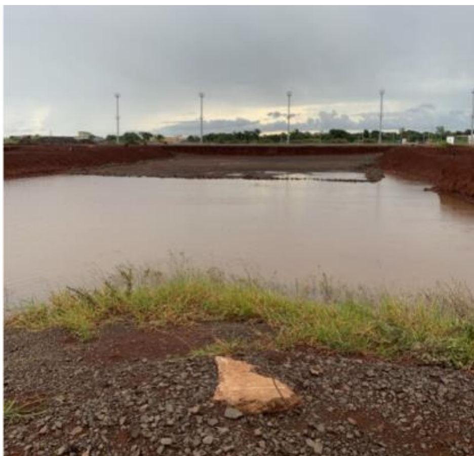
Figura 39: A região apresenta problemas de infiltração de água da chuva.
