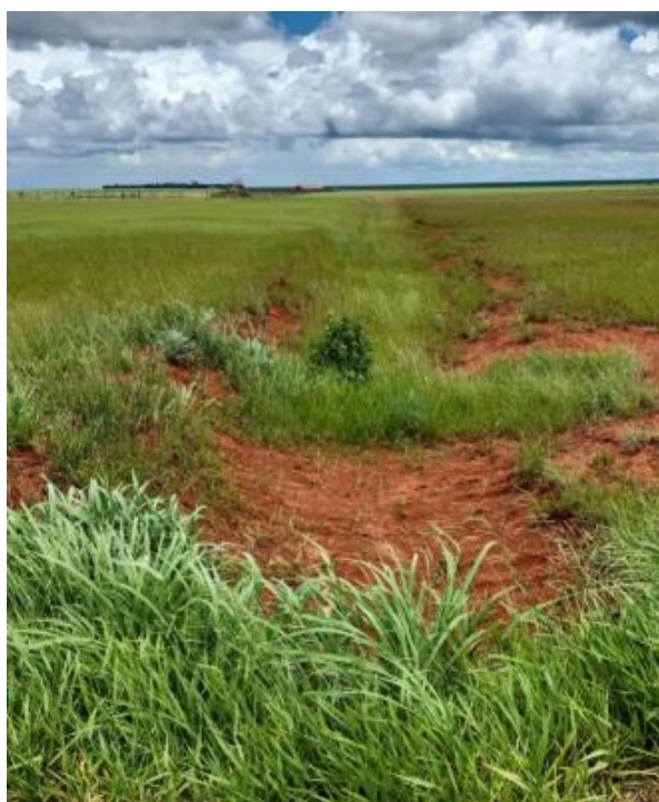
Figura 30: Situação atual do sistema de drenagem
