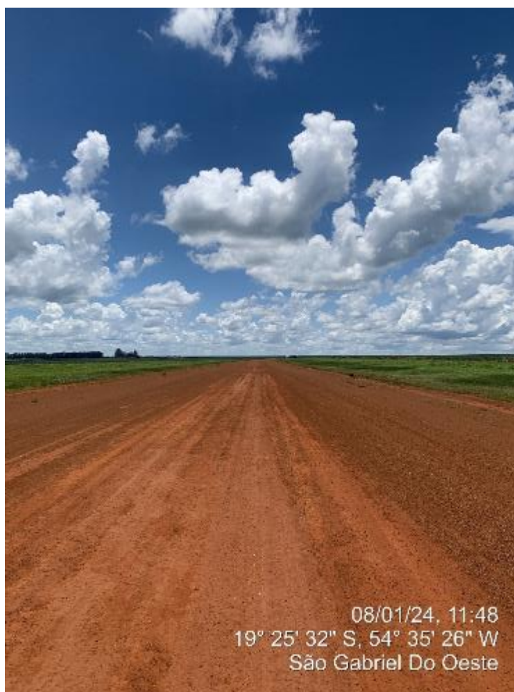
Figura 3-18 – Foto da pista do aeródromo
