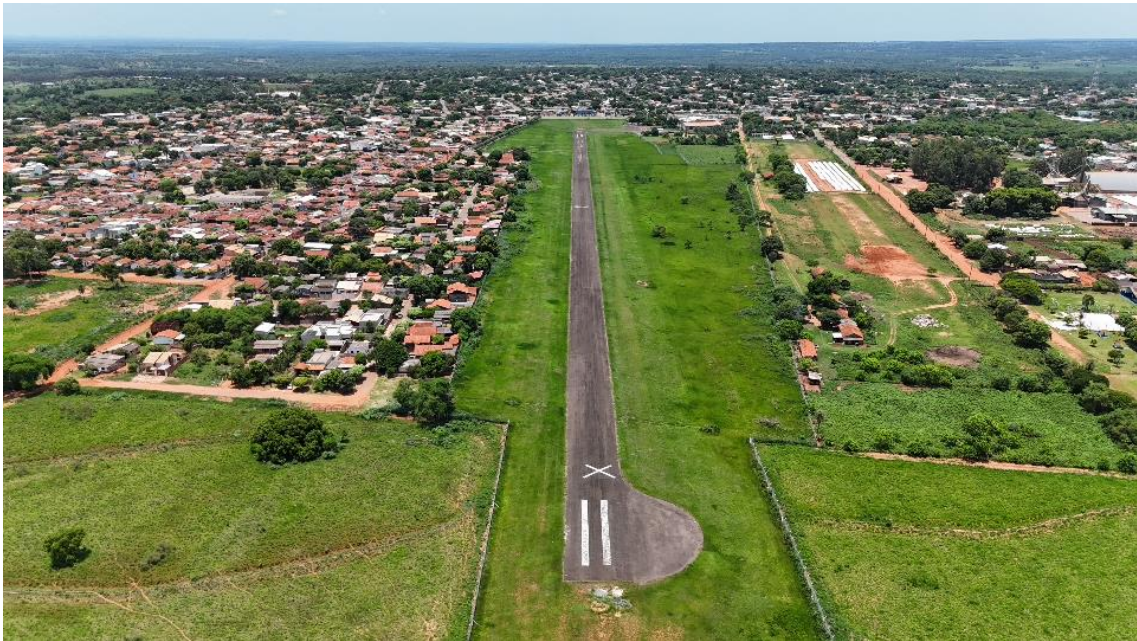
Figura 2-17 - Vista aérea de área de giro da PPD do aeródromo de Jardim (MS), com indicação de interdição de pista
