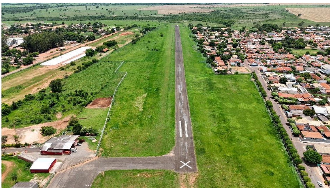
Figura 2-16 - Vista aérea de cabaceira da PPD do aeródromo de Jardim (MS), com indicação de interdição de pista
