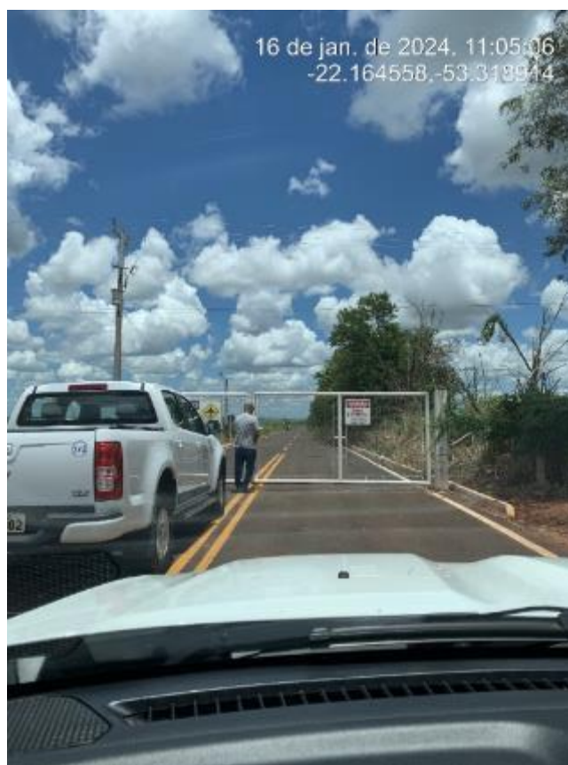
Figura 5-32 - Portão de acesso ao aeródromo municipal de Nova Andradina (MS)
