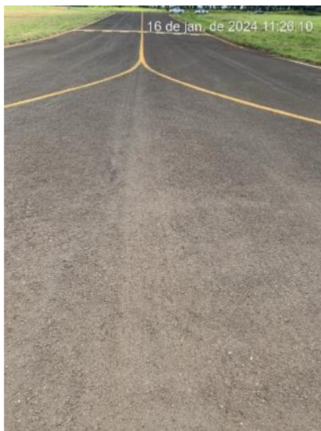
Figura 5-24 - Registro terrestre da pista de táxi do aeródromo municipal de Nova Andradina (MS)
