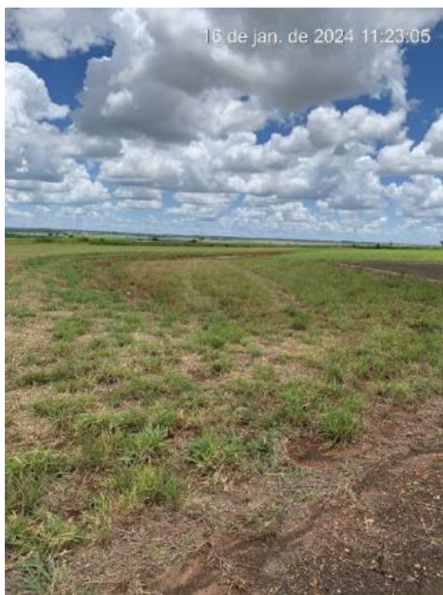
Figura 5-22 - Desnível na faixa da PPD do aeródromo municipal de Nova Andradina (MS)
