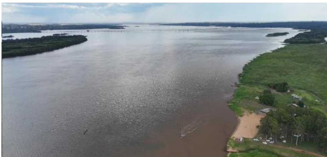
Figura 10-15 - Vista aérea do rio Paraná com a ponte Ayrton Sena ao fundo e abaixo, a direita, a Prainha do cascalho
