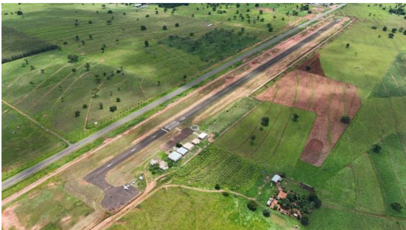
Figura 1-17 - Vista aérea do aeródromo de Cassilândia (MS)
