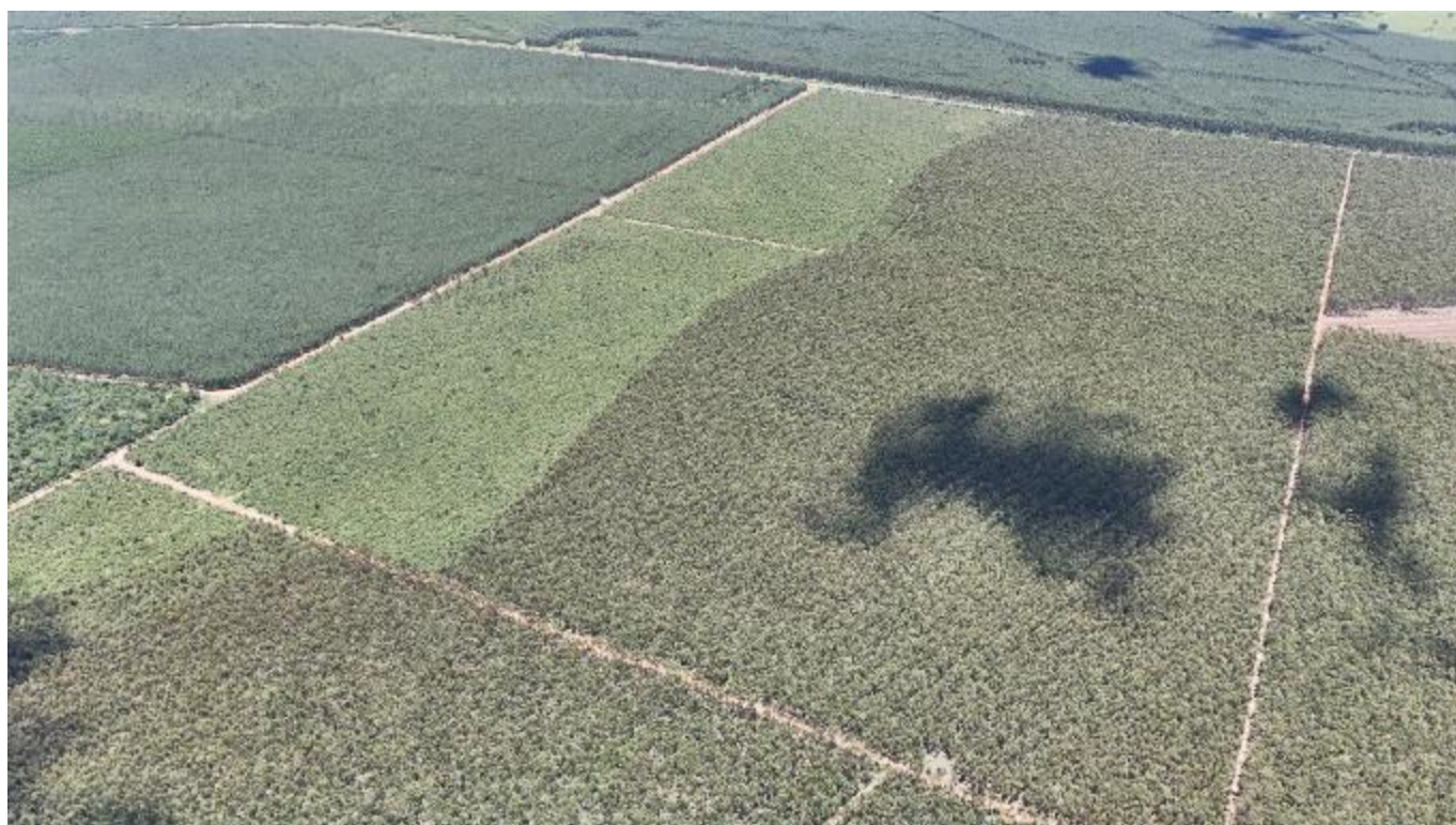
Figura 6-16 - Foto Aérea do Terreno cedido para a construção do aeródromo de Água Clara 2/2
