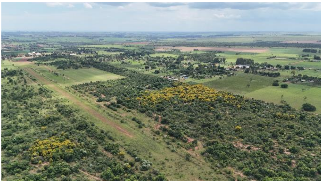
Figura 7-19 - Vista aérea da localização prospectada para a construção do aeródromo de Amambai (MS)
