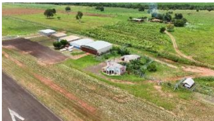
Figura 1-18 - Vista aérea dos hangares, receptivo e abastecimento
