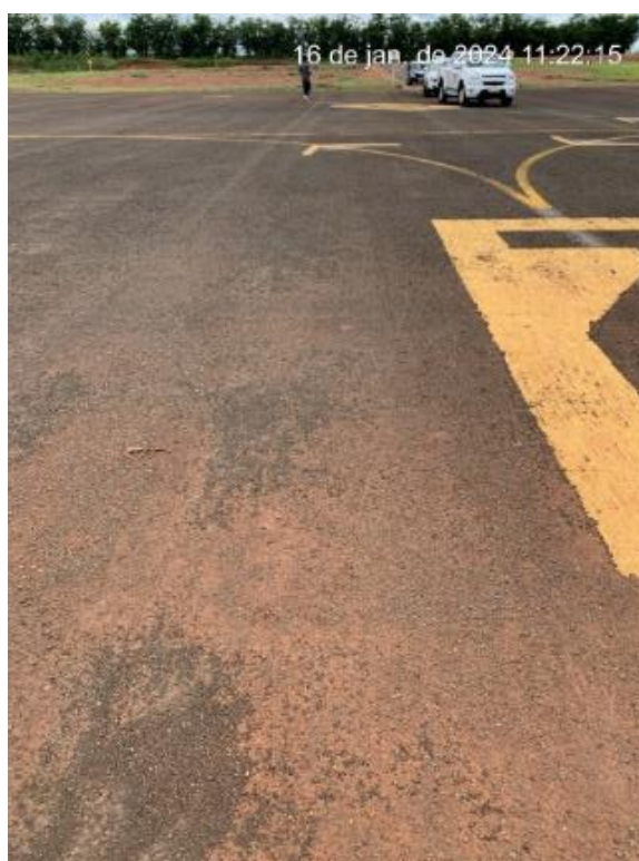
Figura 5-21 - Registro terrestre do pátio do aeródromo municipal de Nova Andradina (MS)
