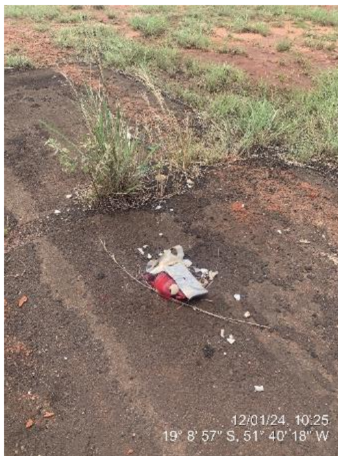
Figura 1-21 - Sinalização luminosa danificada
