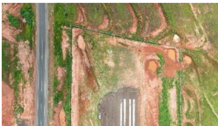
Figura 1-23 - Vista aérea das bacias de drenagem (cabeceira maior)
