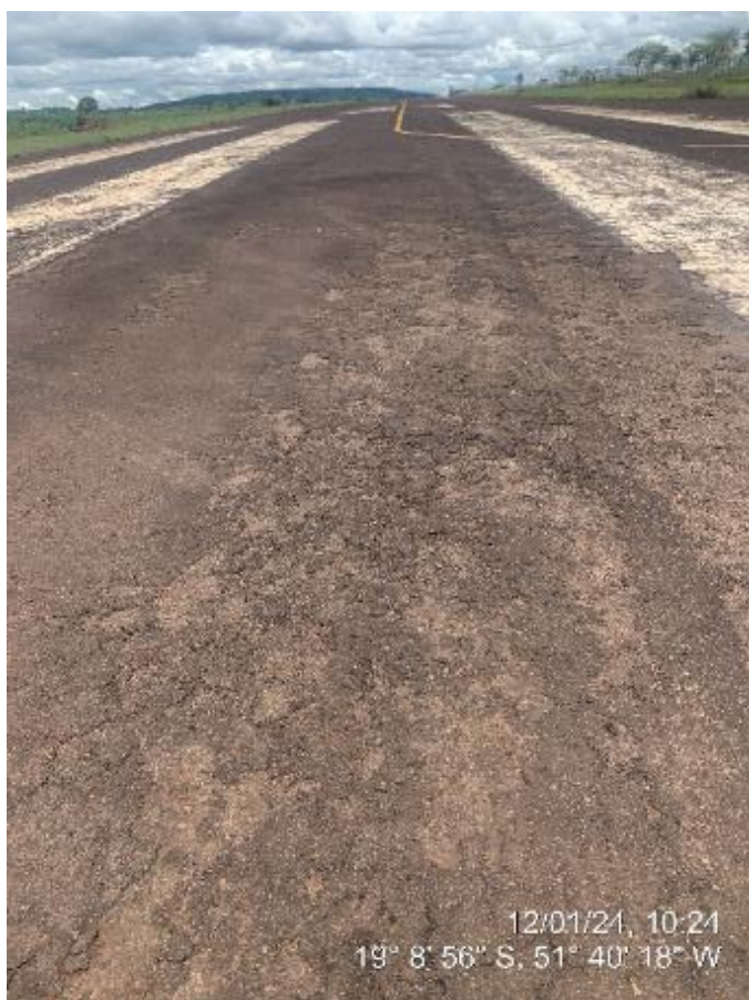
Figura 1-20 - Detalhe do pavimento da pista
