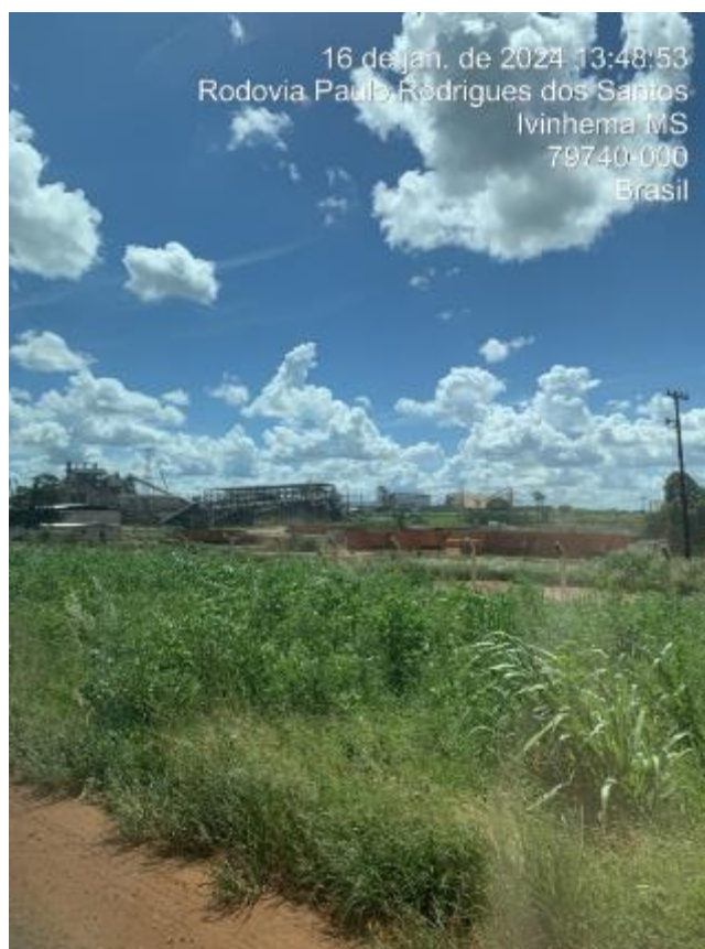
Figura 5-28 - Usina de álcool no município de Ivinhema, próximo à Nova Andradina (MS)
