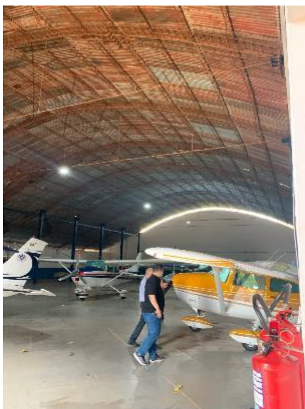
Figura 4-19 - Hangar de aviões do Aeroclube 2/2
