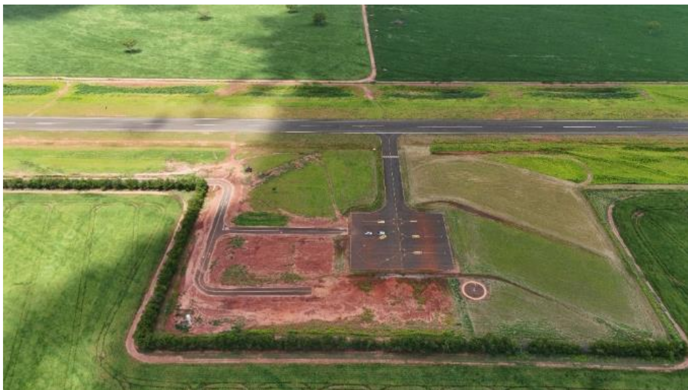
Figura 5-15 - Vista aérea do pátio do aeródromo municipal de Nova Andradina (MS)
