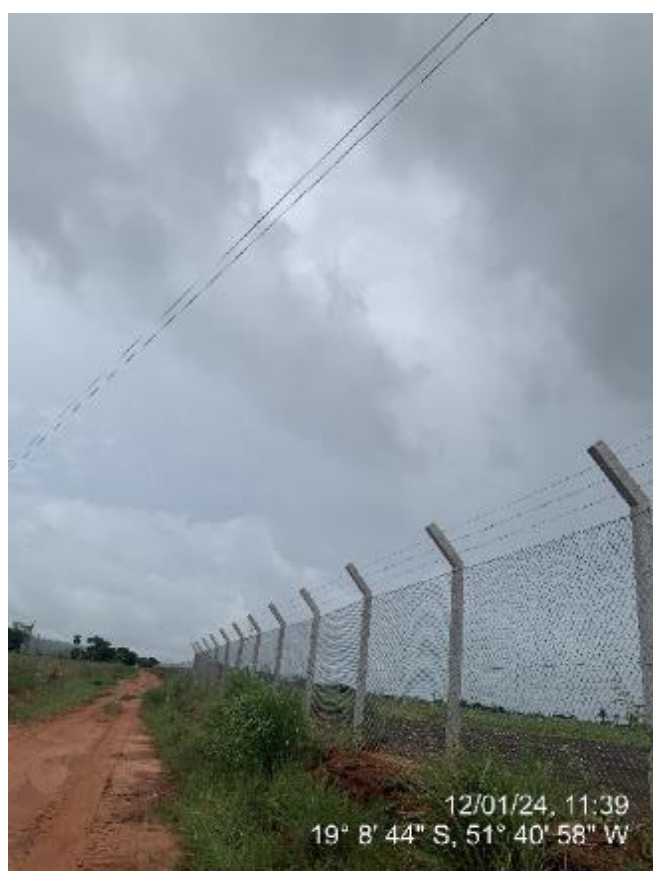
Figura 1-26 - Alambrado recém implantado
