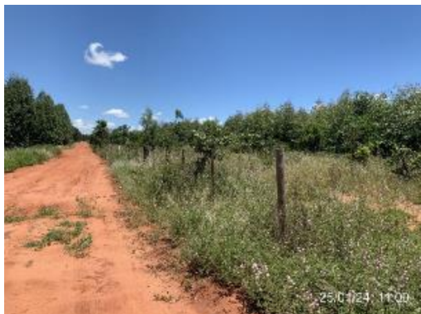
Figura 6-19 - Pista de acesso a entrada ao terreno cedido para o aeródromo de Água Clara 2/3
