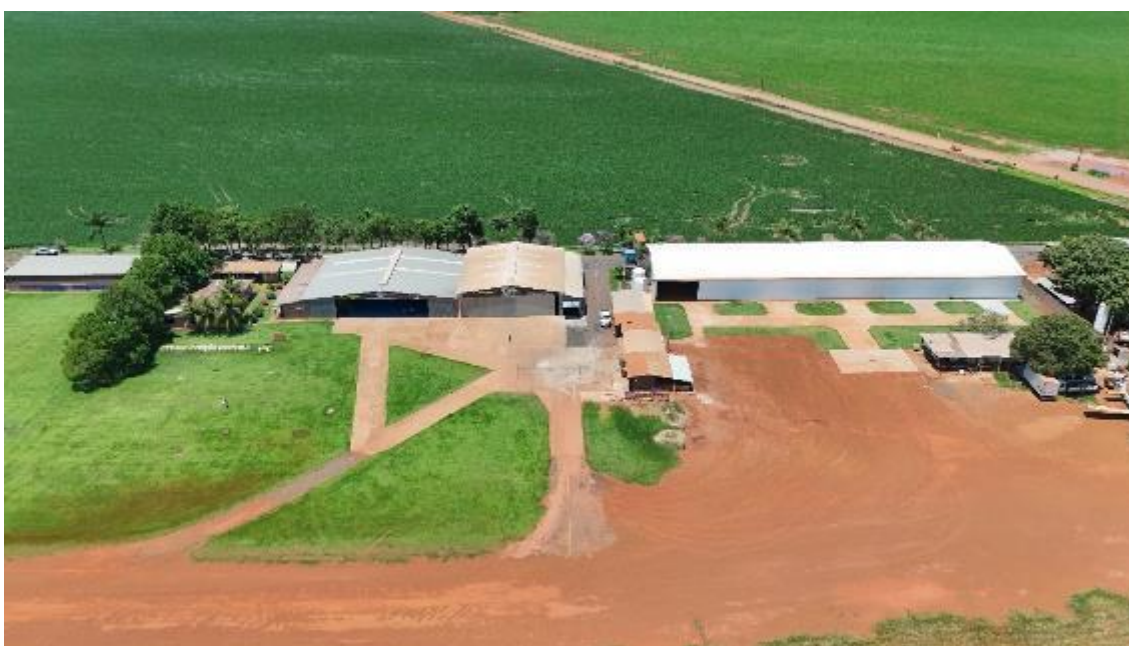
Figura 3-16 – Foto aérea do pátio e hangares
