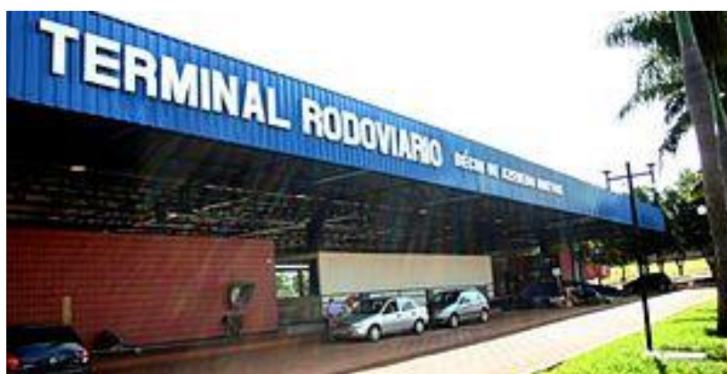
Figura 5-14 - Terminal Rodoviário Décio de Azevedo Mattos, Nova Andradina (MS)
