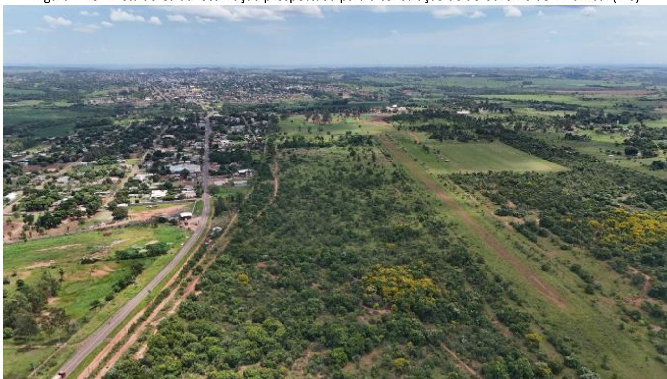
Figura 7-20 - Vista aérea da área prospectada para a construção do aeródromo de Amambai (MS) com o perímetro urbano da cidade ao fundo
