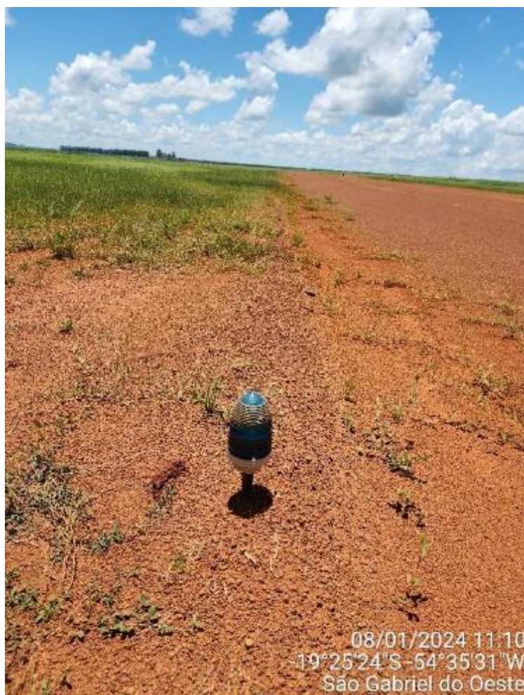
Figura 3-21 – Foto da Sinalização Luminosa
