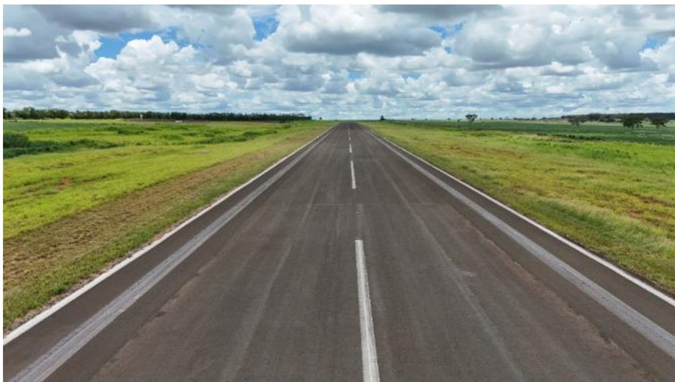
Figura 5-19 - Registro terrestre da PPD do aeródromo municipal de Nova Andradina (MS)
