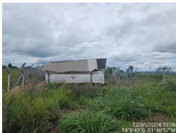
Figura 1-25 - Tanque de abastecimento (desativado)
