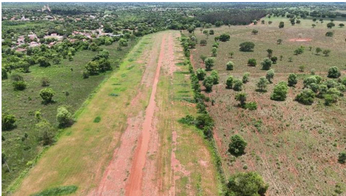
Figura 4-16 - Foto aérea da pista de pouso e decolagem do aeroclube de Aquidauana
