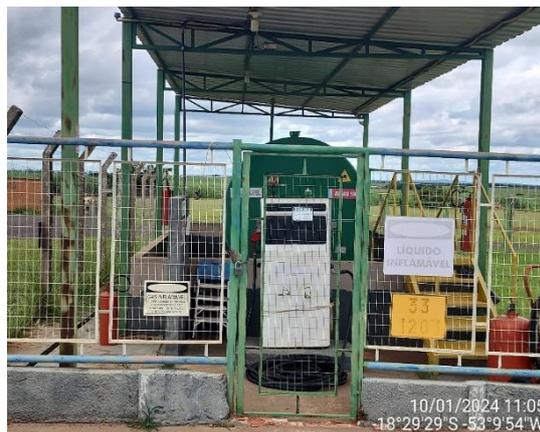
Figura 10-21 – Tanque de Abastecimento
