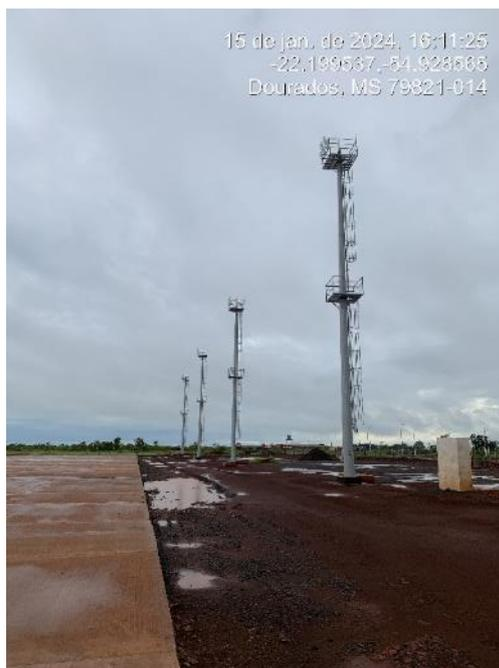
Figura 5-33 Detalhe dos refletores e do novo pavimento em concreto para o futuro estacionamento de aeronaves
