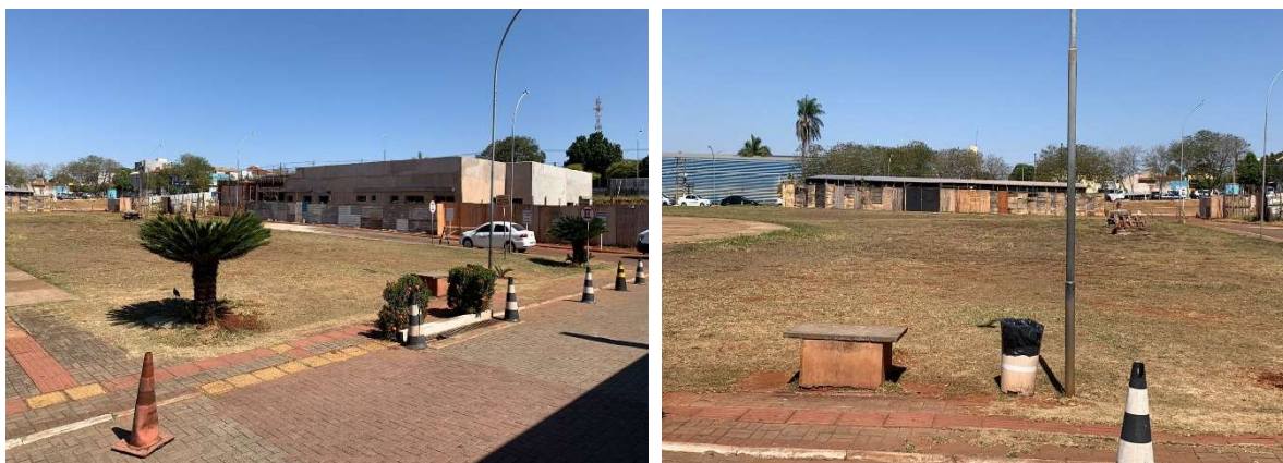
FIGURA 27 – OBRA DA RADIOLOGIA
