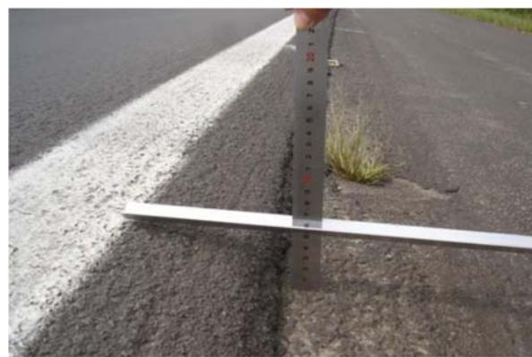
Figura 1-91 – Levantamento Degrau (Pista/Acostamento).
