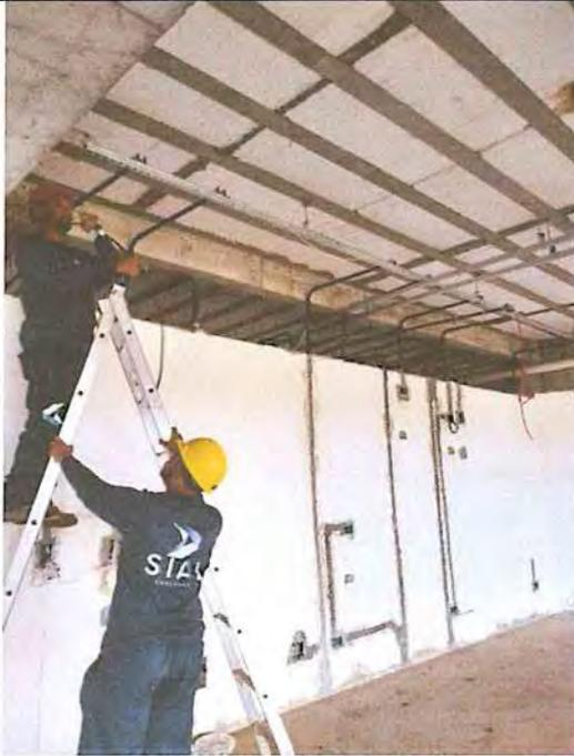
FOTO 33: Cabearamento Elétrico
