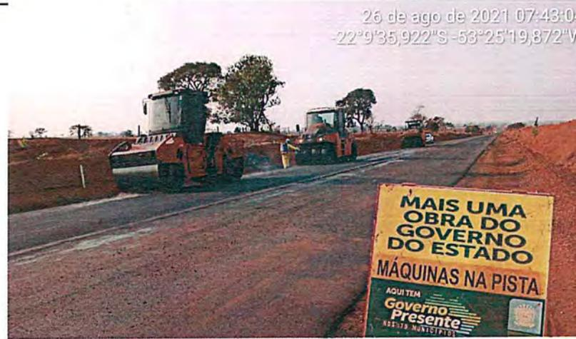
EXECUÇÃO DE PINTURA DE LIGAÇÃO E CBUQ - ESTACAS 471 a 457
