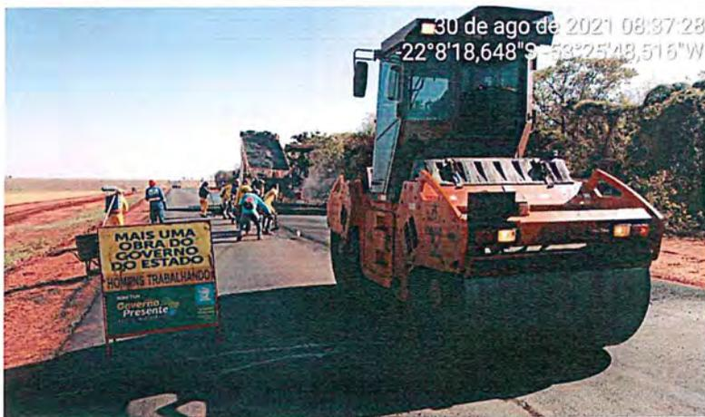
EXECUÇÃO DE PINTURA DE LIGAÇÃO E CBUQ - ESTACAS 339 a 366
