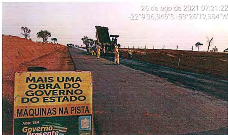
EXECUÇÃO DE PINTURA DE LIGAÇÃO E CBUQ - ESTACAS 471 a 457
