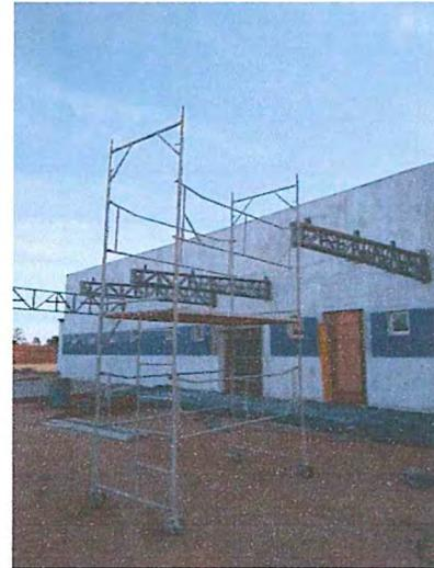
FOTO 06: Pintura e perfilado metálico
