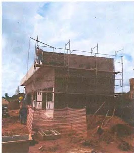
FOTO 19: Reboco alvenaria
