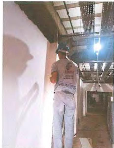
FOTO 20: Emassamento parede
