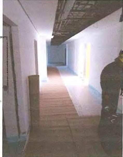
FOTO 02: Colocação proteção granelite
