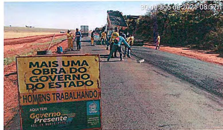
EXECUÇÃO DE PINTURA DE LIGAÇÃO E CBUQ - ESTACAS 339 a 366
