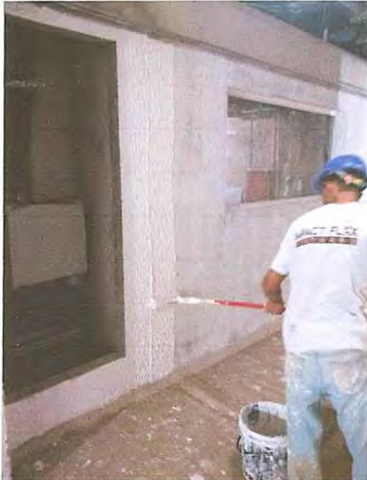
FOTO 37: Emassamento de Parede
