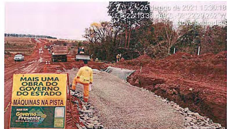
EXECUÇÃO DE COLÇÃO DRENANTE E DRENO LINEAR DPS - ESTACA 990 A 1000
