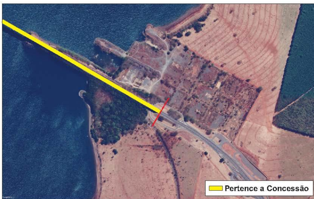
BR-436 - KM 18,15 - Final da Ponte Rodoferroviária
