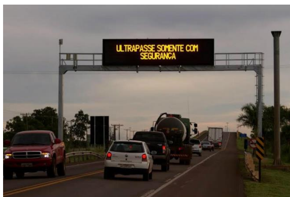
Figura 2.6 - Exemplo de painel fixo de mensagens variáveis.
