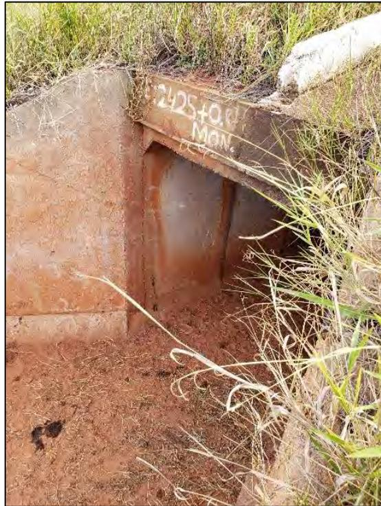
*Figura 3-23 - Túnel de passagem de fauna observada na Rodovia MS-112
