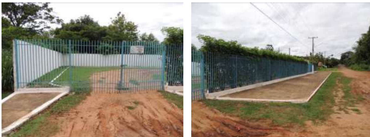
Figura 5: Vista geral da EEEB 001, Aquidauana, MS.
