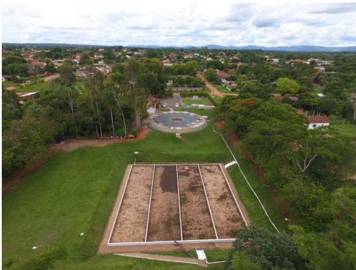
Figura 2: Vista aérea da ETE Aquidauana, Aquidauana, MS.
