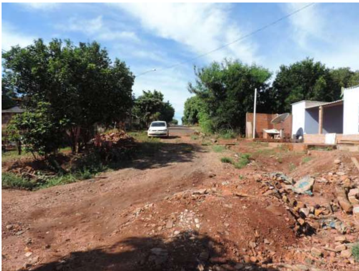
Figura 10: Processos erosivos presentes na área prevista para implantação da EEEB 004 Projetada, Antônio João, MS.
