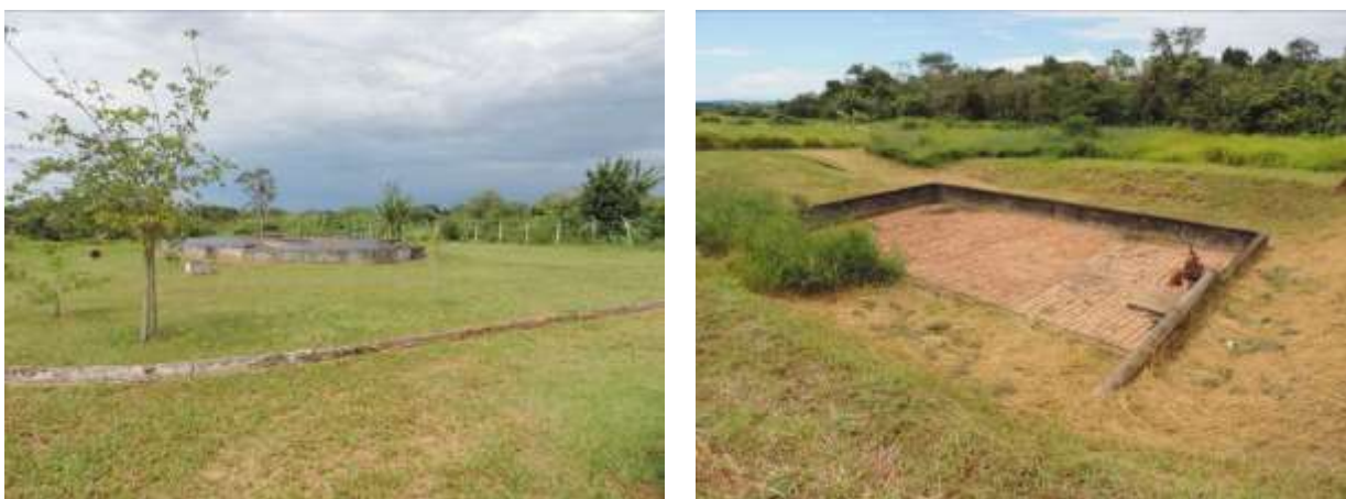
Figura 2: Vista geral da ETE Antônio João, Antônio João, MS.
