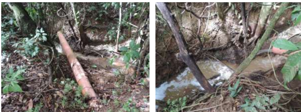
Figura 5: Local de lançamento do emissário da ETE Antônio João no Córrego Cachoeira do Bugre, Antônio João, MS.
