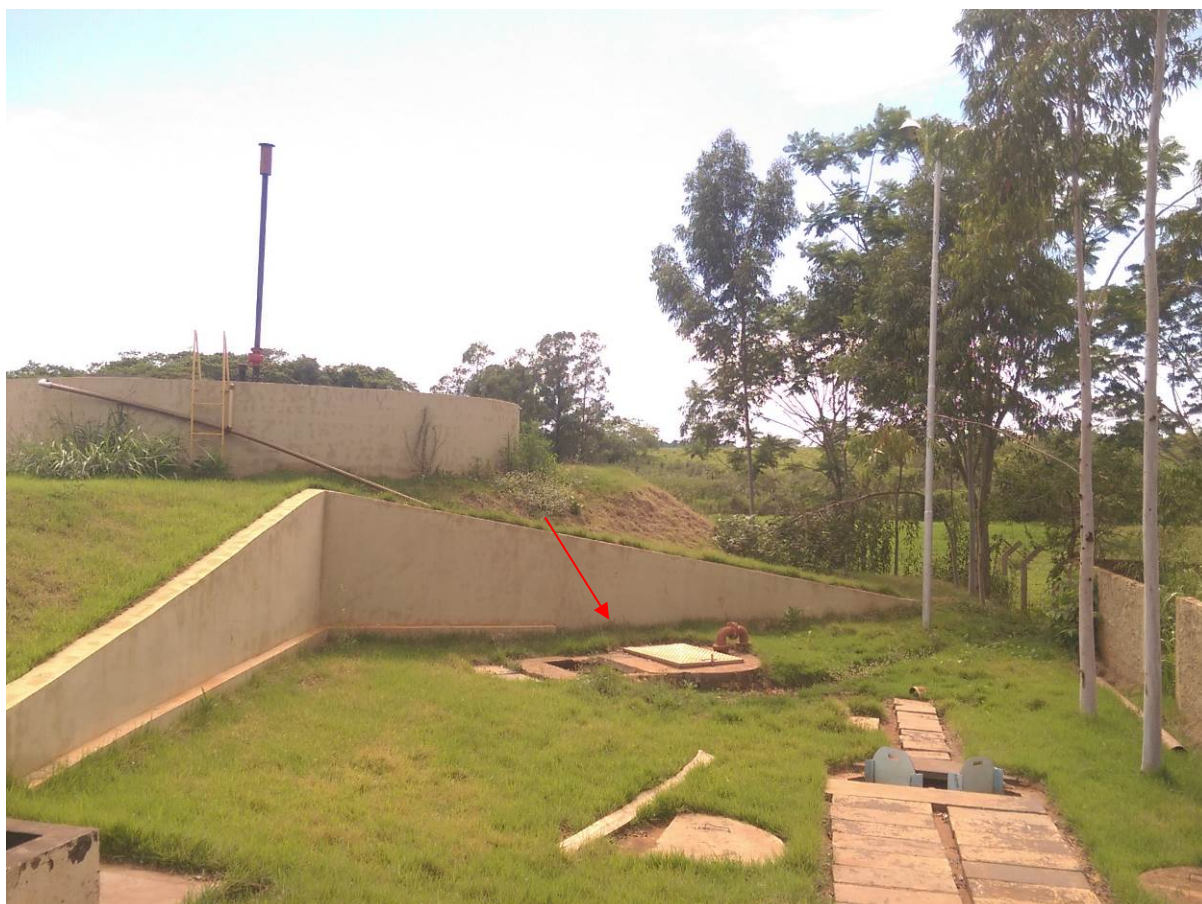
Figura 5: Vista geral da EEEB 001, Vicentina, MS.
