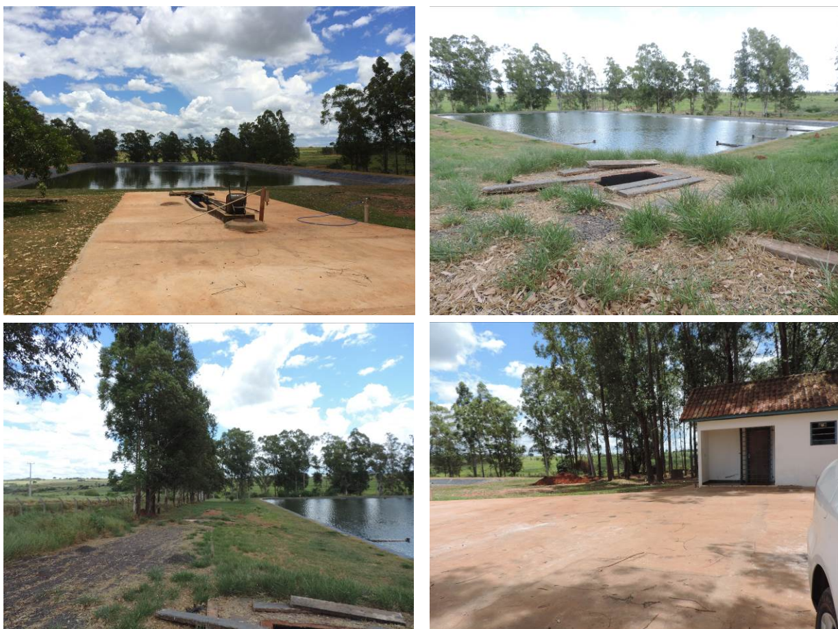
Figura 2: Vista geral da ETE Tacuru, Tacuru, MS.
