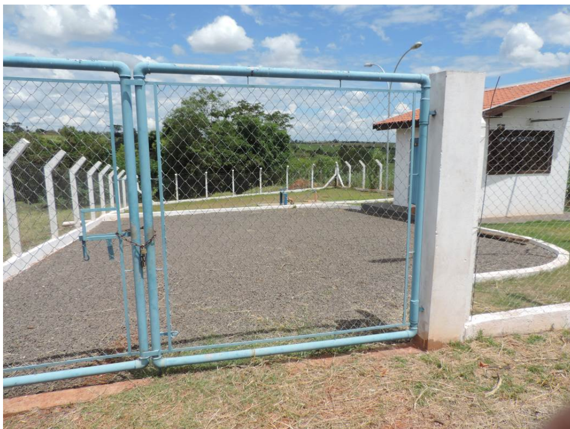
Figura 6: Vista geral da EEEB 001, Tacuru, MS.
