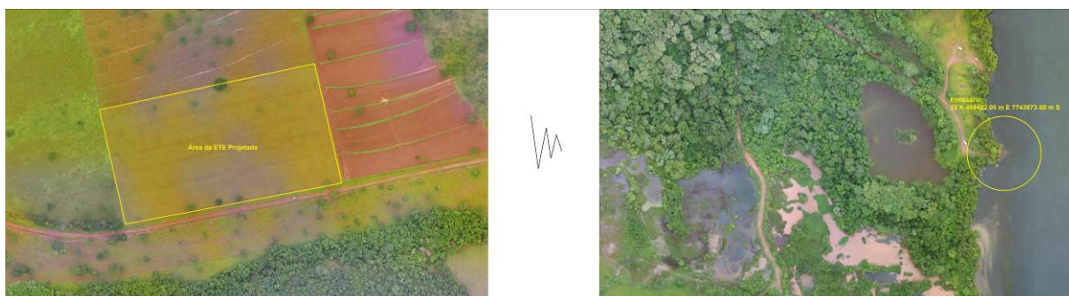
Figura 3: Vista aérea da ETE Selvíria Projetada e entorno, Selvíria, MS.
