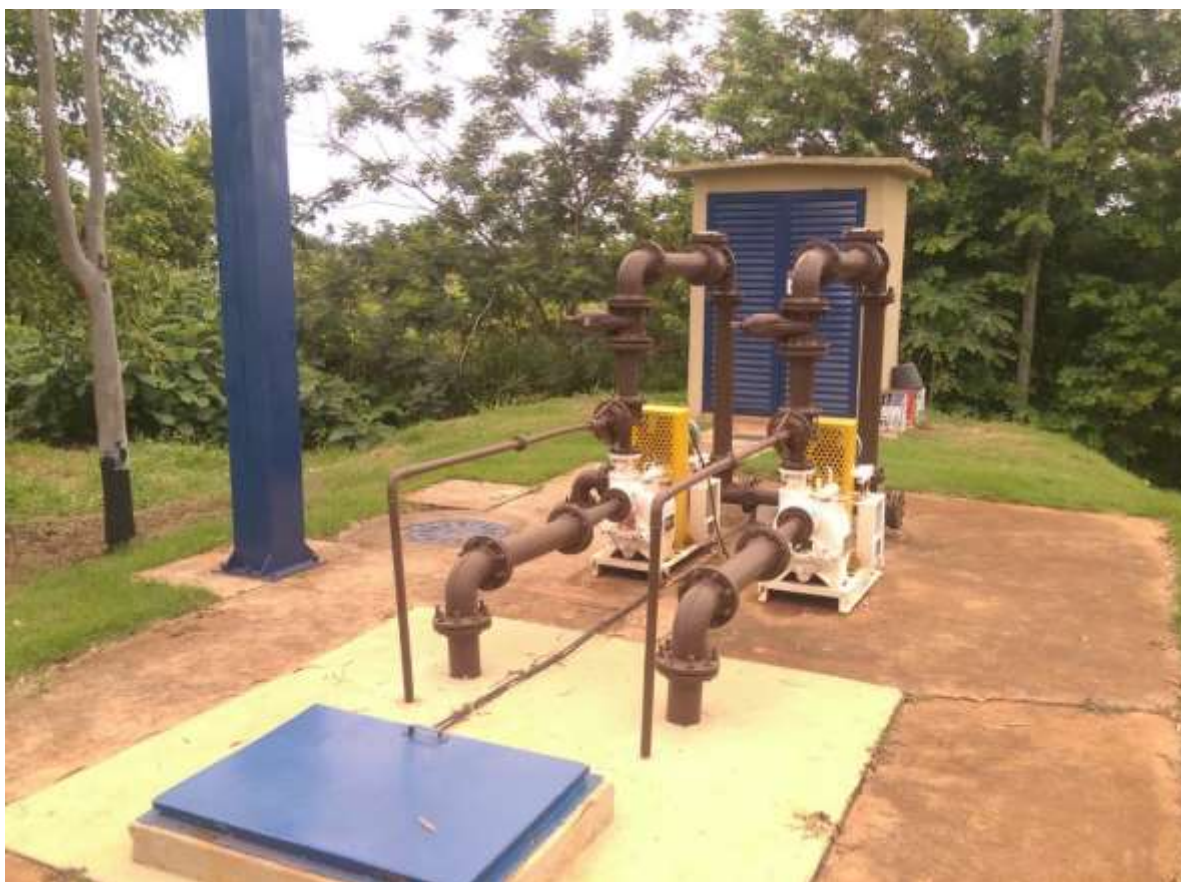
Figura 5: Vista geral da EEET 001, Angélica, MS.
