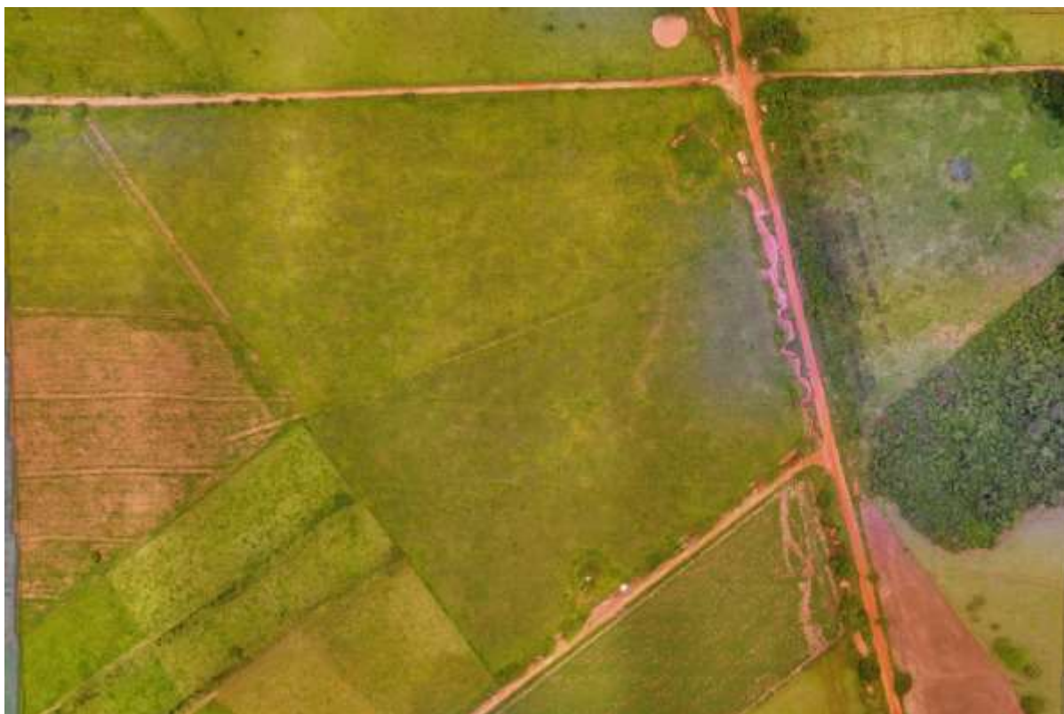
Figura 7: Vista aérea da ETE Angélica projetada, Angélica, MS.
