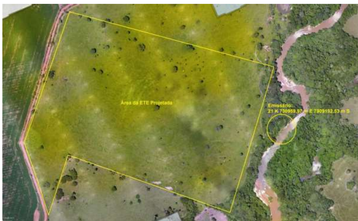
Figura 8: Vista aérea da ETE Projetada, Rio Verde de Mato Grosso, MS.
