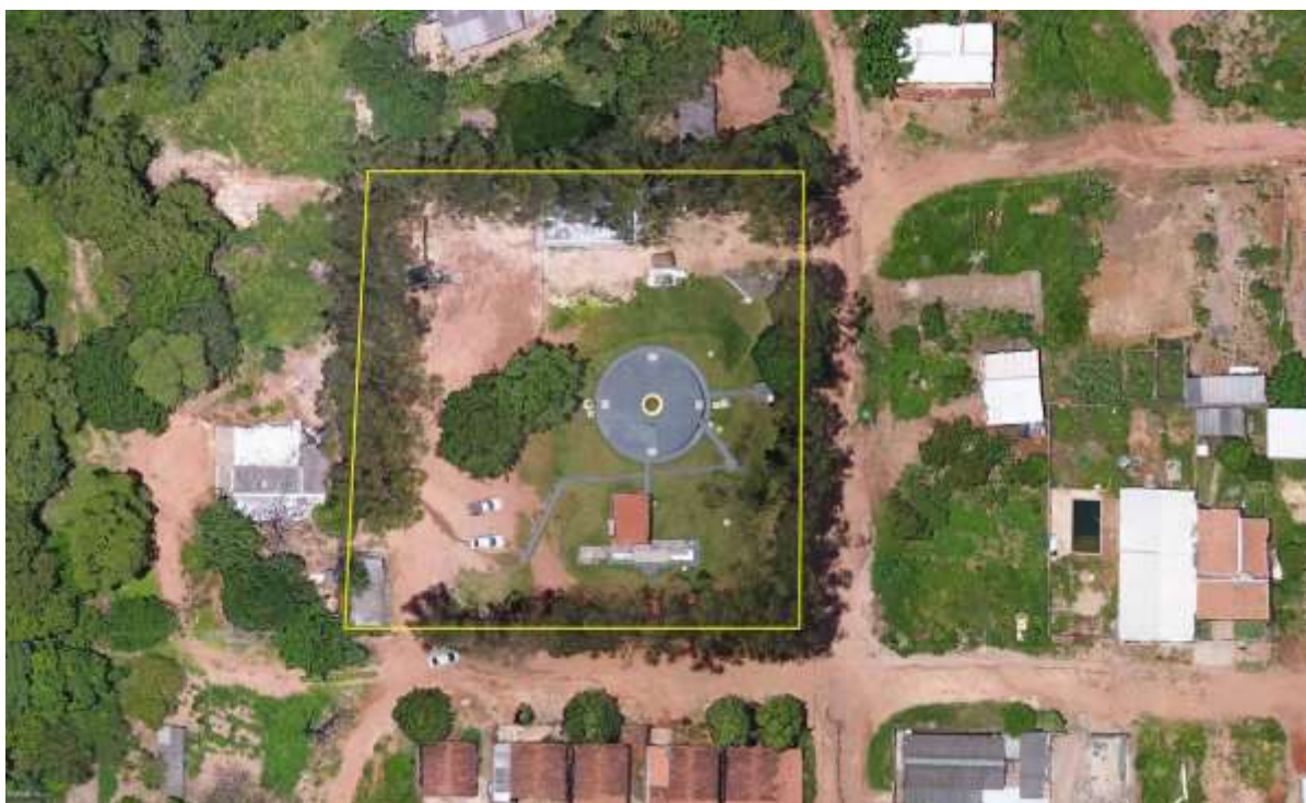
Figura 2: Vista aérea da ETE Rio Verde, Rio Verde de Mato Grosso, MS.
