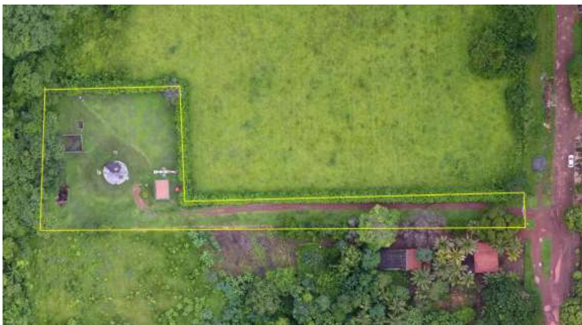
Figura 2: Vista aérea da ETE Pedro Gomes I, Pedro Gomes, MS.
