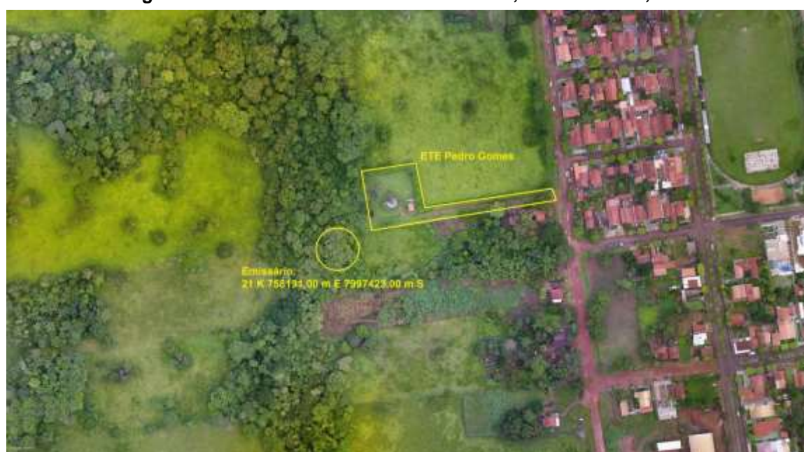
Figura 3: Vista aérea da ETE Pedro Gomes I e entorno, Pedro Gomes, MS.
