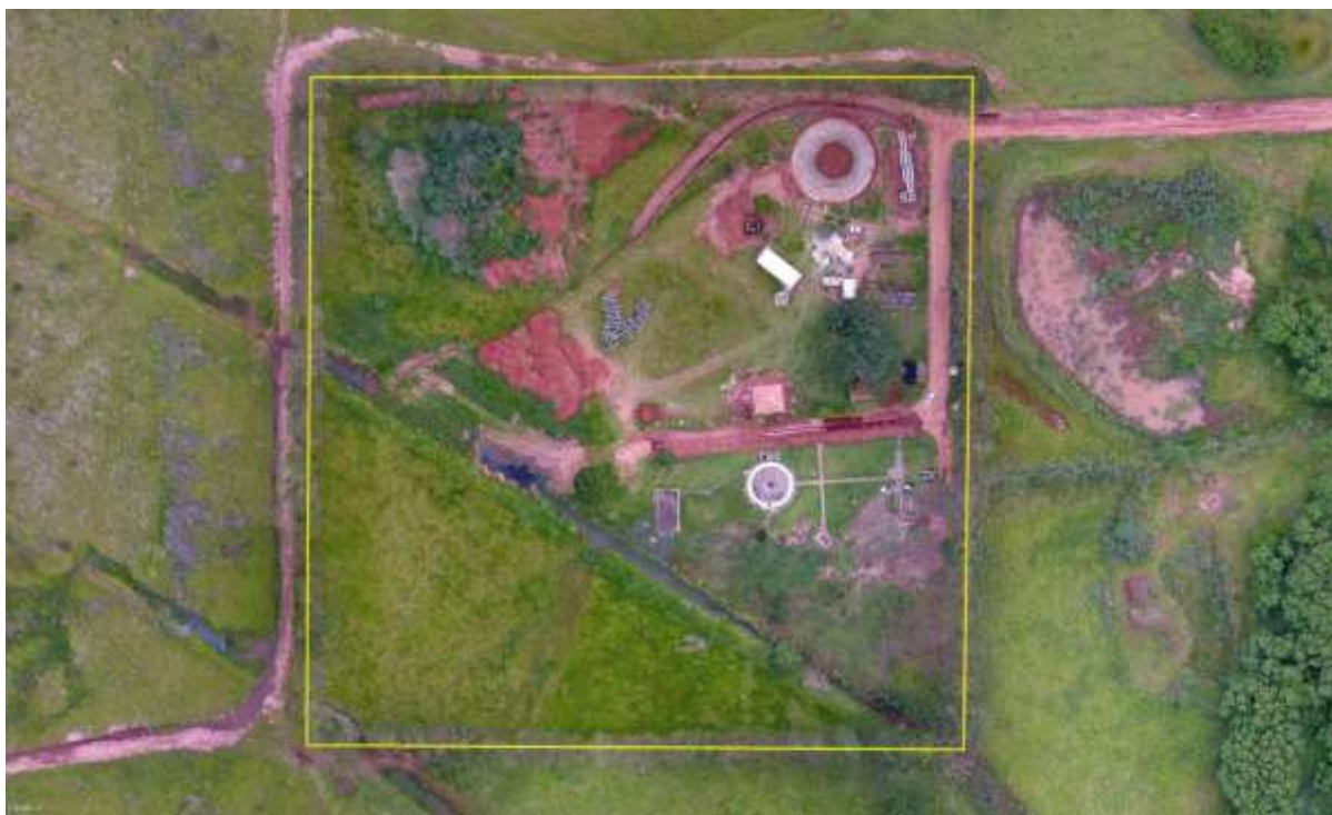
Figura 2: Vista aérea da ETE Nova Andradina, Nova Andradina, MS.
