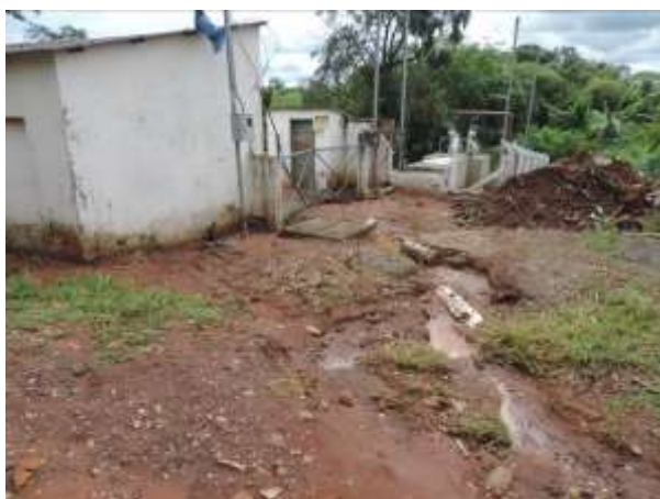
Figura 9: Vista geral do entorno da EEEB 009 mostrando o início do processo erosivo, Nioaque, MS.
