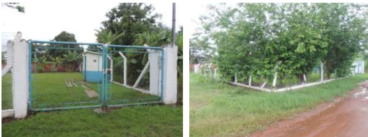
Figura 7: Vista geral da EEEB 006, Nioaque, MS.
