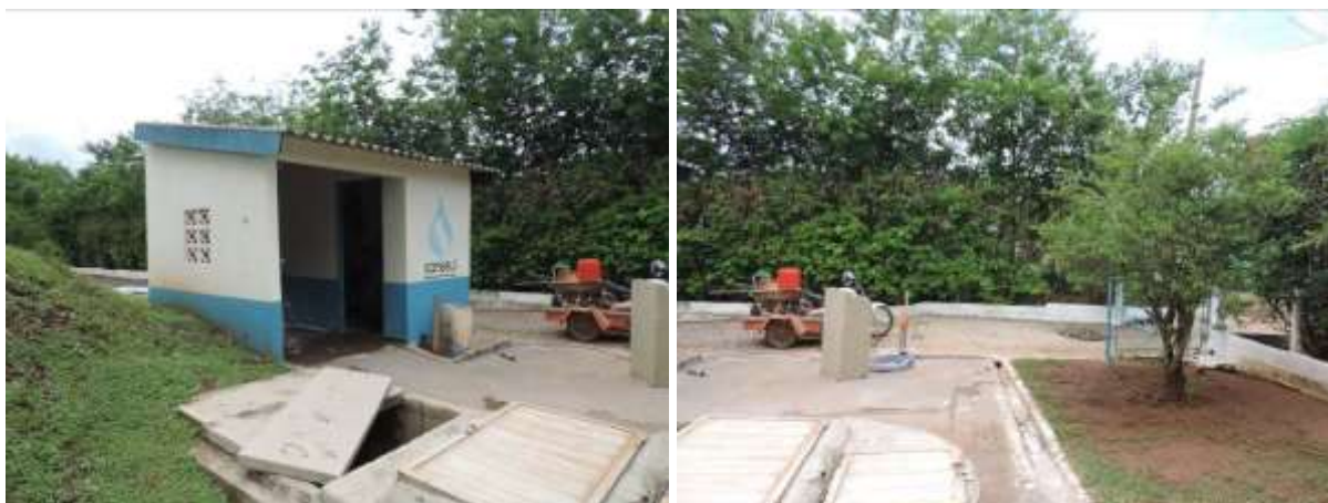
Figura 5: Vista geral da EEEB 004, Nioaque, MS.
