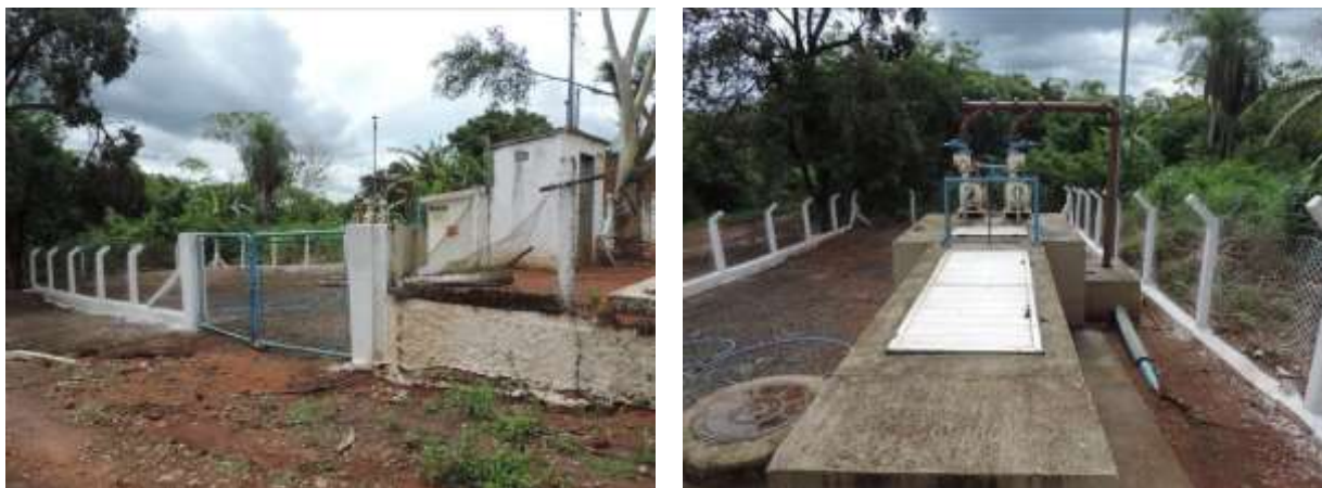
Figura 8: Vista geral da EEEB 009, Nioaque, MS.
