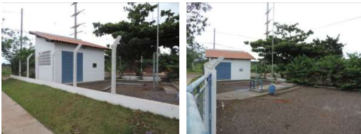
Figura 8: Vista geral da EEEB 003, Naviraí, MS.
