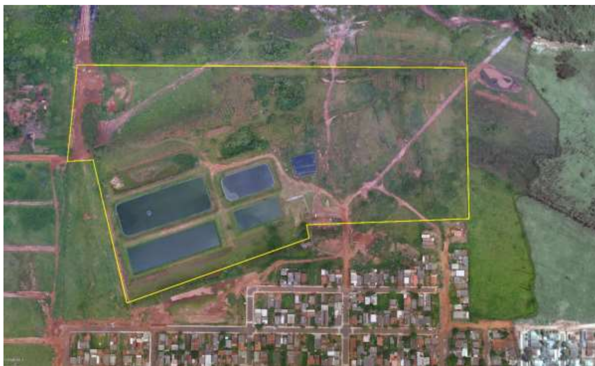
Figura 2: Vista aérea da ETE Ipê, Naviraí, MS.
