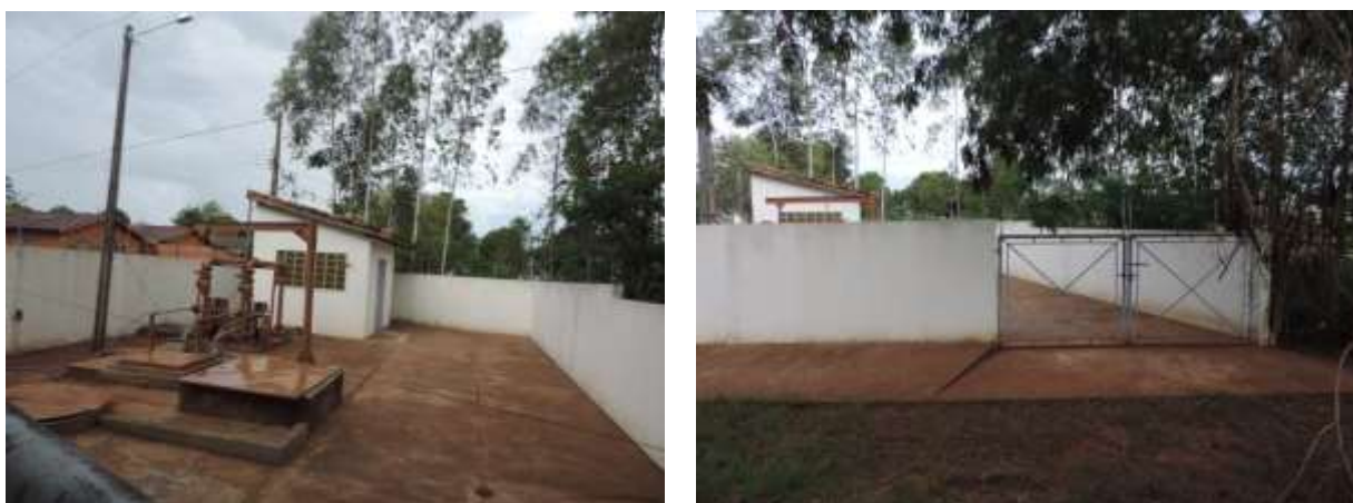
Figura 7: Vista geral da EEEB 002, Naviraí, MS.
