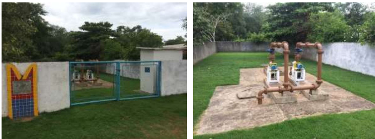
Figura 8: Vista geral da EEEB 002, Miranda, MS.
