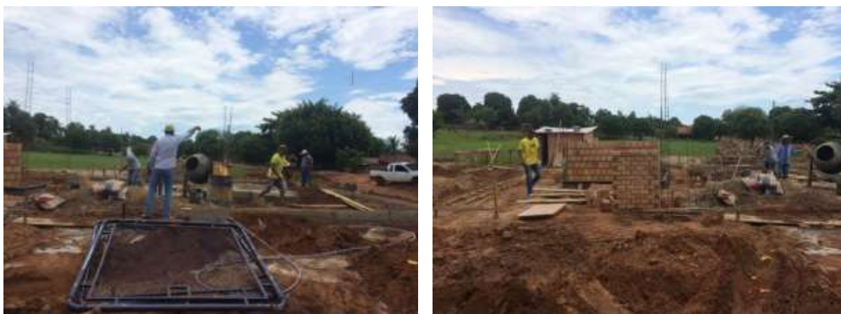
Figura 14: Vista geral da EEEB 009 em implantação, Miranda, MS.
