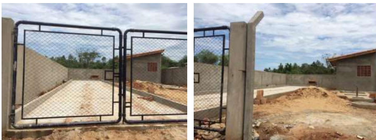
Figura 13: Vista geral da EEEB 12 em implantação, Miranda, MS.
