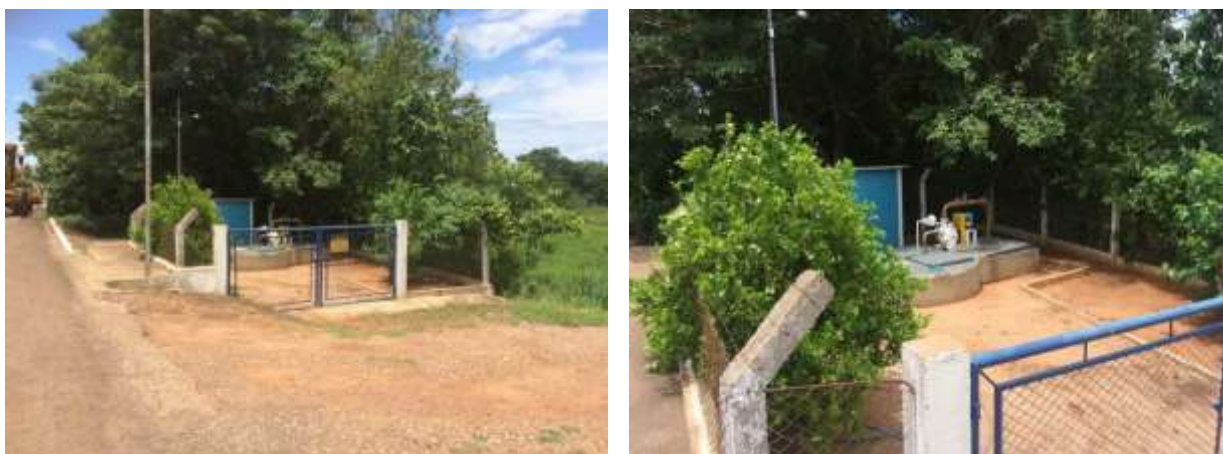
Figura 6: Vista geral da EEEB 004, Miranda, MS.
