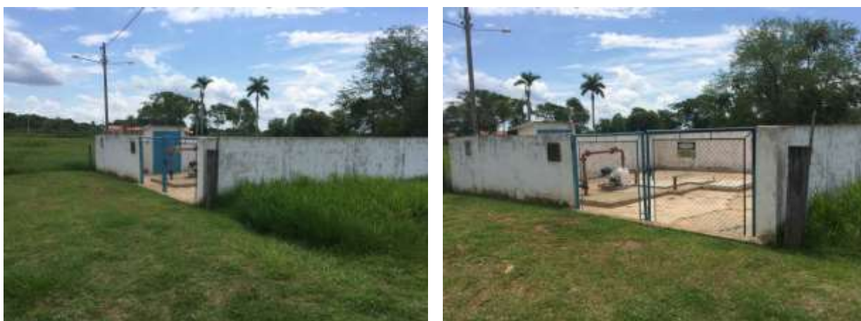
Figura 10: Vista geral da EEEB 005, Miranda, MS.
