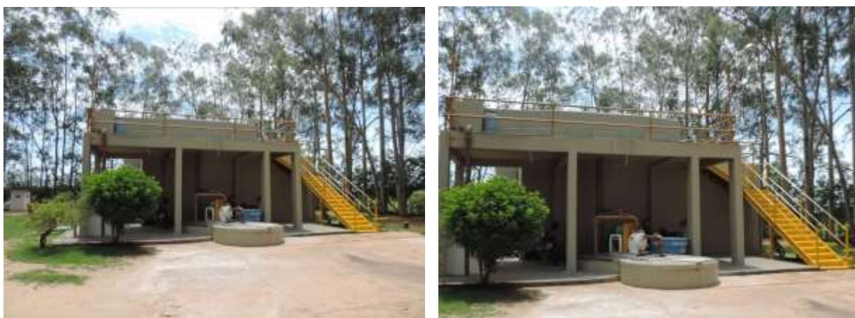
Figura 11: Vista geral da ETE 01, Miranda, MS.
