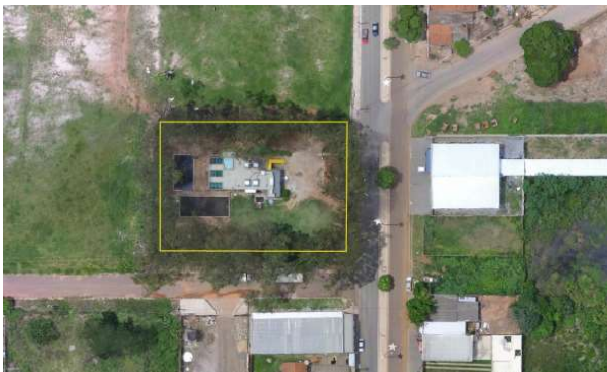
Figura 2: Vista aérea da ETE Miranda, Miranda, MS.
