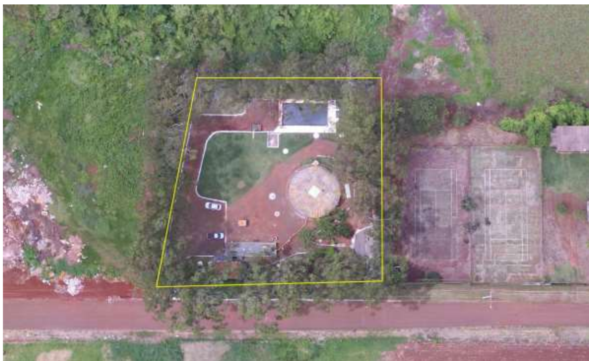
Figura 2: Vista aérea da ETE Maracaju, Maracaju, MS.
