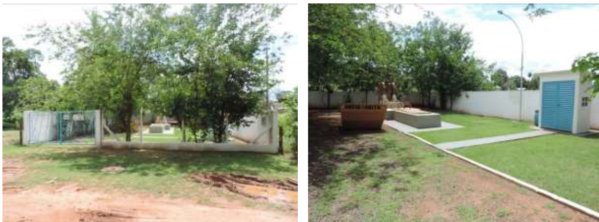
Figura 6: Vista geral da EEEB 002, Anastácio, MS.
