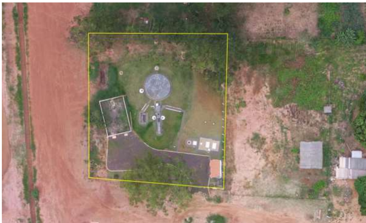
Figura 2: Vista aérea da ETE Juti, Juti, MS.
