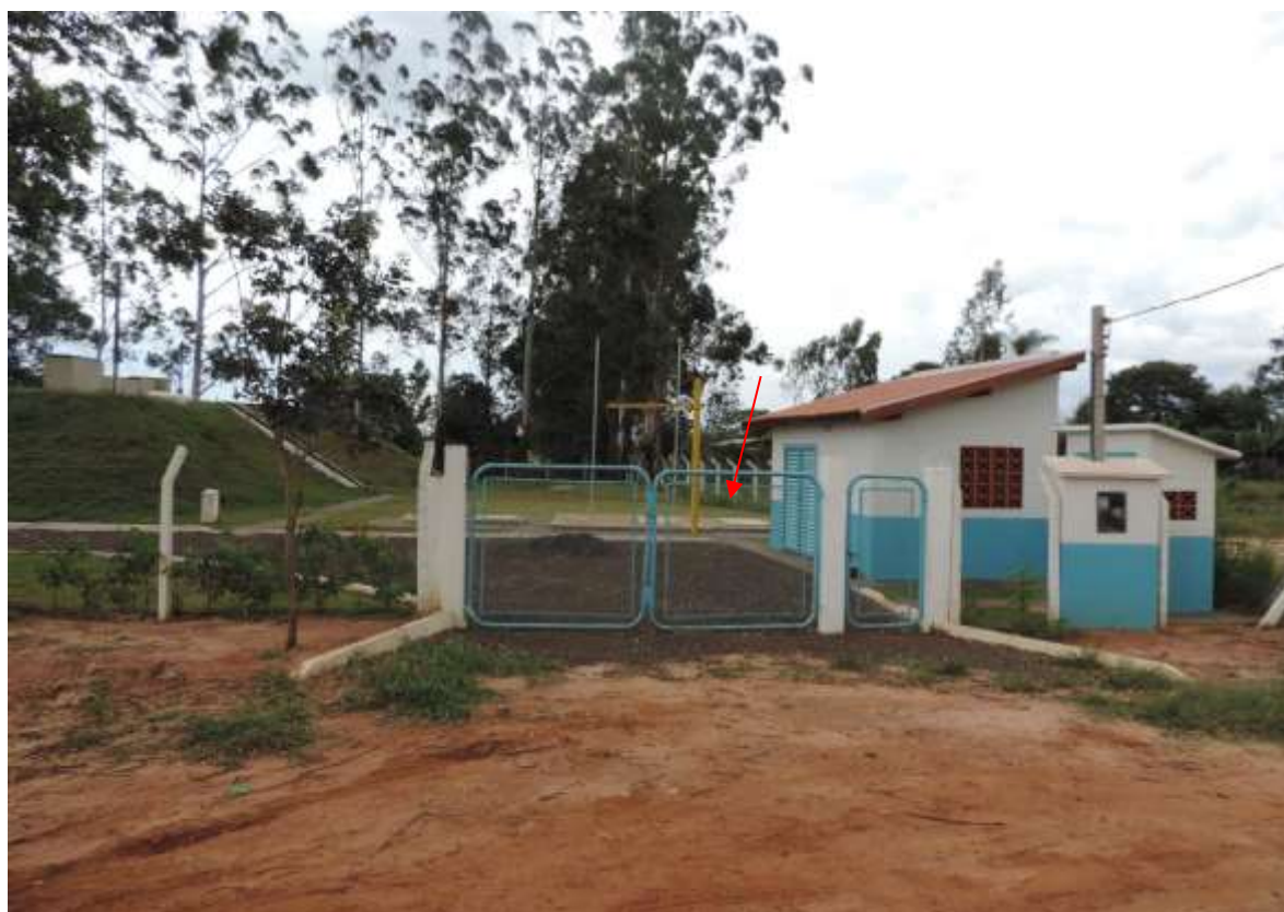
Figura 8: Vista geral da EEET, Juti, MS.
