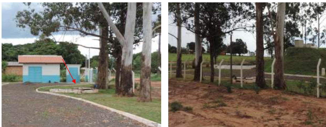
Figura 7: Vista geral da EEEB Final, Juti, MS.
