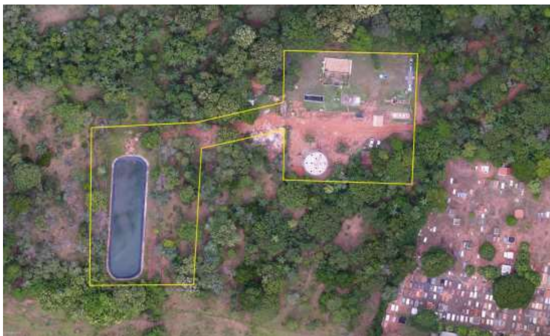
Figura 2: Vista aérea da ETE Jateí em ampliação, Jateí, MS.
