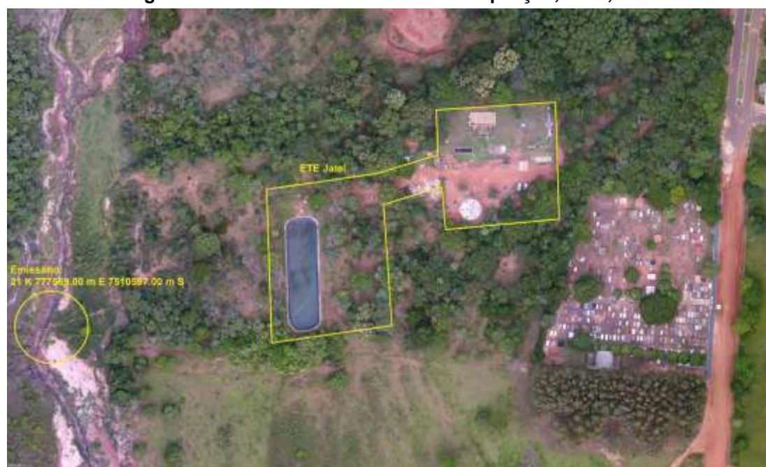
Figura 3: Vista aérea da ETE Jateí em ampliação e entorno, Jateí, MS.
