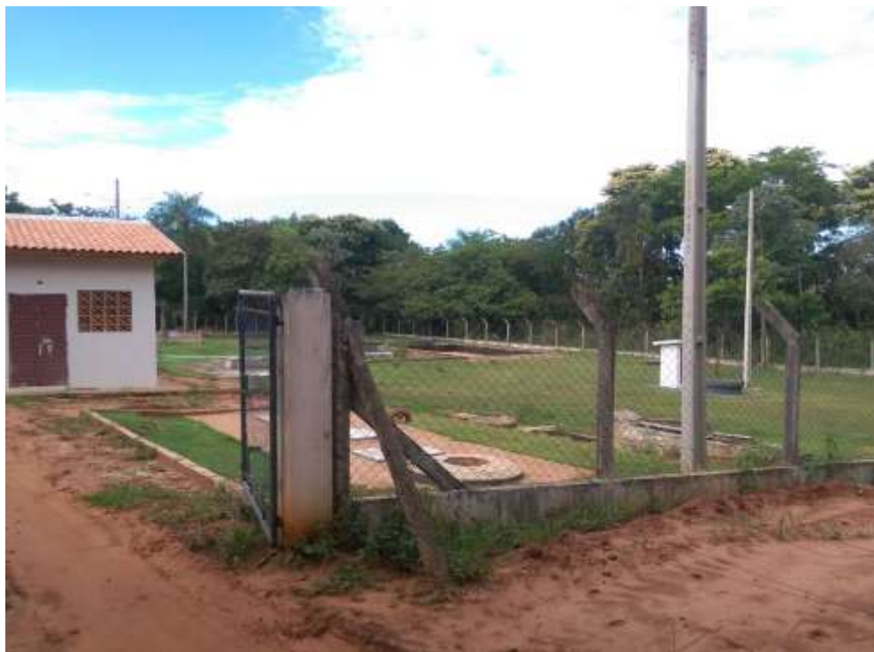
Figura 6: Vista geral da EEEB 002 em implantação, Jateí, MS.
