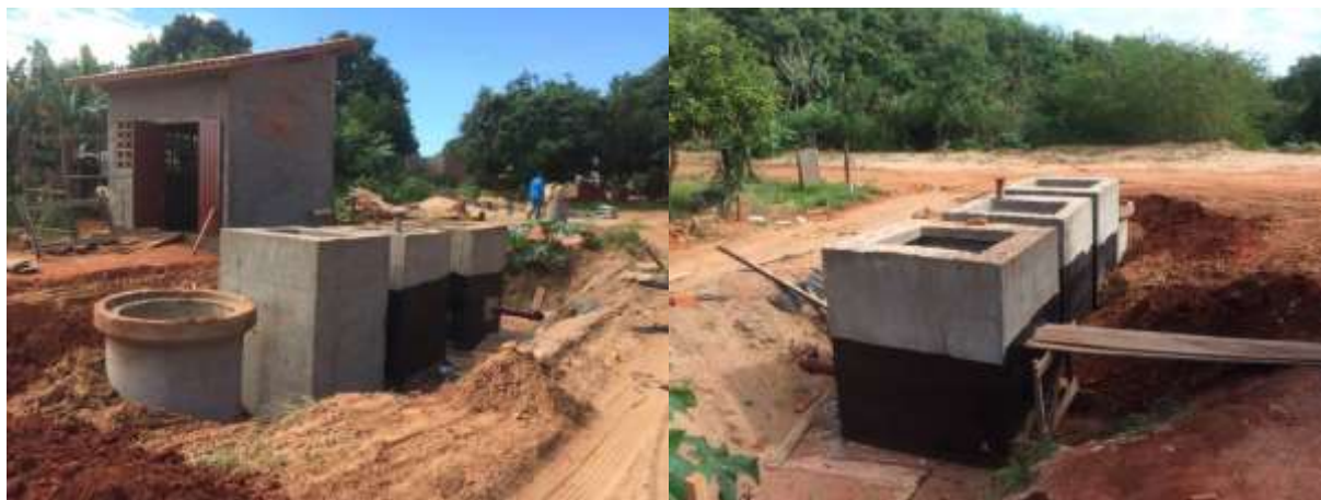
Figura 5: Vista geral da EEEB 001 em implantação, Jateí, MS.
