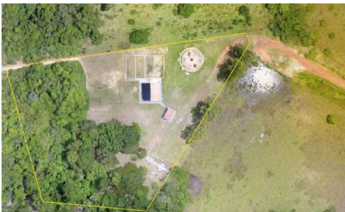
Figura 2: Vista aérea da ETE Cachoeirinha, Jardim, MS.
