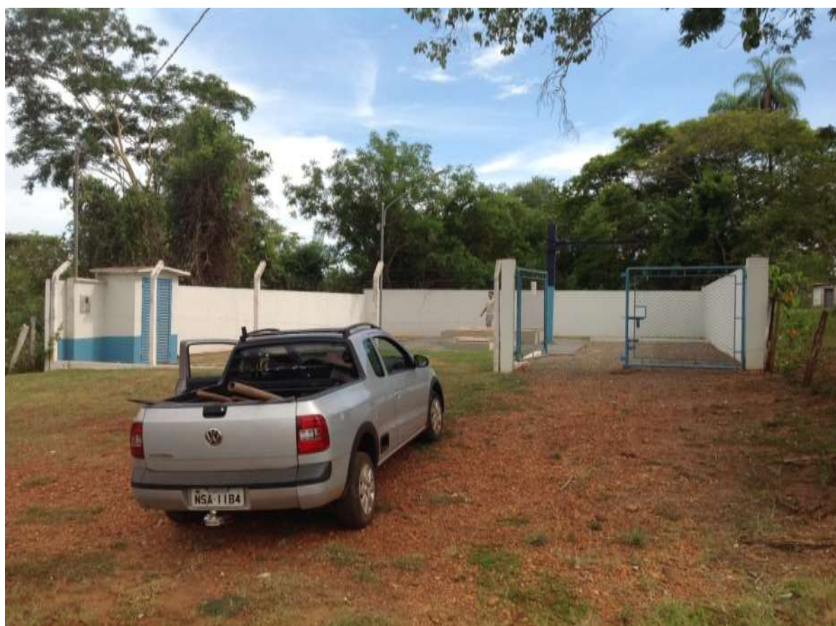
Figura 10: Vista geral da EEEB Centro, Jardim, MS.
