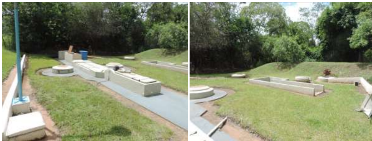
Figura 8: Vista geral da EEEB Cachoeirinha, Jardim, MS.
