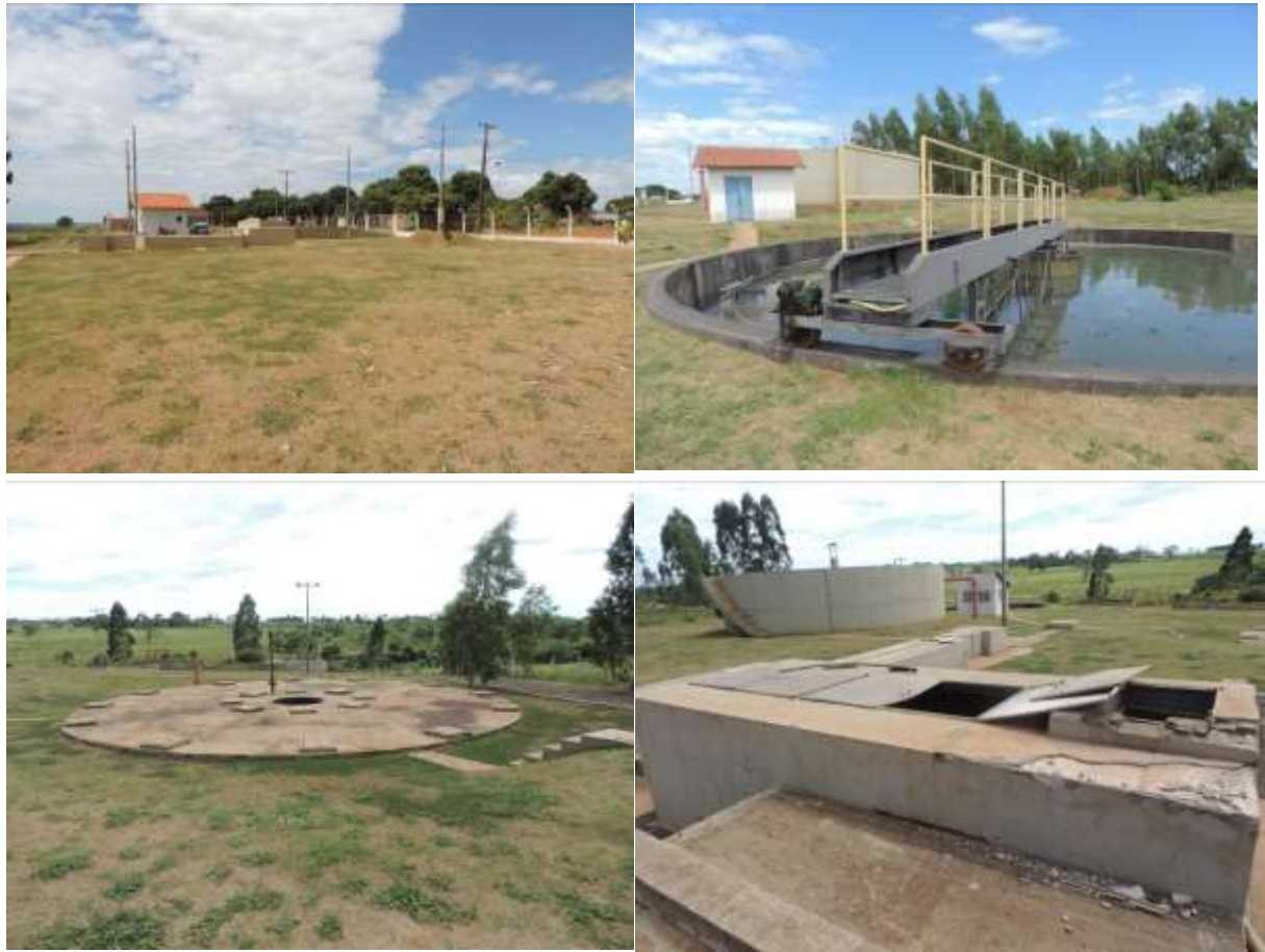
Figura 2: Vista geral da ETE Iguatemi, Iguatemi, MS.
