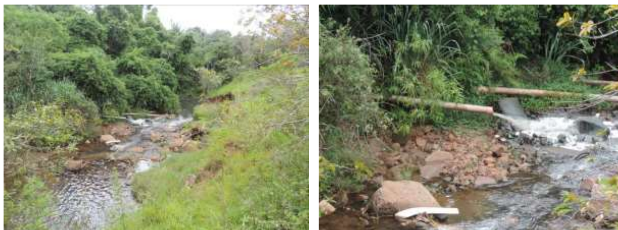
Figura 5: Local de lançamento do emissário da ETE Amambai I, Amambai, MS.
