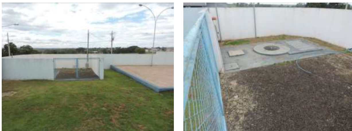
Figura 19: Vista geral da EEEB 006, Amambai, MS.
