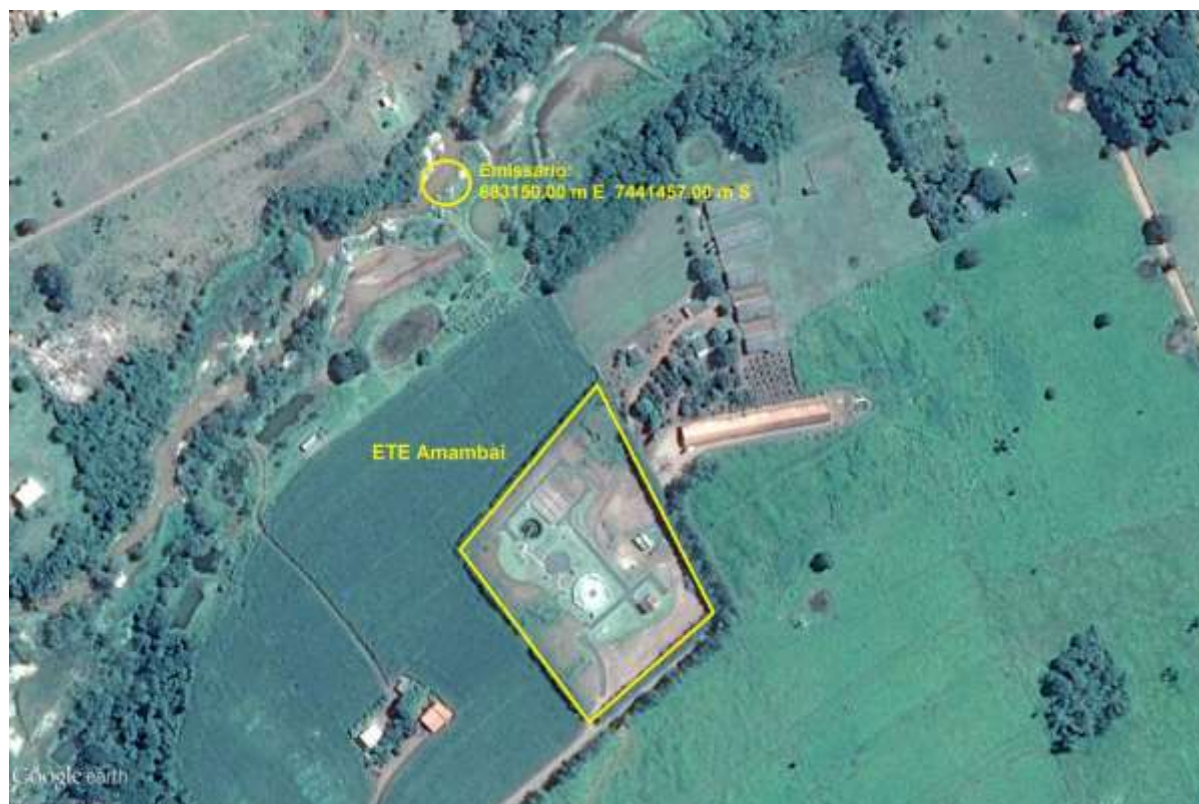
Figura 11: Vista aérea da ETE Amambai e entorno, Amambai, MS.
