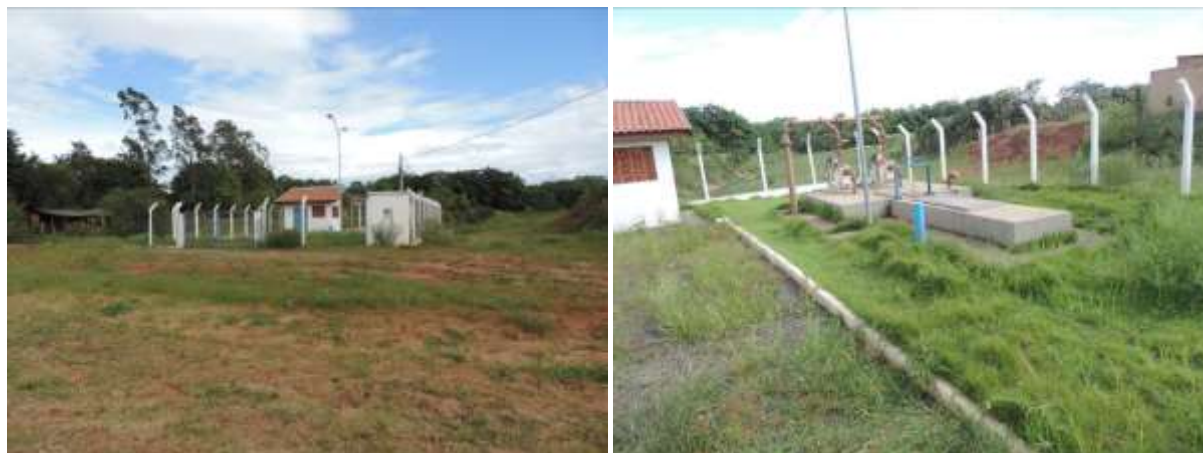
Figura 13: Vista geral da EEEB 002, Amambai, MS.
