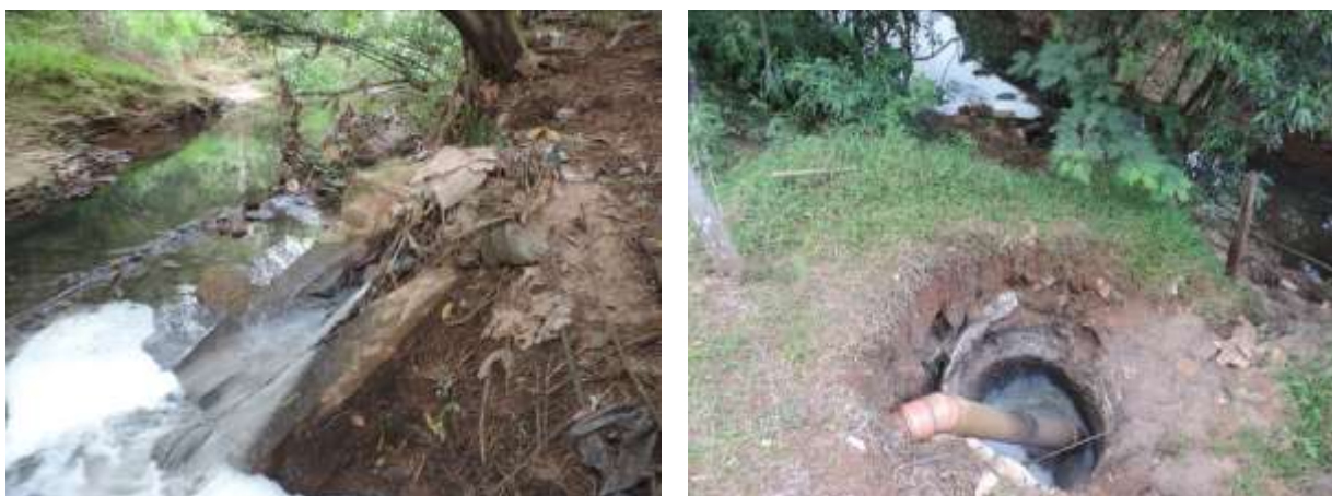
Figura 9: Local de lançamento do emissário da ETE Amambai II.
