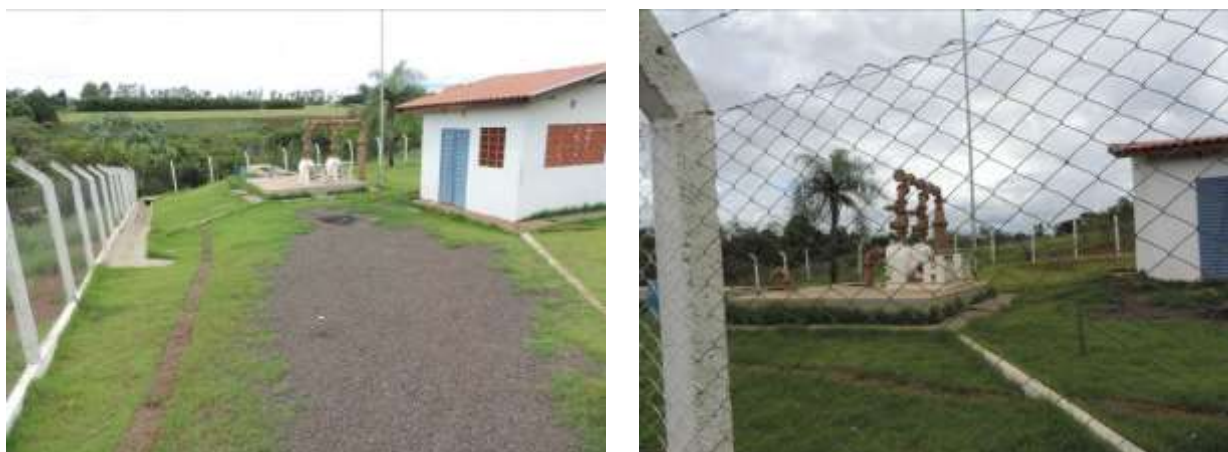
Figura 17: Vista geral da EEEB 005, Amambai, MS.
