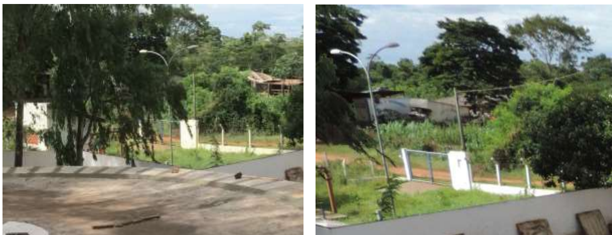
Figura 15: Vista geral da EEEB 003, Amambai, MS.
