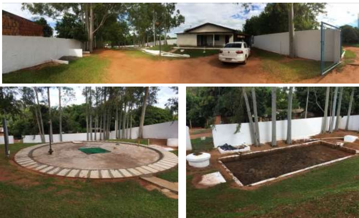
Figura 2: Vista geral da ETE Amambai I, Amambai, MS.
