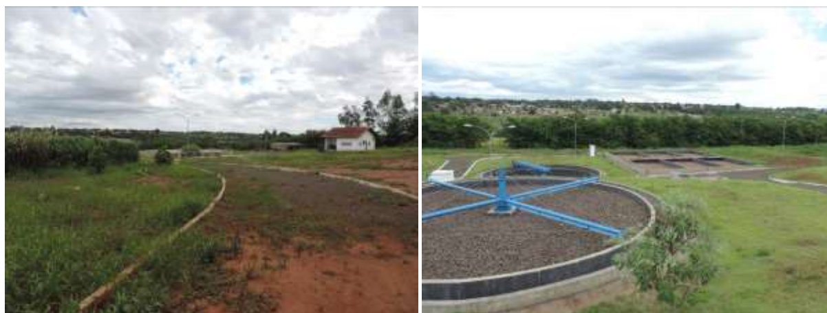
Figura 10: Vista geral da ETE Amambai, Amambai, MS.
