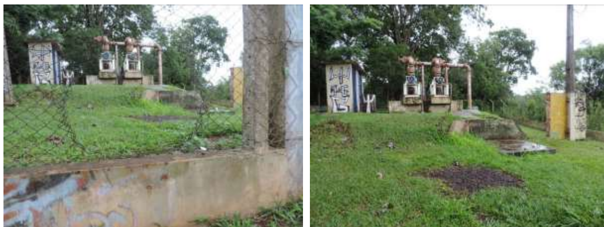
Figura 30: Vista geral da EEEB Portal de Dourados, Dourados, MS.
