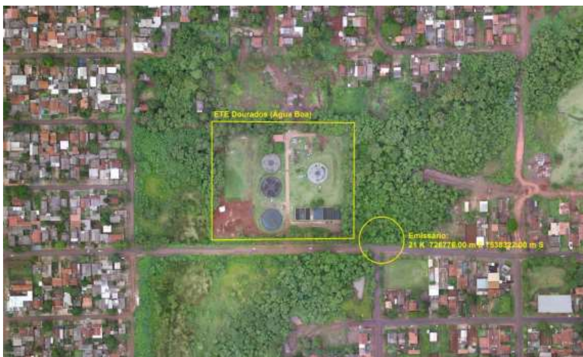
Figura 4: Vista aérea da ETE Água Boa e entorno, Dourados, MS.
