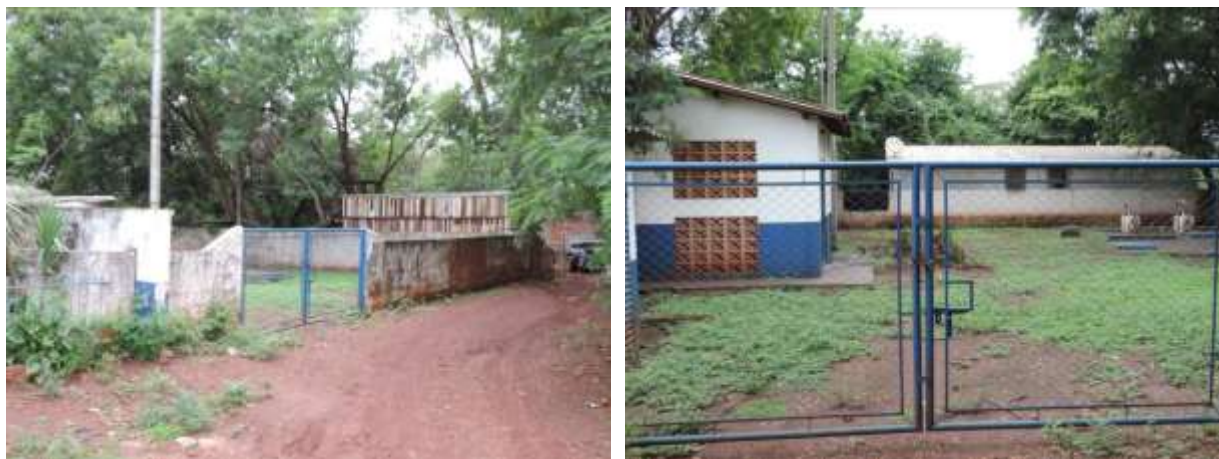
Figura 21: Vista geral da EEEB Campo Dourado, Dourados, MS.
