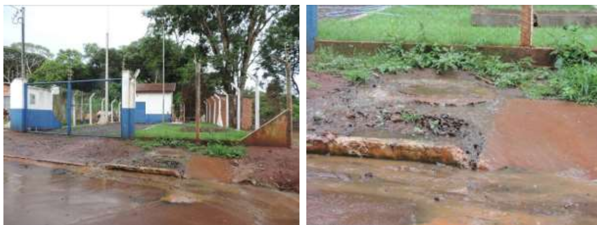
Figura 24: Alagamento ETEB Estrela Porã, Dourados, MS.
