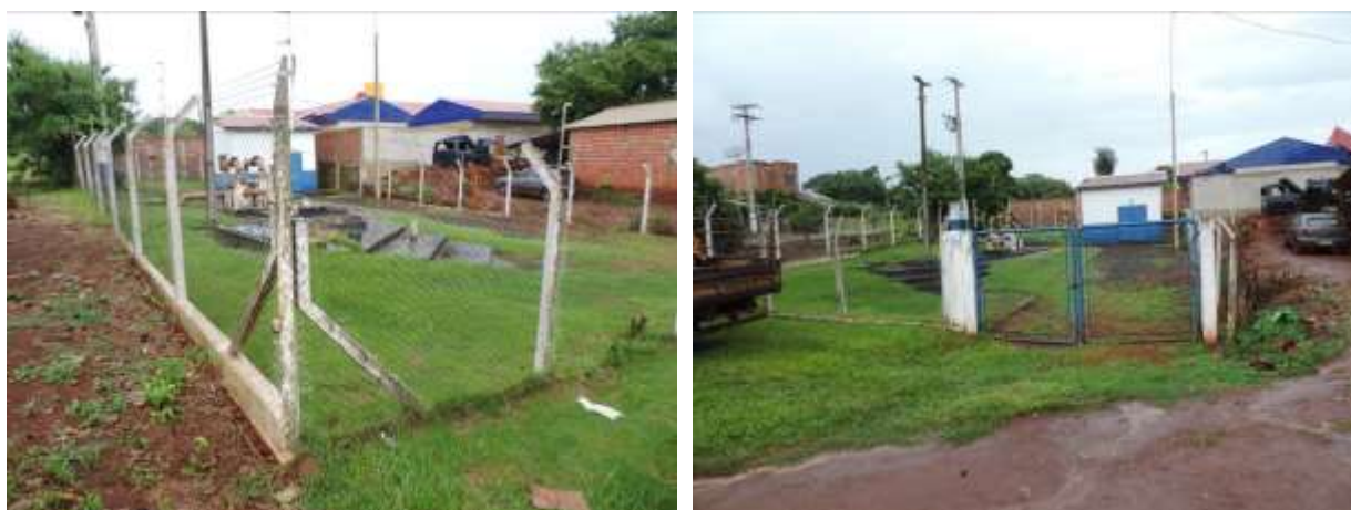
Figura 29: Vista geral da EEEB Olinda Pires, Dourados, MS.
