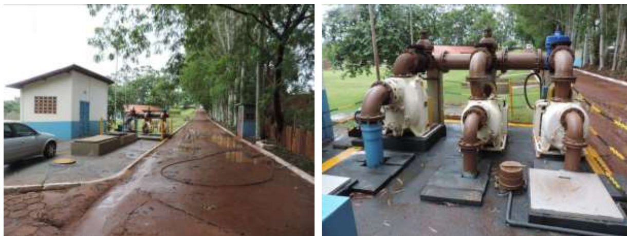
Figura 25: Vista geral da EEB Guaxinim, Dourados, MS.
