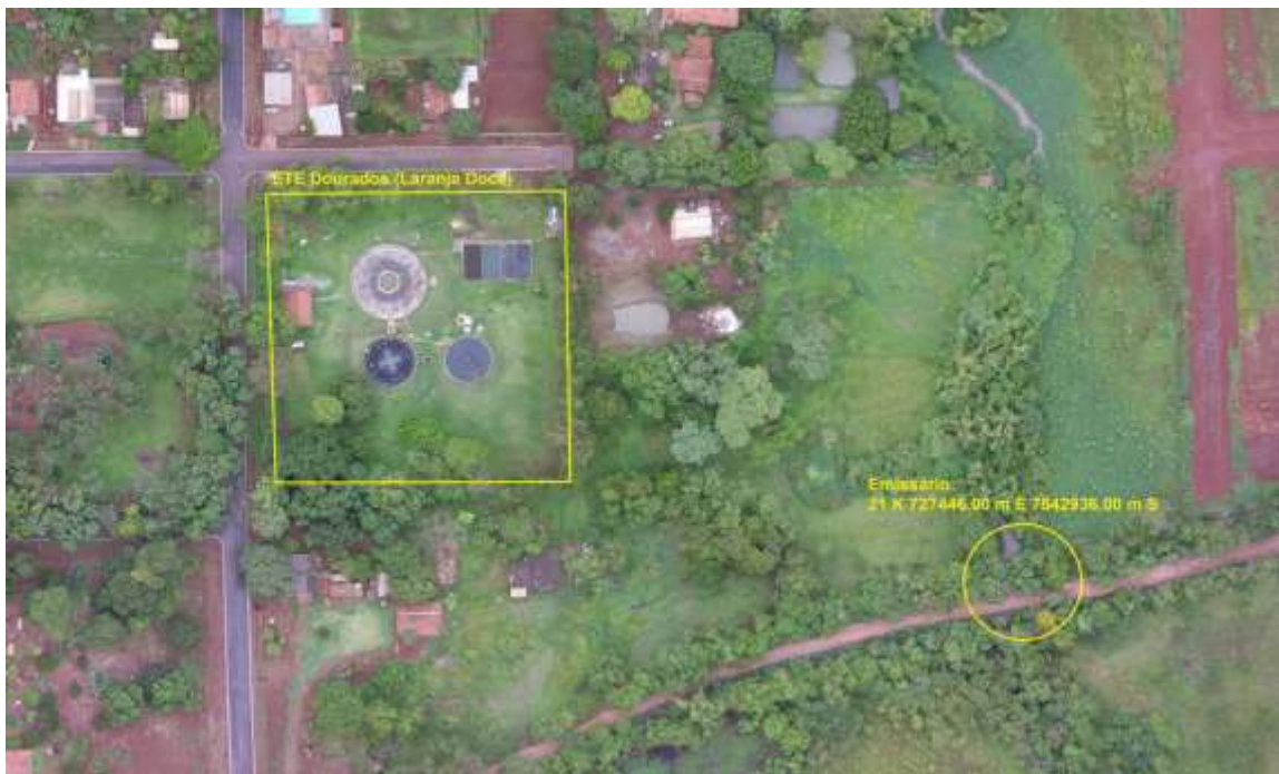
Figura 13: Vista aérea da ETE Laranja Doce e entorno, Dourados, MS.
