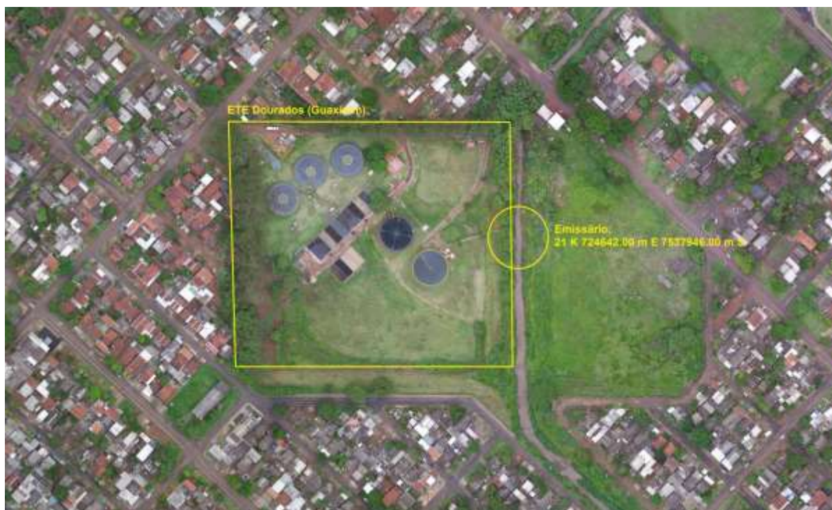
Figura 7: Vista aérea da ETE Guaxinim e entorno, Dourados, MS.
