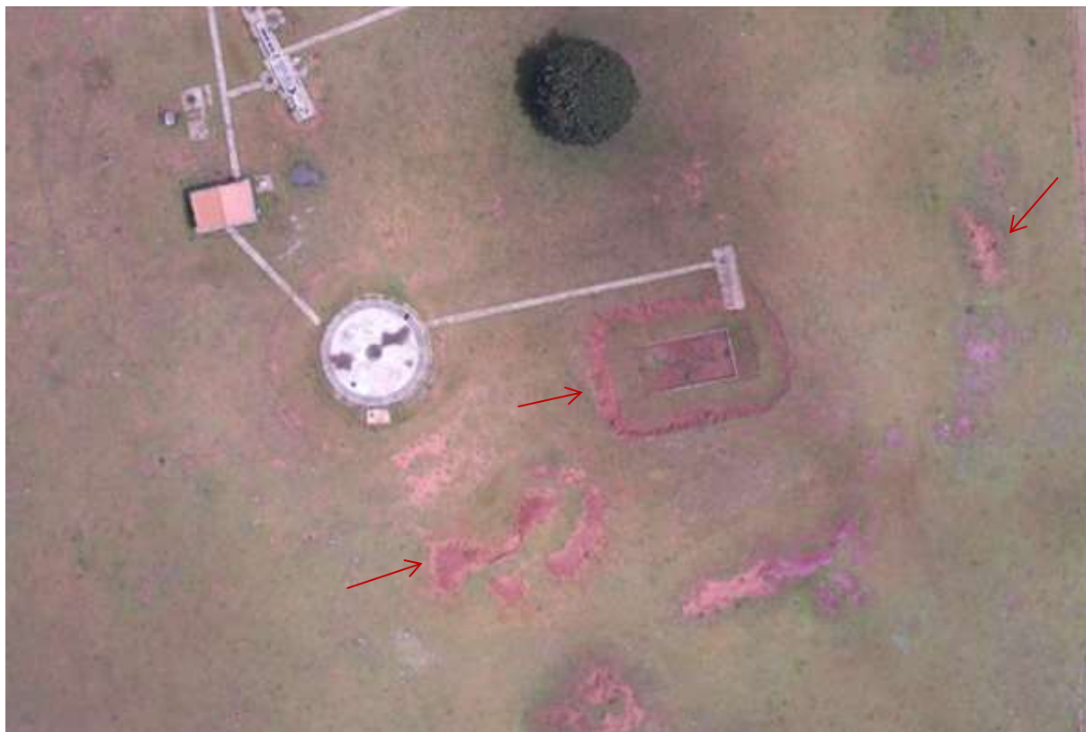
Figura 5: Solo exposto e início de processo erosivo no talude do leito de secagem na área da ETE Dois Irmãos do Buriti, Dois Irmãos do Buriti, MS.
