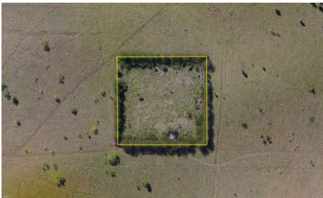
Figura 2: Vista aérea da ETE Deodápolis, Deodápolis, MS.
