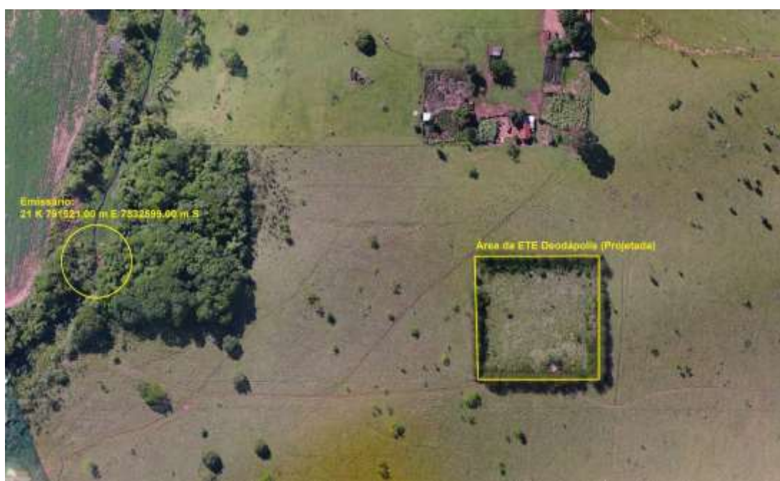
Figura 3: Vista aérea da ETE Deodápolis e entorno, Deodápolis, MS.
