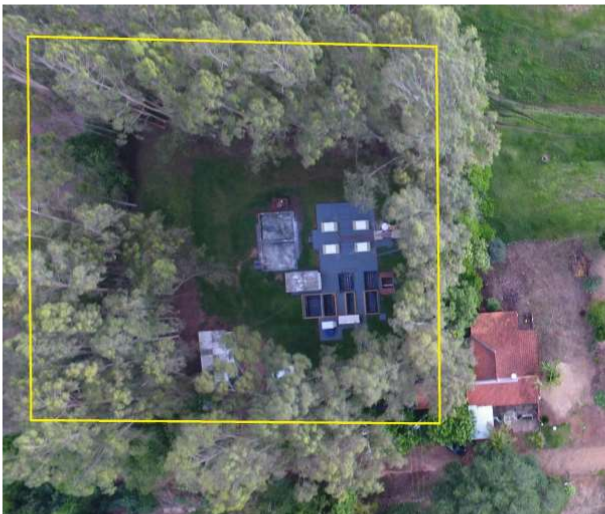
Figura 2: Vista aérea da ETE Camapuã, Camapuã, MS.
