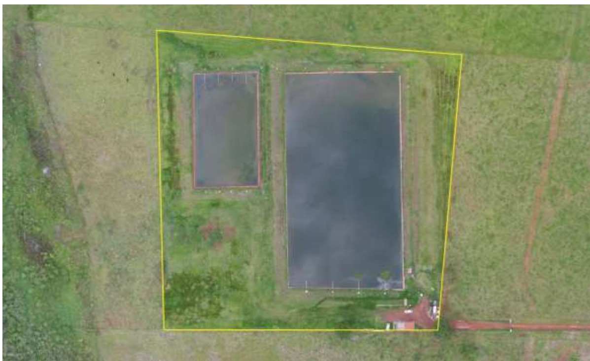
Figura 2: Vista aérea da ETE Caarapó, Caarapó, MS.
