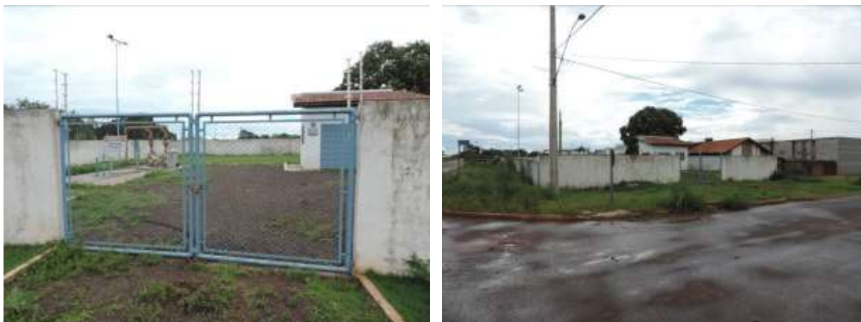
Figura 6: Vista geral da EEEB 002, Caarapó, MS.
