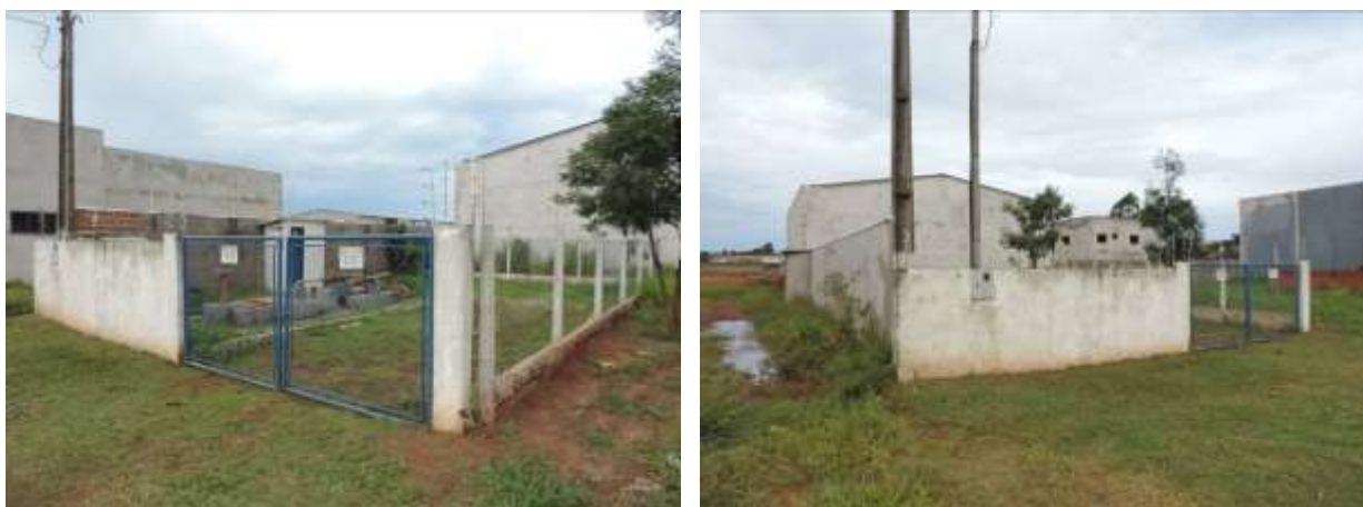
Figura 5: Vista geral da EEEB 001, Caarapó, MS.
