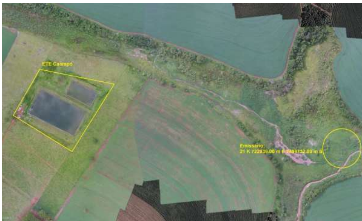
Figura 3: Vista aérea da ETE Caarapó e entorno, Caarapó, MS.
