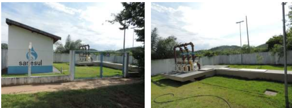
Figura 7: Vista geral da EEEB 003, Bodoquena, MS.
