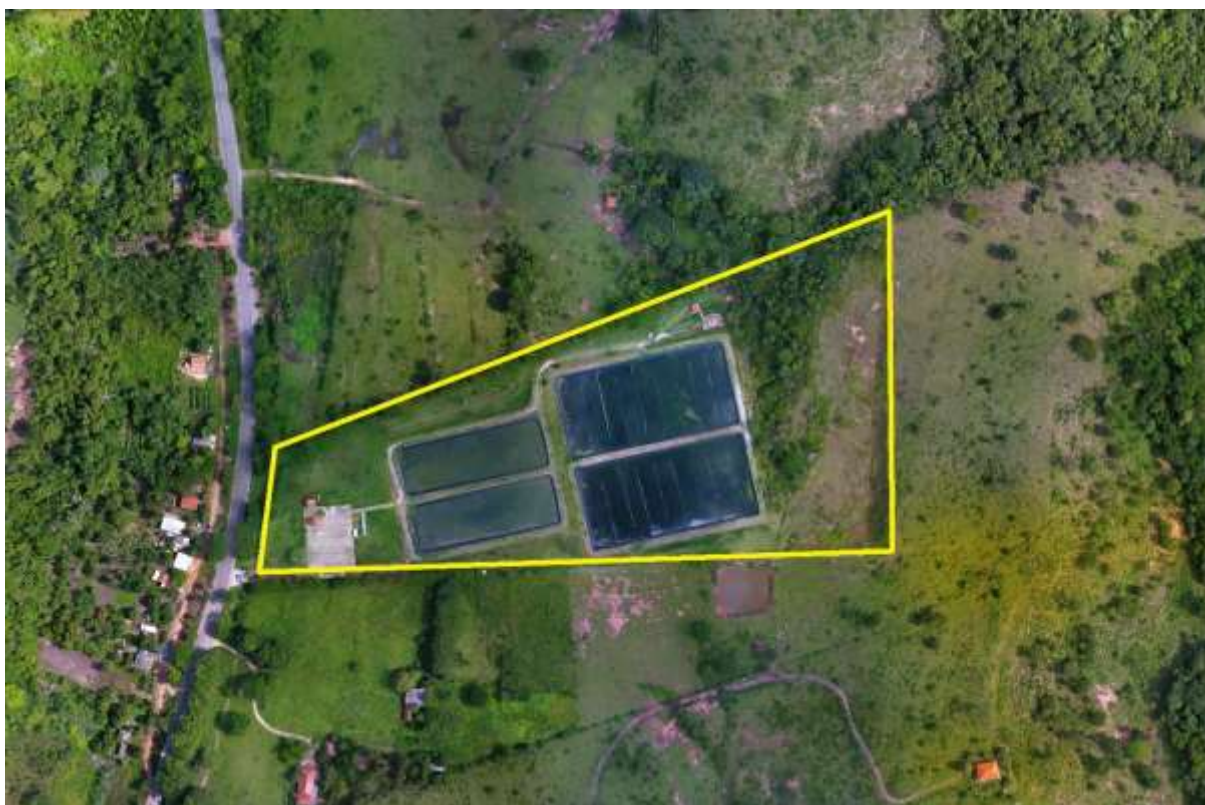
Figura 2: Vista aérea da ETE Bodoquena, Bodoquena, MS.
