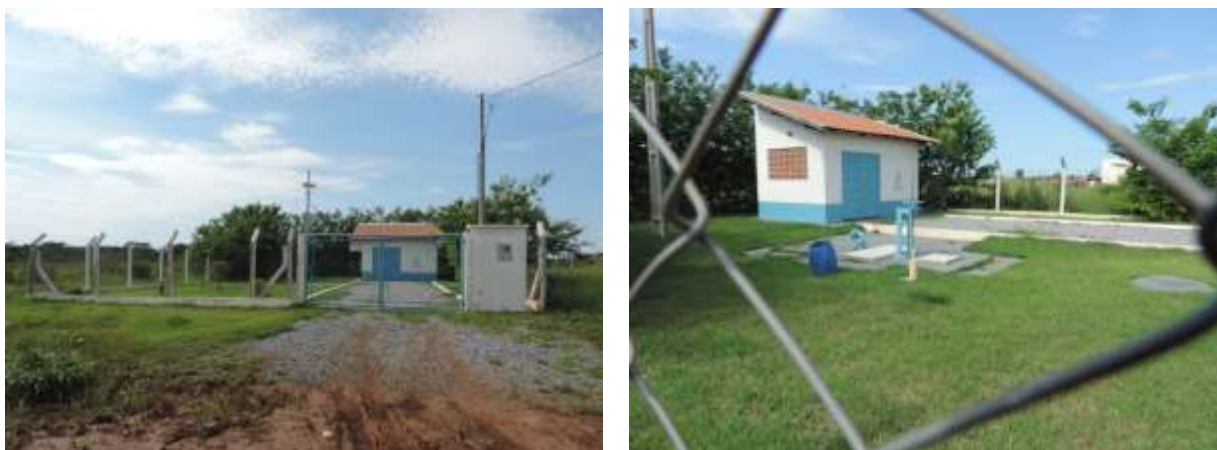
Figura 8: Vista geral da EEEB 004, Bodoquena, MS.
