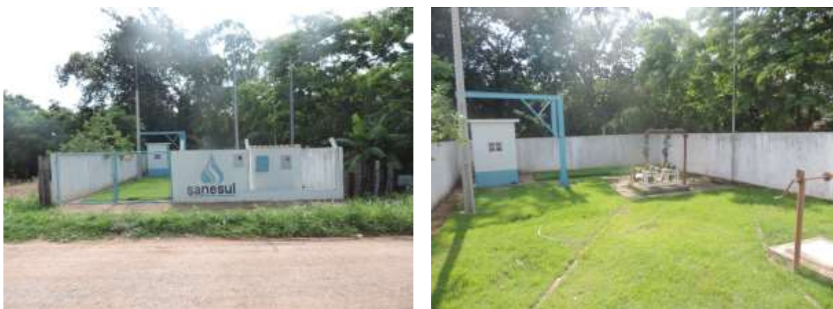
Figura 6: Vista geral da EEEB 002, Bodoquena, MS.
