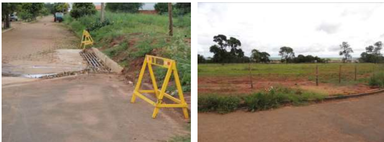
Figura 7: Vista geral da área prevista para a EEEB 005 Projetada, Bataguassu, MS.
