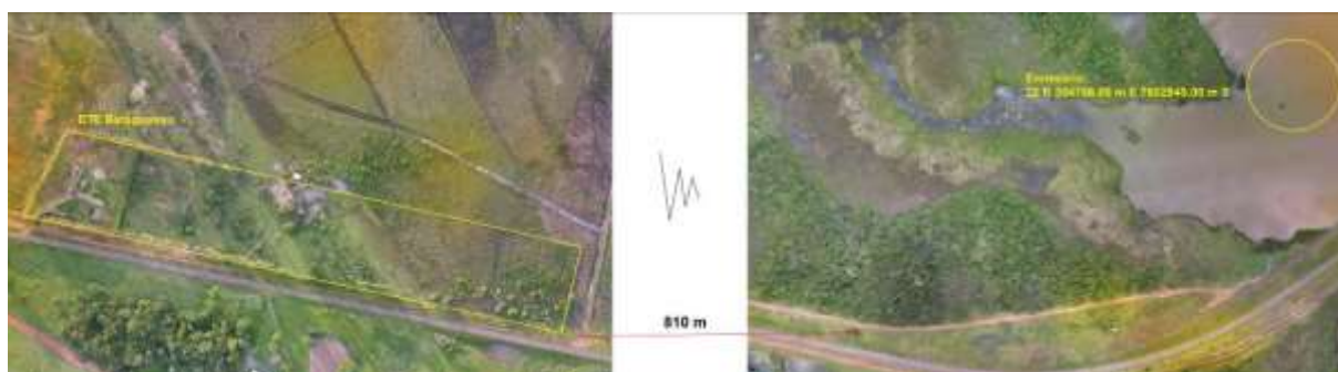
Figura 3: Vista aérea da ETE Bataguassu e entorno, Bataguassu, MS.
