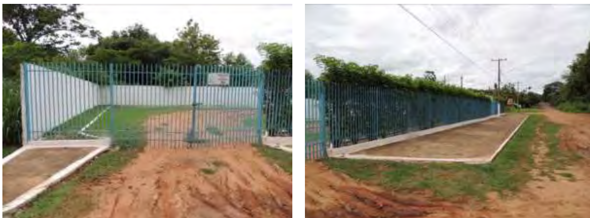
Figura 5: Vista geral da ETEB 001, Aquidauana, MS.
