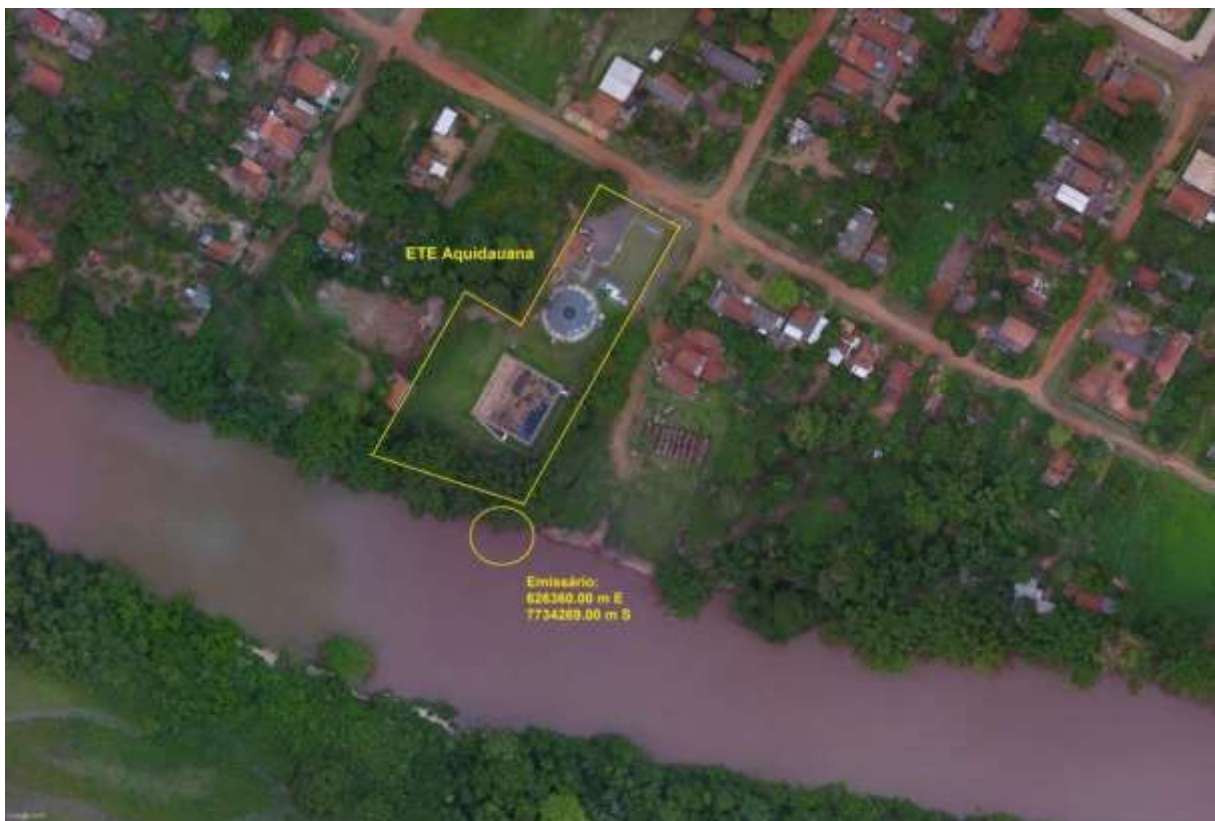
Figura 3: Vista aérea da ETE Aquidauana e entorno, Aquidauana, MS.
