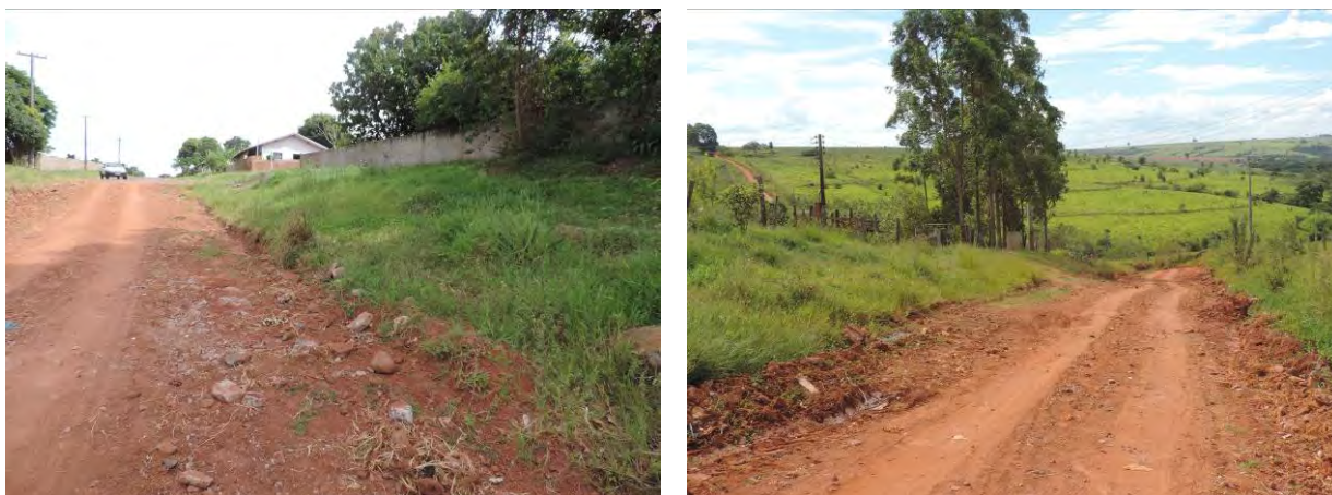
Figura 7: Área prevista para implantação da EEEB 004 Projetada, Sete Quedas, MS.
