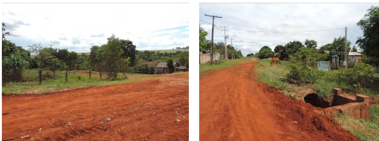
Figura 8: Área prevista para implantação da EEEB 005 Projetada, Sete Quedas, MS.
