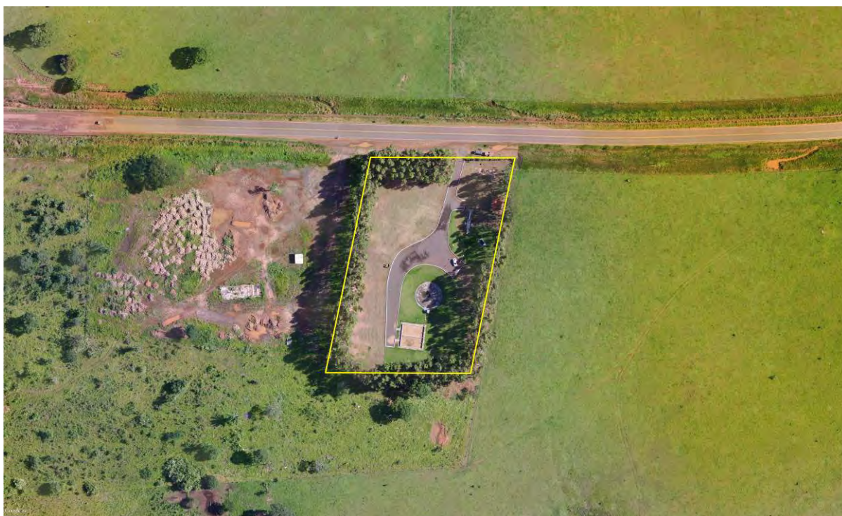
Figura 2: Vista aérea da ETE Santa Rita do Pardo, Santa Rita do Pardo, MS.
