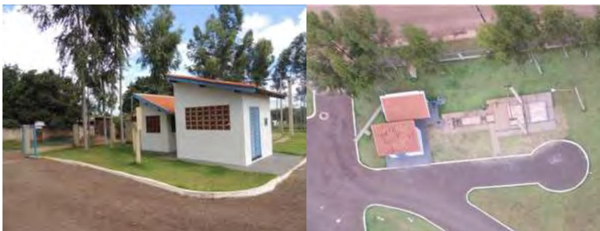
Figura 6: Vista geral da EEEB Final, Ribas do Rio Pardo, MS.
