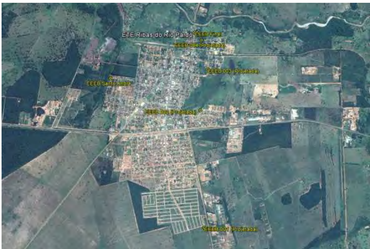
Figura 1: Localização das Unidades Operacionais existentes e projetadas na cidade de Ribas do Rio Pardo, MS.
