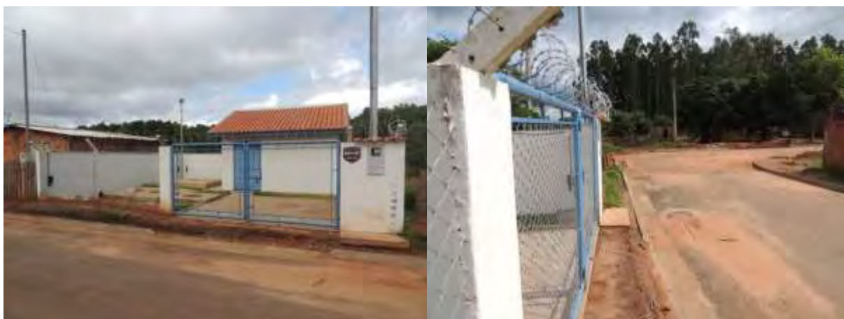
Figura 5: Vista geral da EEEB Santo André, Ribas do Rio Pardo, MS.
