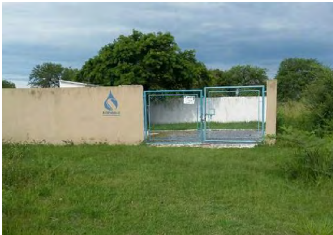
Figura 12: Vista geral da EEEB 007, Porto Murtinho, MS.
