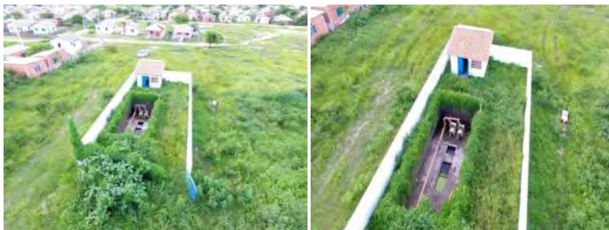
Figura 13: Vista geral da EEEB 008, Porto Murtinho, MS.
