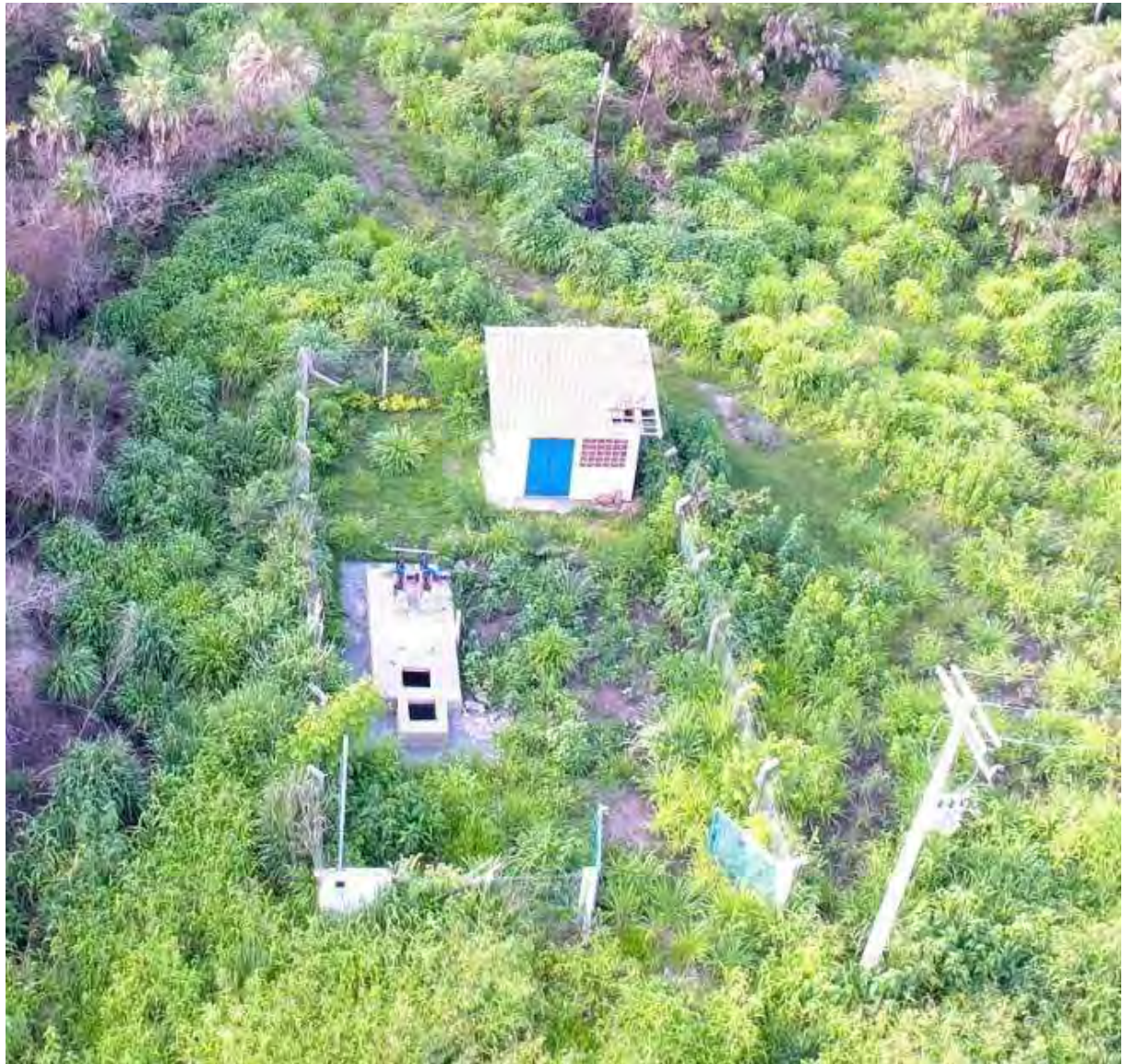
Figura 14: Vista geral da EEEB 009, Porto Murtinho, MS.
