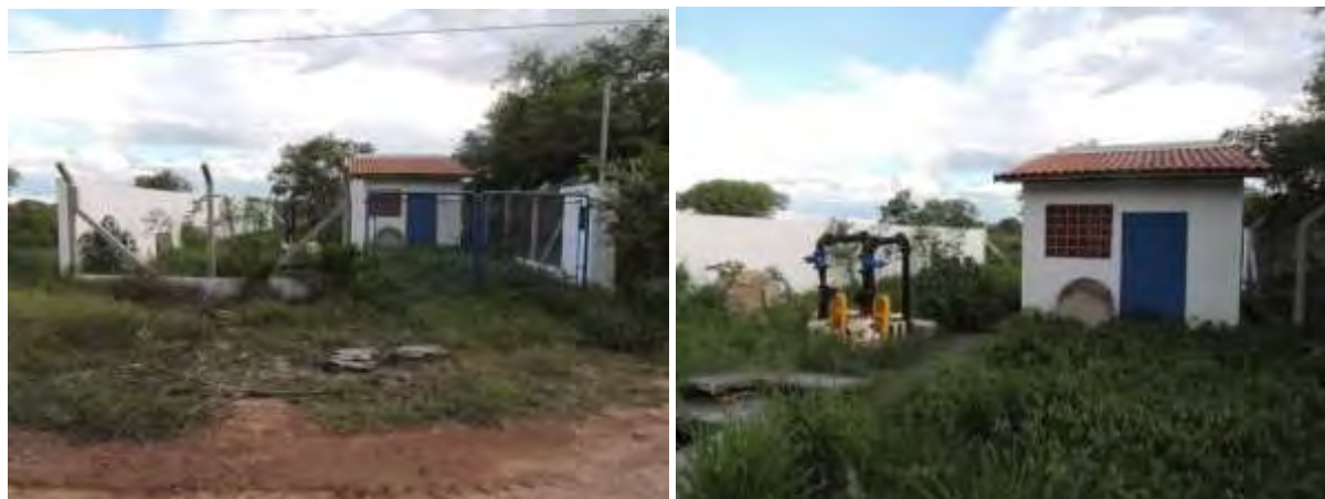
Figura 15: Vista geral da EEEB 010, Porto Murtinho, MS.
