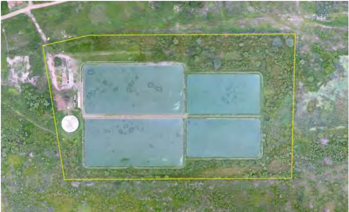
Figura 2: Vista aérea da ETE Porto Murinho, Porto Murinho, MS.
