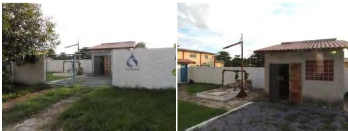
Figura 7: Vista geral da EEEB 002, Porto Murtinho, MS.
