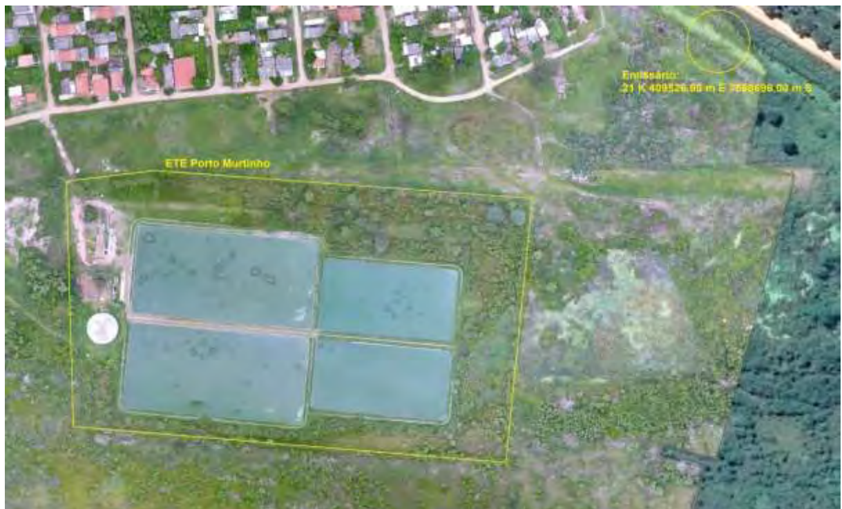
Figura 3: Vista aérea da ETE Porto Murinho e entorno, Porto Murinho, MS.
