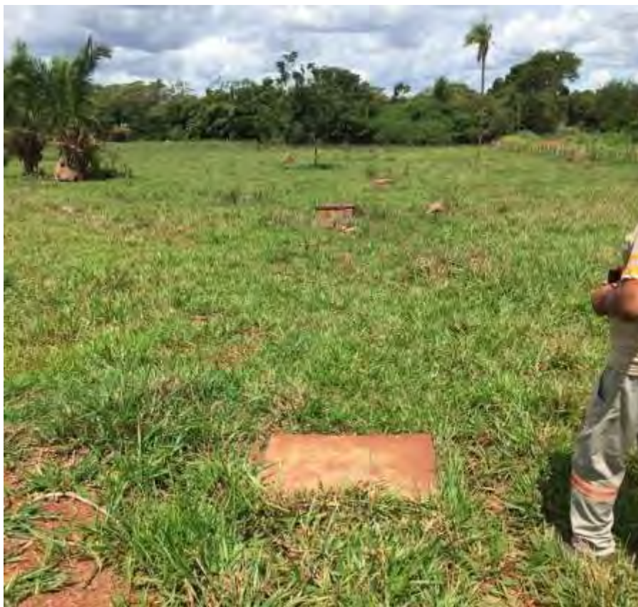
Figura 5: Vista da área da ETE Pedro Gomes II – Tanque Séptico, Pedro Gomes, MS.
