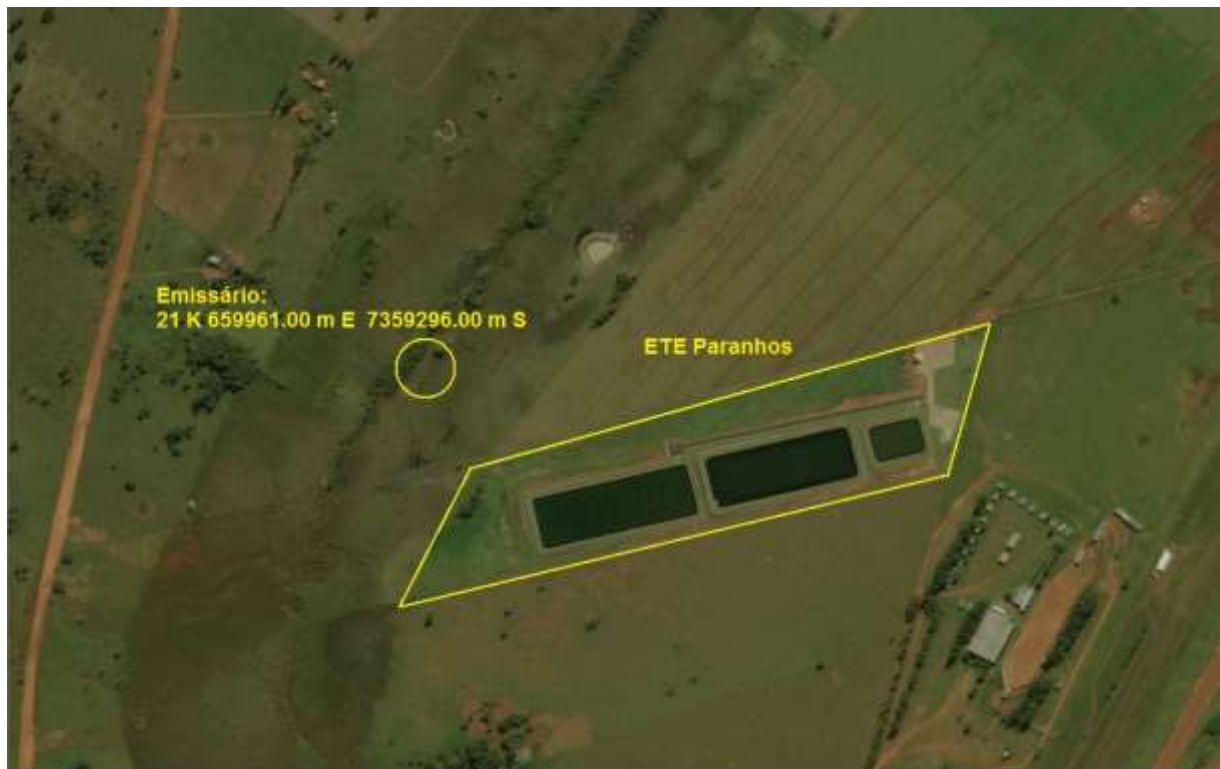
Figura 3: Vista aérea da ETE Paranhos e entorno, Paranhos, MS.
