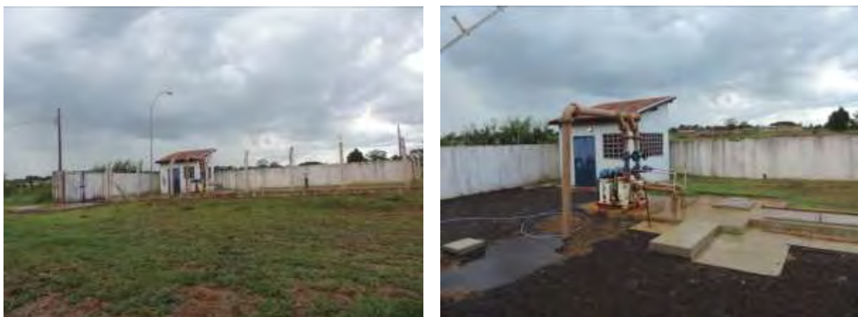
Figura 5: Vista geral da EEEB 003, Paranhos, MS.
