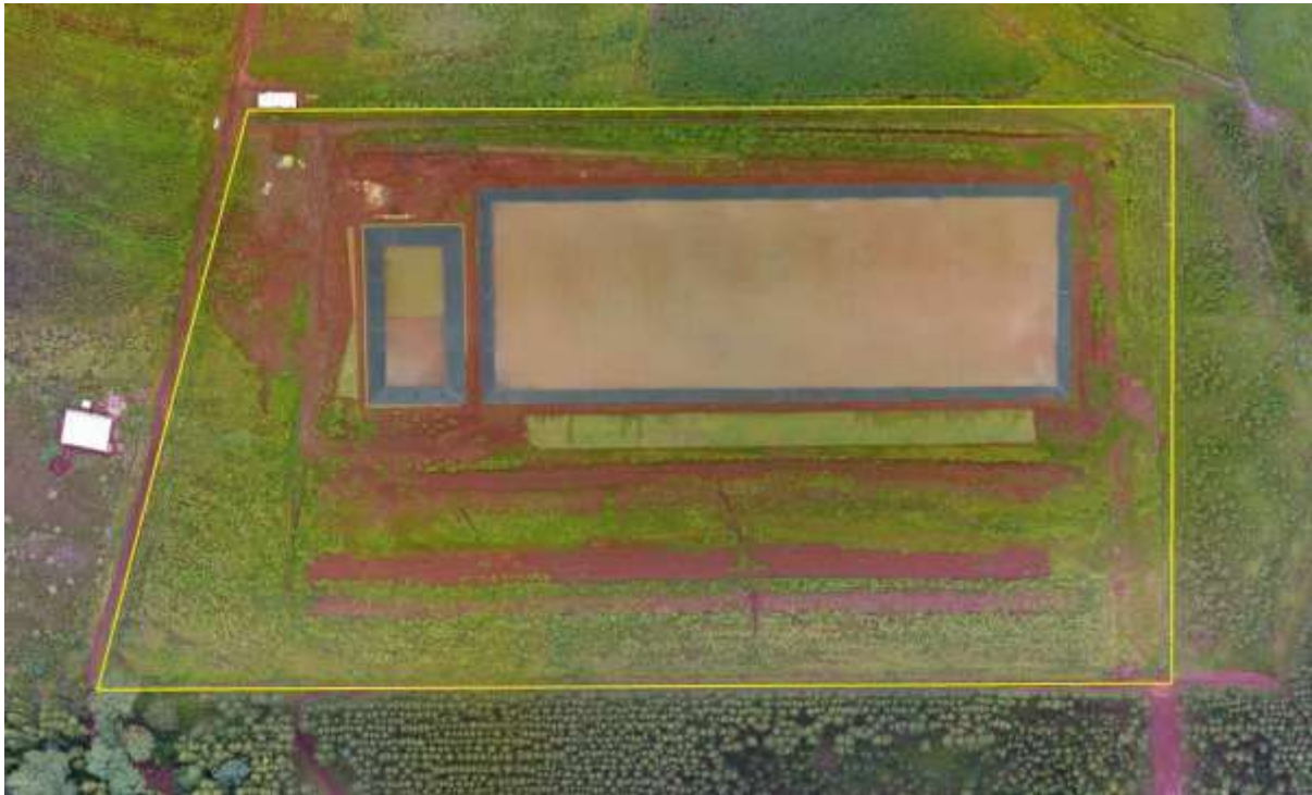
Figura 2: Vista aérea da ETE Nova Alvorada do Sul em implantação, Nova Alvorada do Sul, MS.
