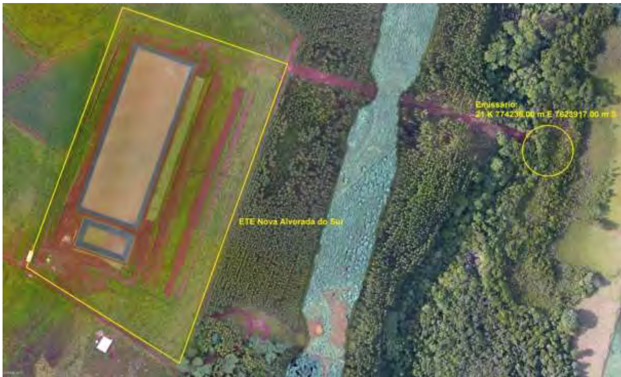
Figura 3: Vista aérea da ETE Nova Alvorada do Sul em implantação e entorno, Nova Alvorada do Sul, MS.
