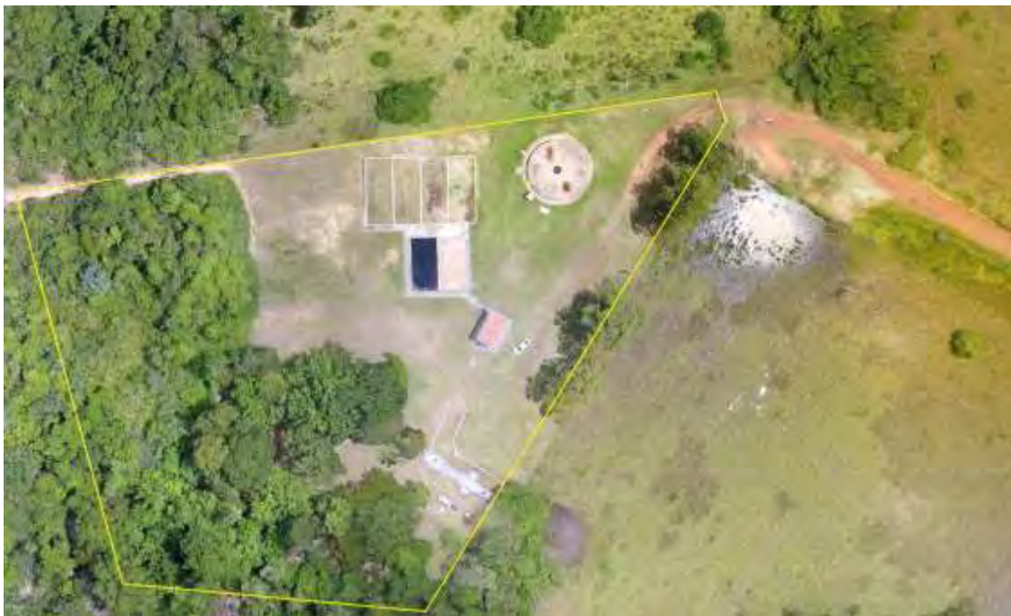
Figura 2: Vista aérea da ETE Cachoeirinha, Jardim, MS.
