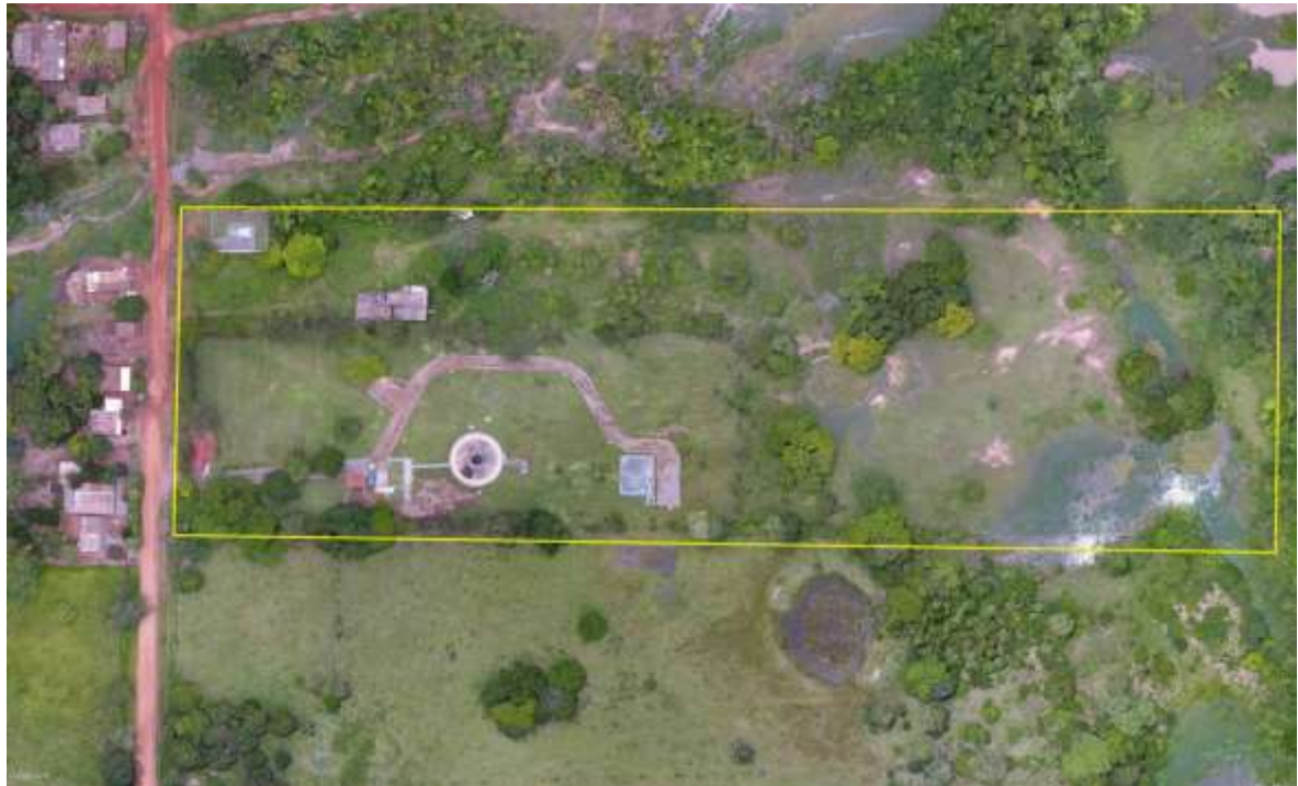
Figura 5: Vista aérea da ETE Centro, Jardim, MS.
