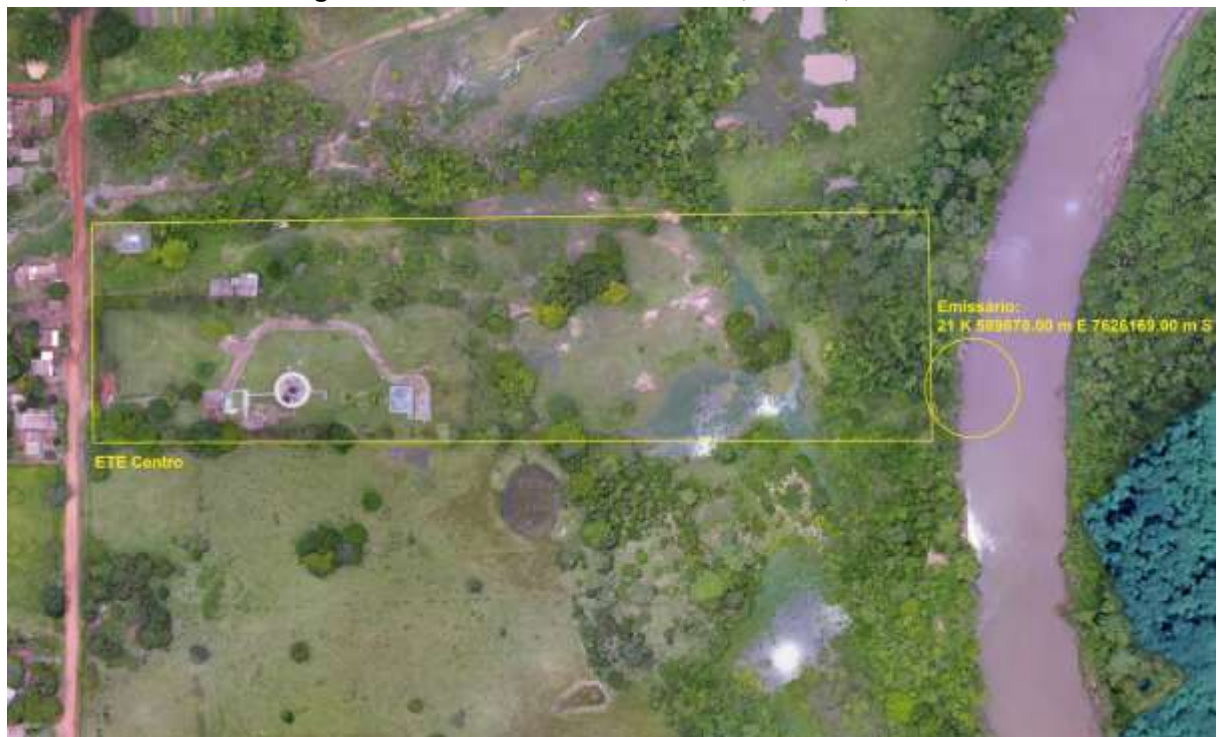
Figura 6: Vista aérea da ETE Centro e entorno, Jardim, MS.
