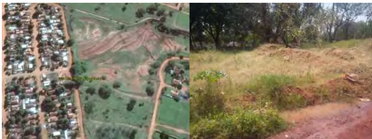
Figura 6: Vista geral da EEEB 002 Projetada, Ivinhema, MS.
