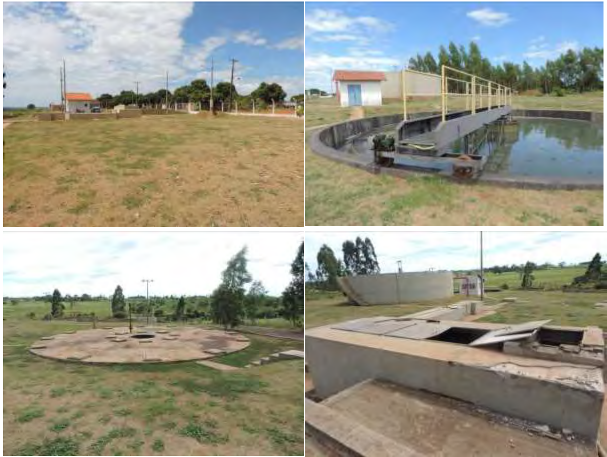
Figura 2: Vista geral da ETE Iguatemi, Iguatemi, MS.
