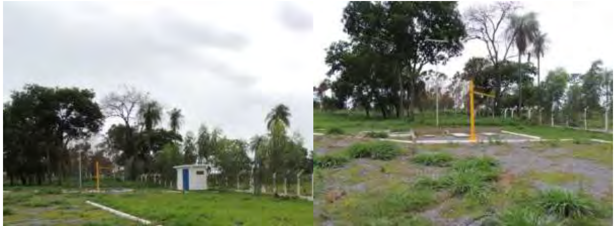
Figura 6: Vista geral da EEEB Final, Guia Lopes da Laguna, MS.
